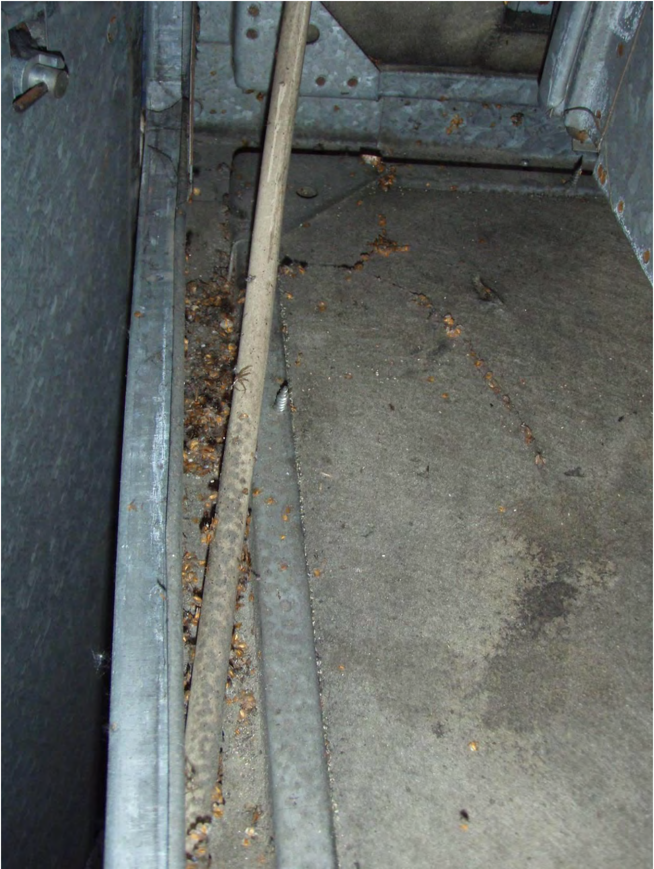
KUVA 12. Puhallinkammioissa esiintyy epäpuhtauksia ja kolhiintuneita mineraalivillapintoja.
