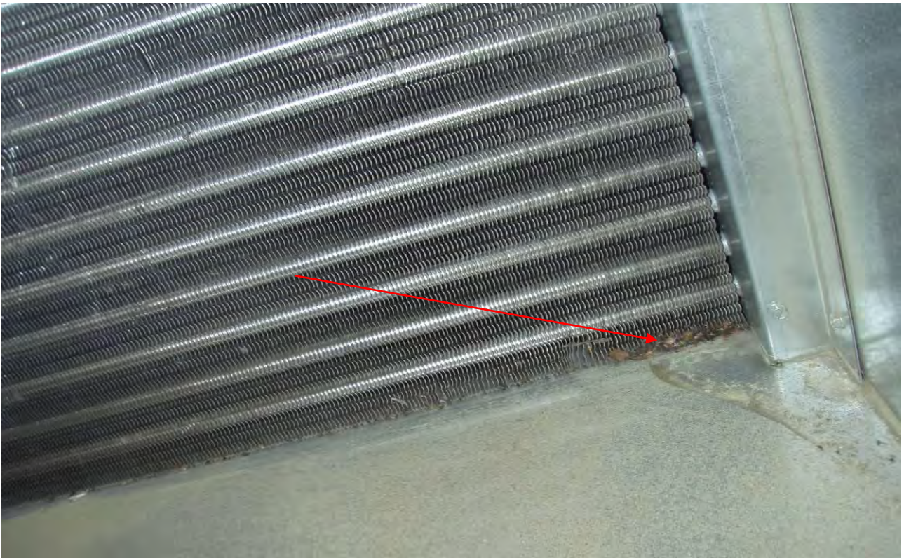
KUVA 16. TK1/01 koneen lämmityspatterissa on epäpuhtauksia, mikä johtuu suodattimien ohivirtauksesta.
