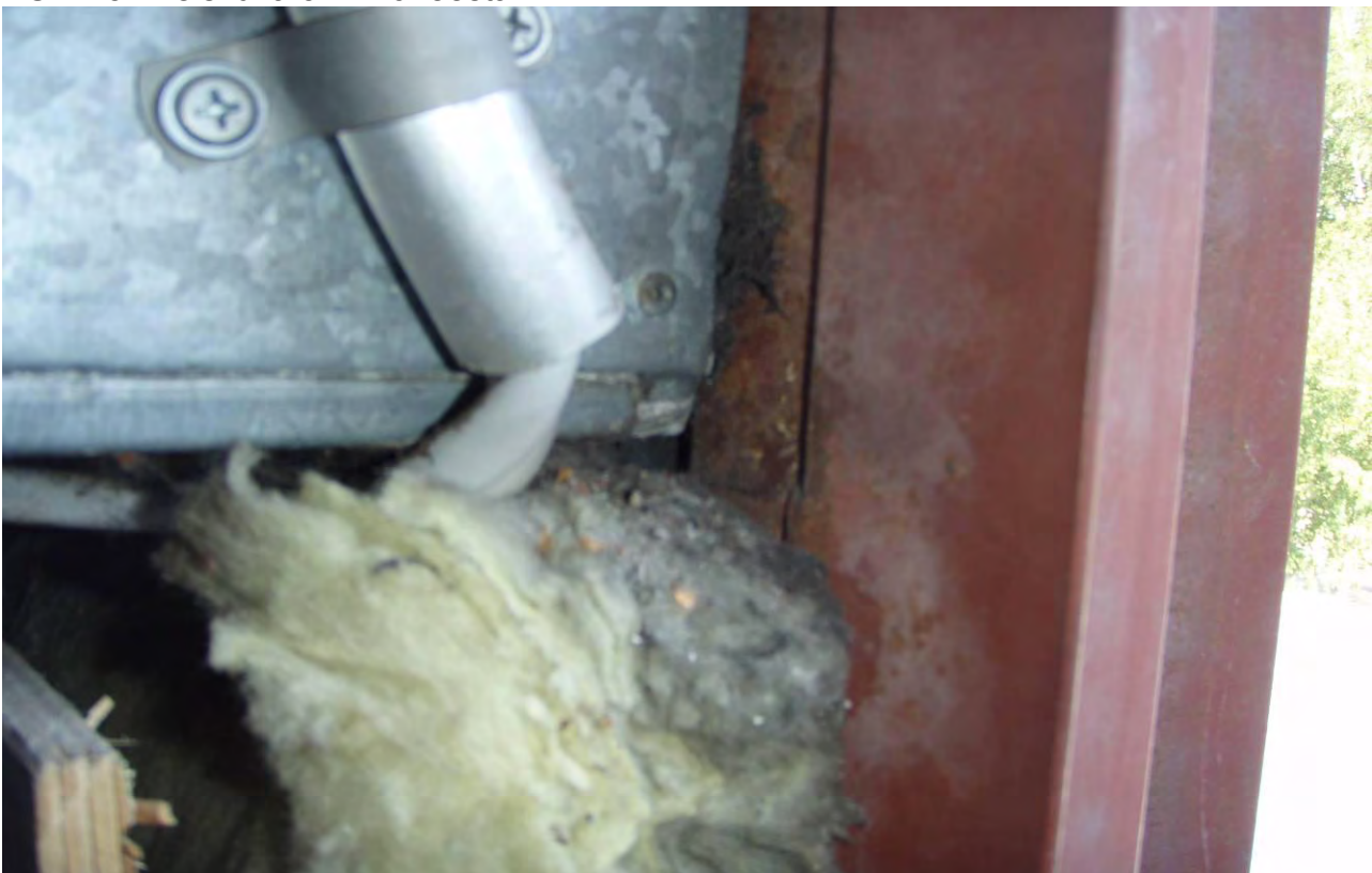
KUVA 6. 5TK koneen ulkosäleikkö ei ole tiivisti kiinni koneessa, minkä seurauksena kone ottaa osan raittiista ilmasta konehuoneesta.
