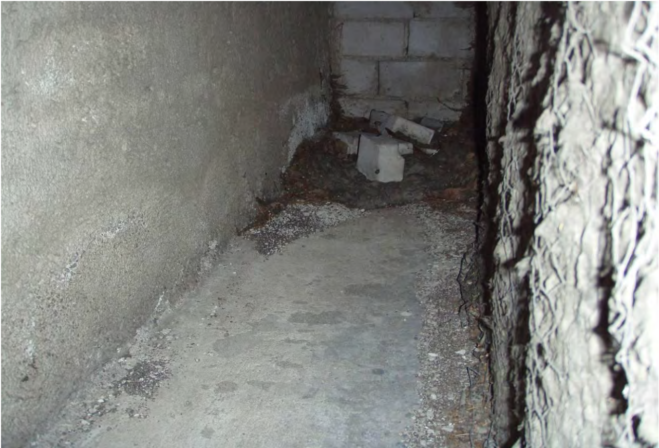
KUVA 19. TK1/01 konetta palvelevassa raitisilmakammiossa esiintyy epäpuhtauksia.
