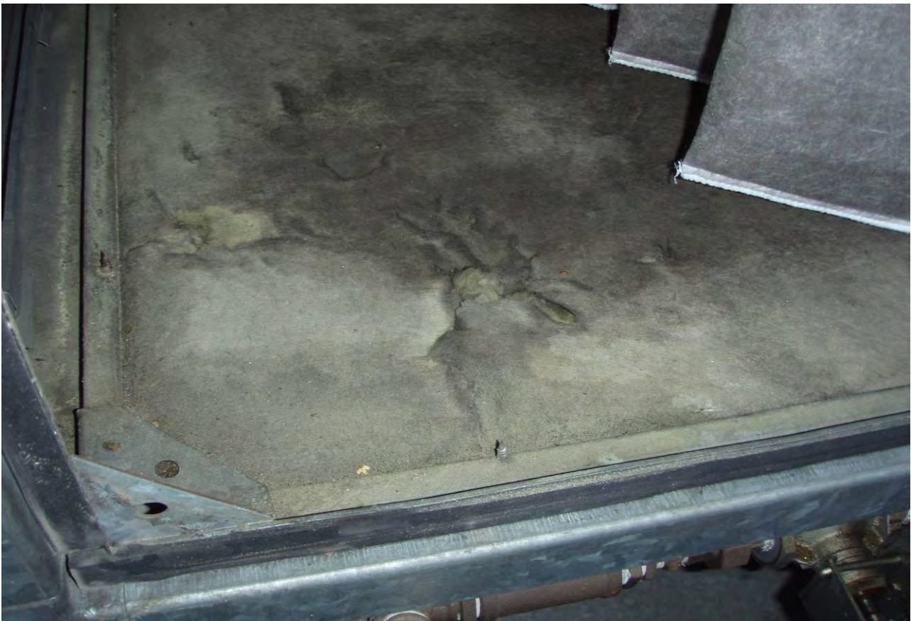
KUVA 4. Puhallinkammioissa esiintyy epäpuhtauksia ja kolhiintuneita mineraalivillapintoja.
