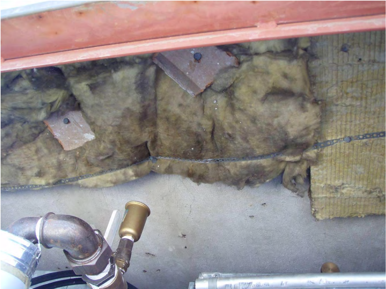
KUVA 9. Konehuoneessa on suojaamattomia mineraalivillapintoja.
