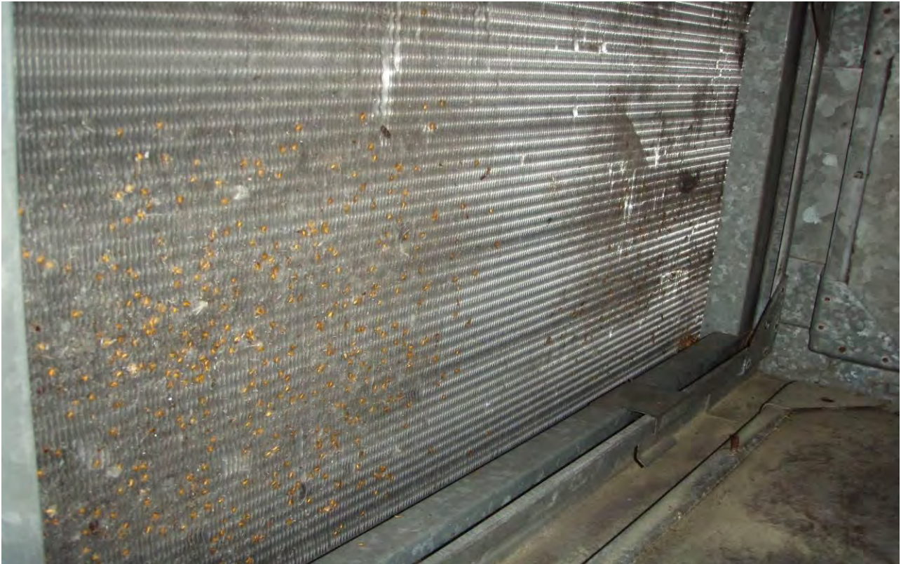
KUVA 7. 5TK koneen lämmityspatteri on likainen, mikä johtuu suodattimien ohivirtauksesta.
