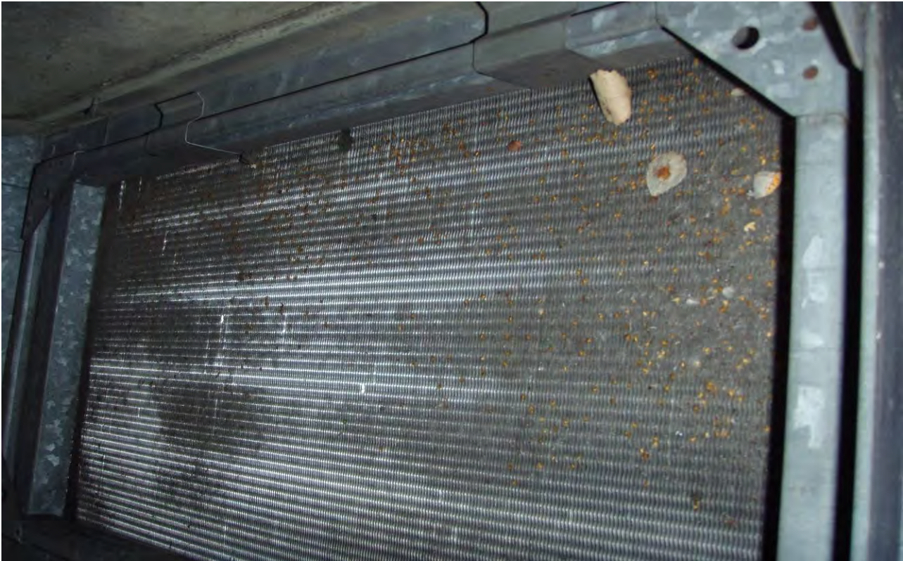
KUVA 3. 4TK koneen lämmityspatteri on likainen, mikä johtuu suodattimien ohivirtauksesta.
