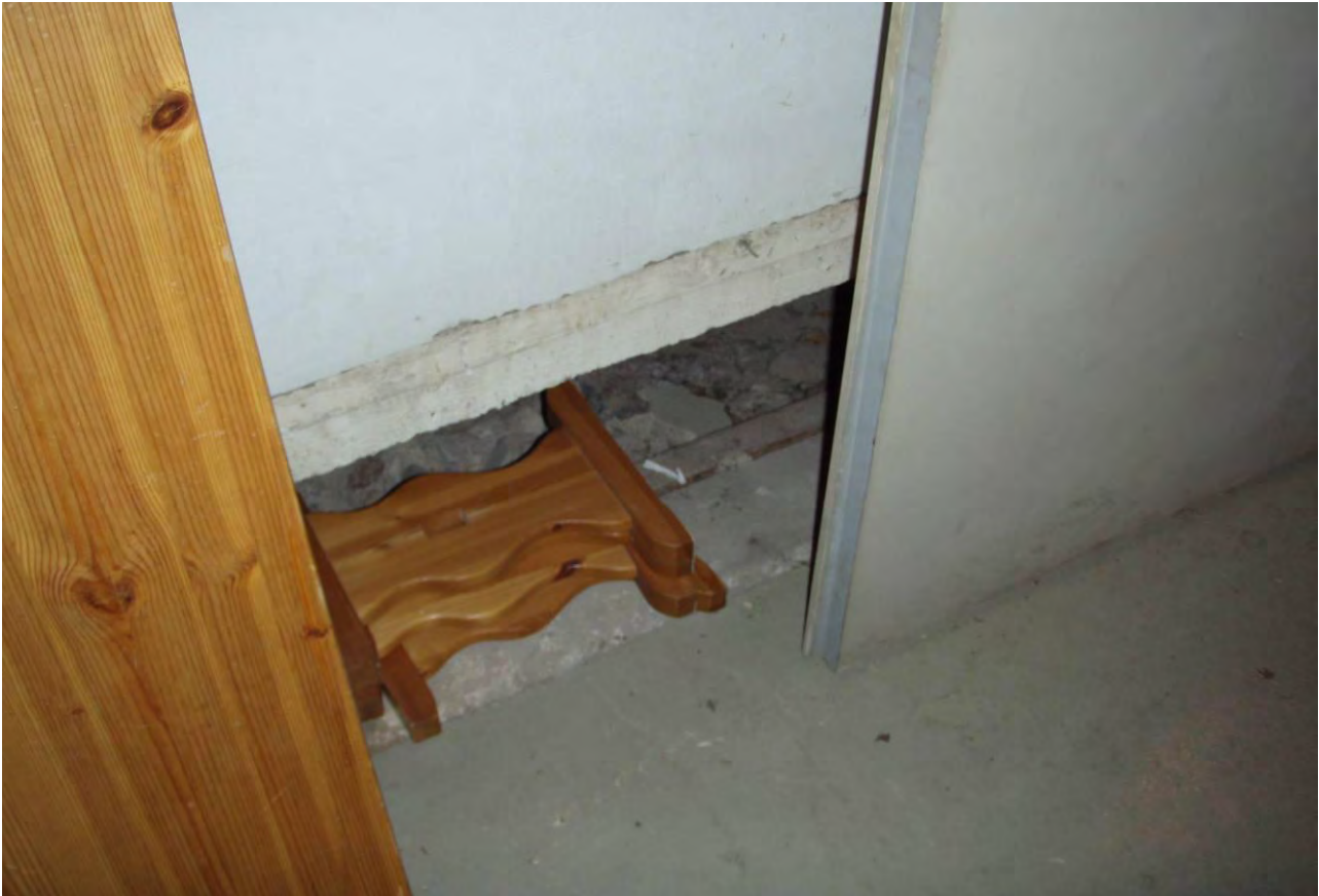
KUVA 27. Vanhasta öljysäiliöhuoneesta on suora yhteys alapohjatiilaan.
