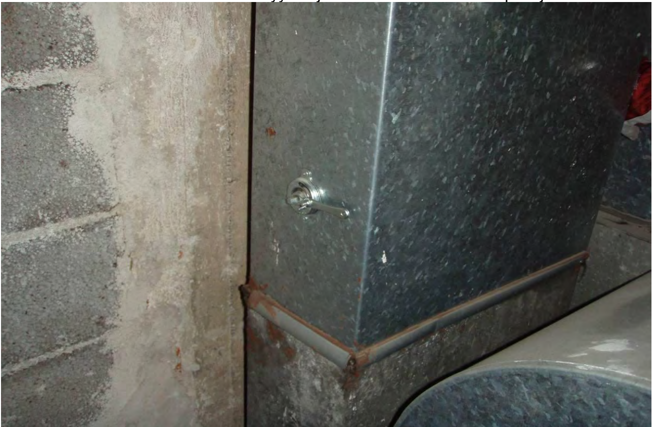
KUVA 22. Säätopelleissä ei ole mittayhteitä.
