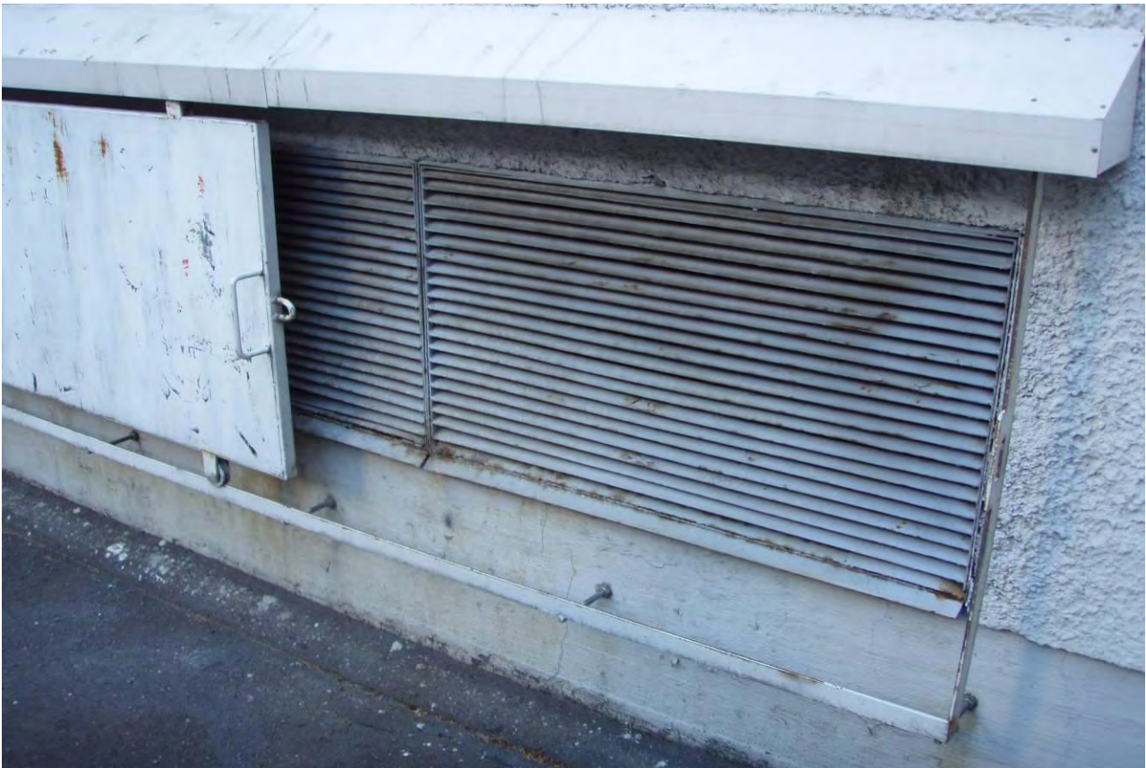
KUVA 18. Raitisilmasäleikön edessä oleva luukku tulee avata koneiden ollessa päällä.
