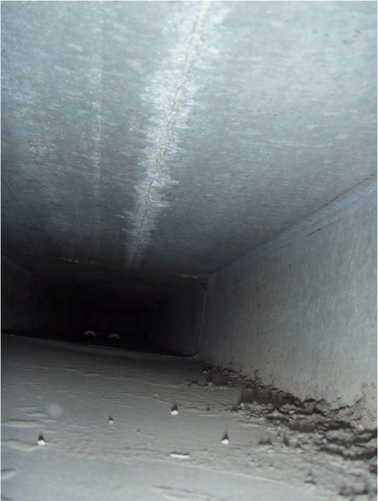
KUVA 24. Ilmastointikanavissa on paikoin epäpuhtauksia.
