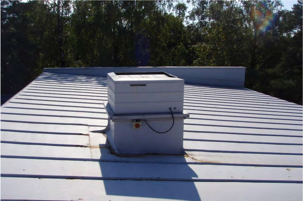
KUVA 14. Yleiskuva 6PF koneesta.
