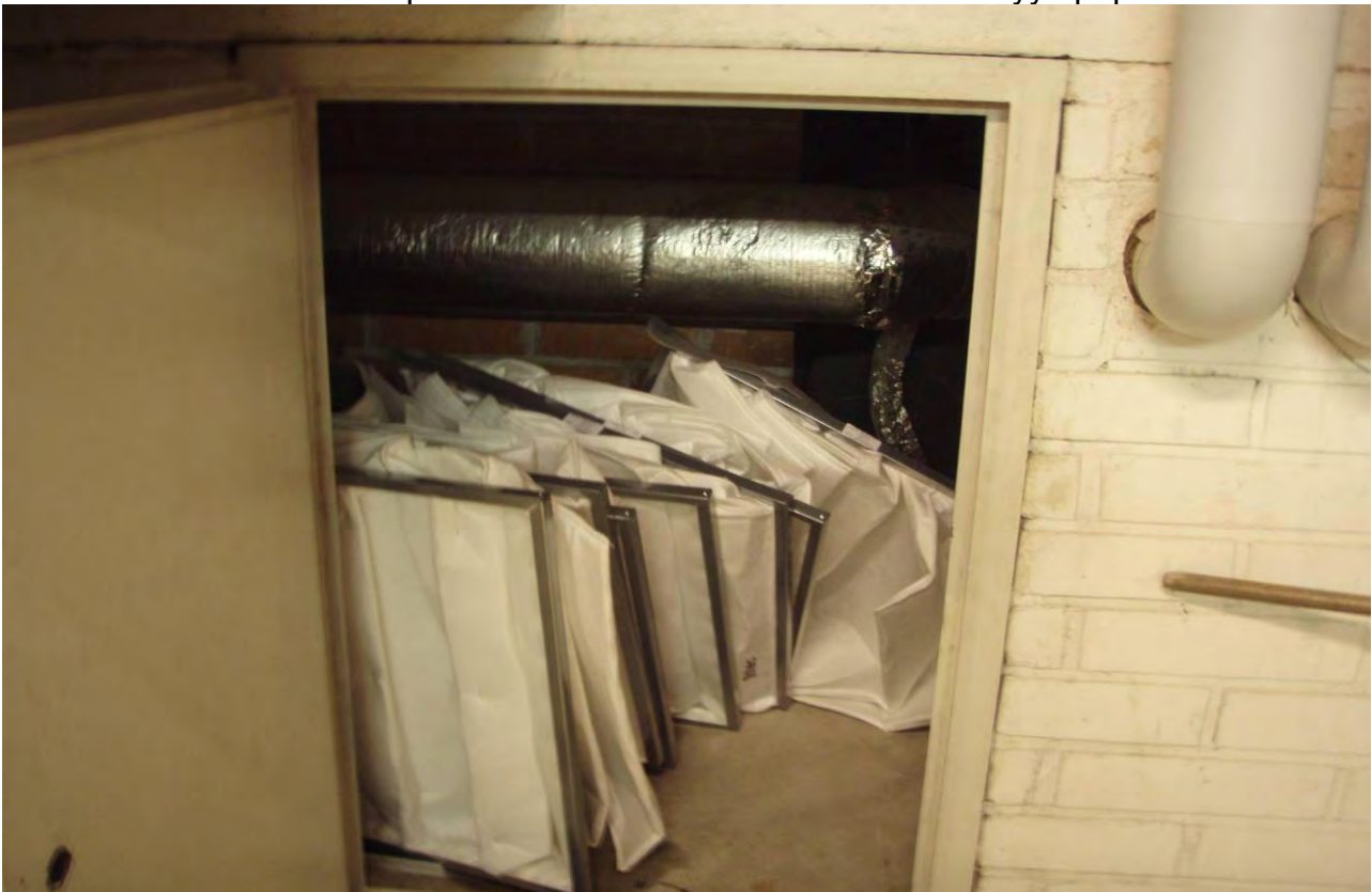
KUVA 20. Puhtaita suodattimia ei tule säilyttää likaisissa tiloissa.
