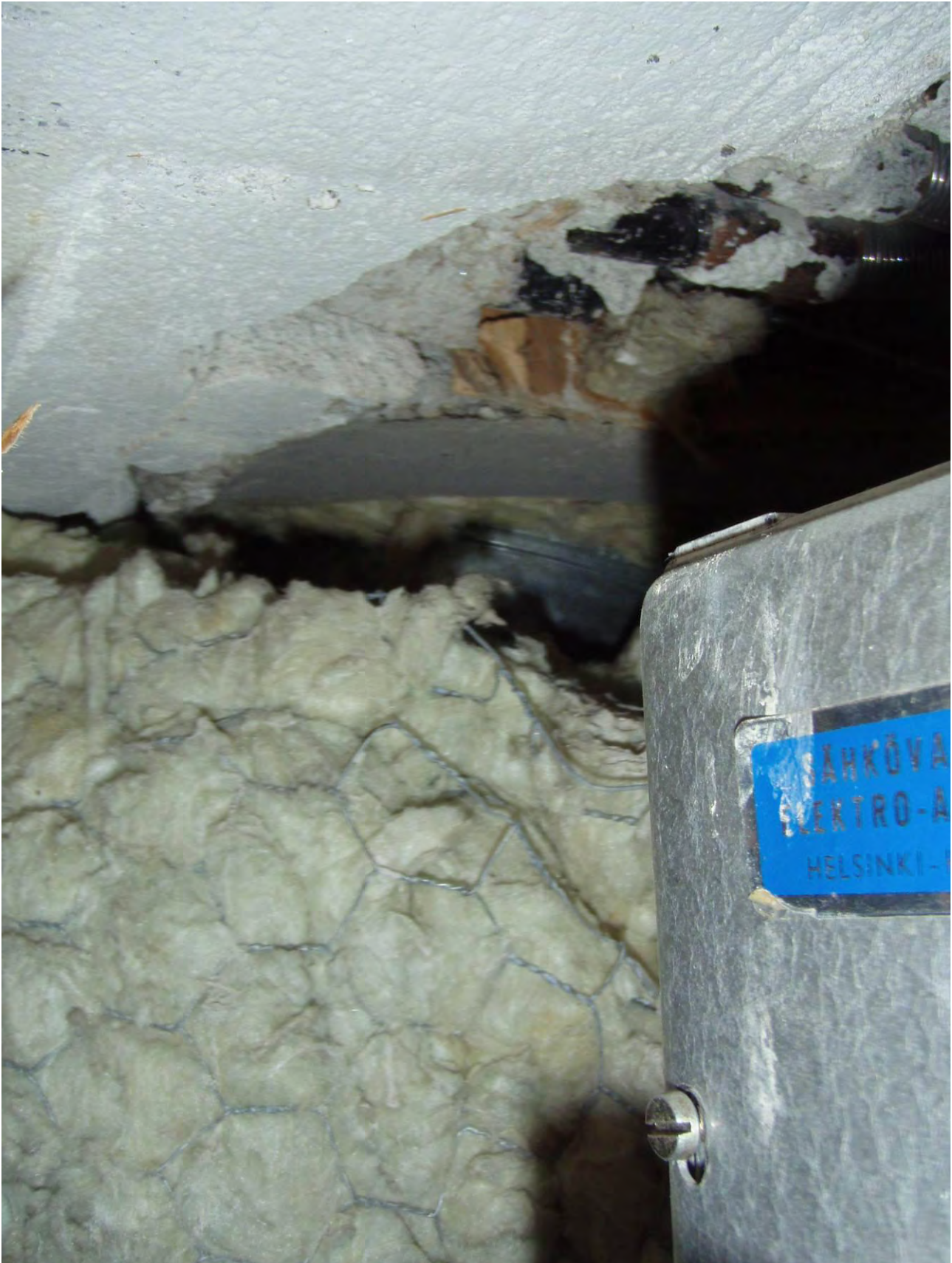
KUVA 29. Kanavien paloeristyksissä esiintyy pieniä puutteita.
