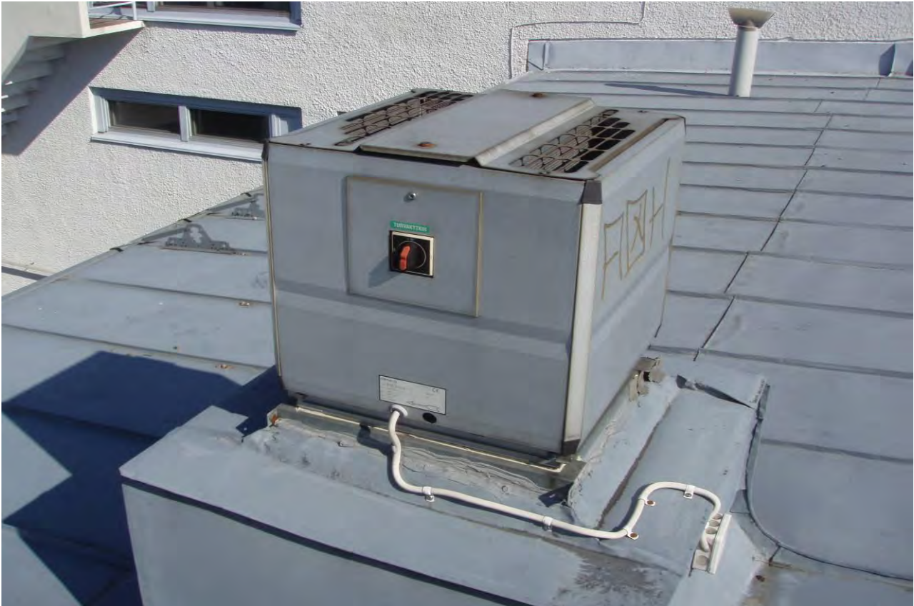
KUVA 17. Yleiskuva 12PF koneesta.
