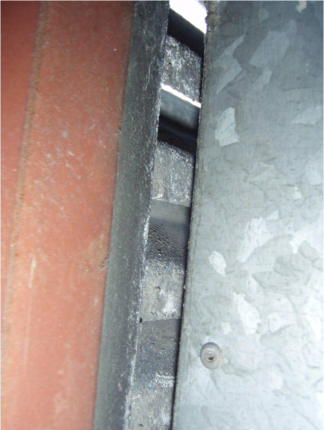
KUVA 10. 6TK koneen ulkosäleikkö ei ole tiivisti kiinni koneessa, minkä seurauksena kone ottaa osan raittiista ilmasta konehuoneesta.
