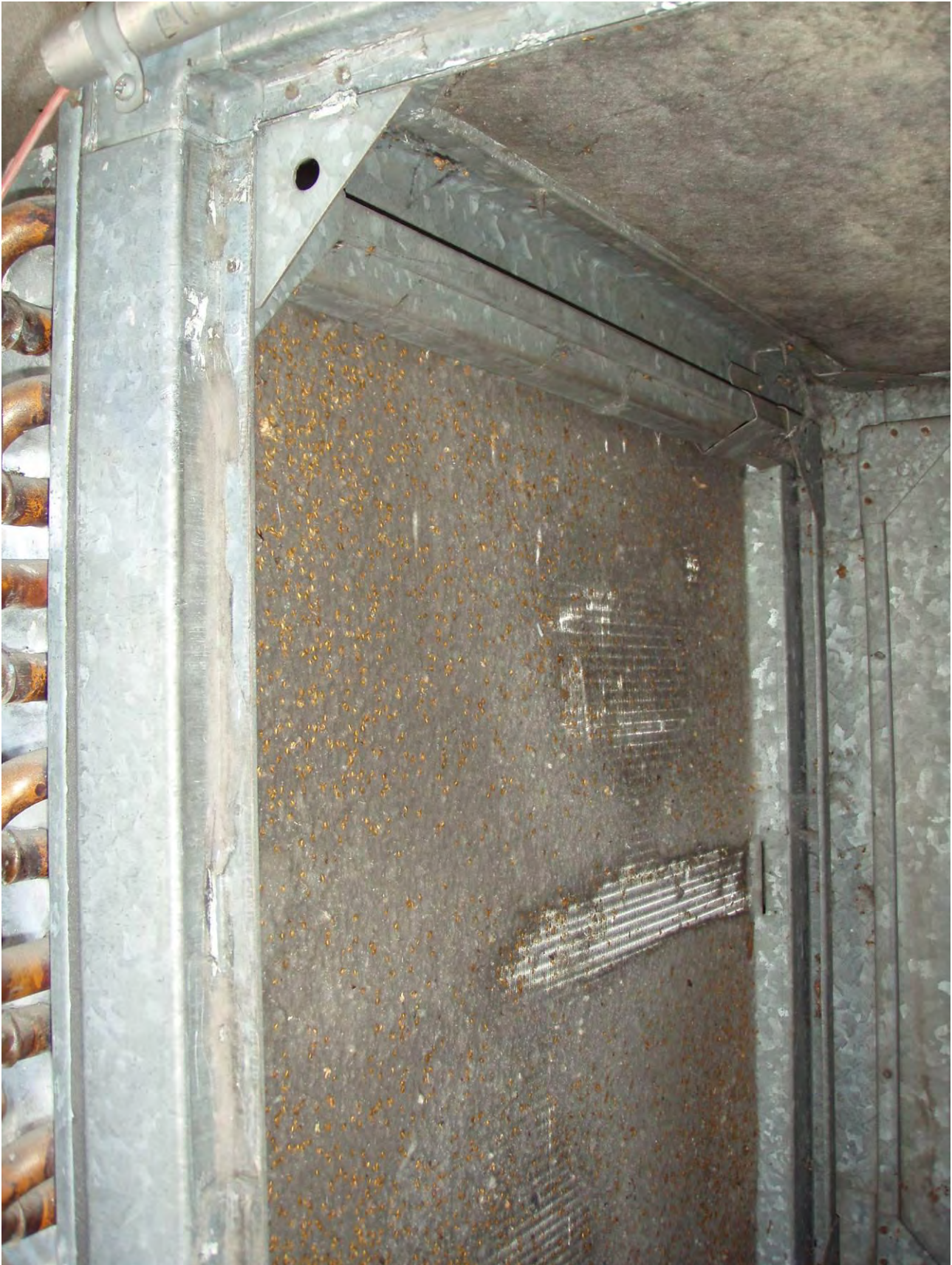
KUVA 11. 6TK koneen lämmityspatteri on lähes tukossa, mikä johtuu suodattimien ohivirtauksesta.
