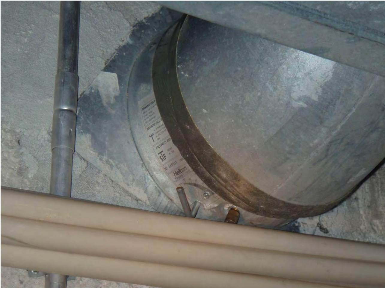
KUVA 23. Palopellit ovat kuristettu ja ne toimivat näin ollen säätöpelteinä.
