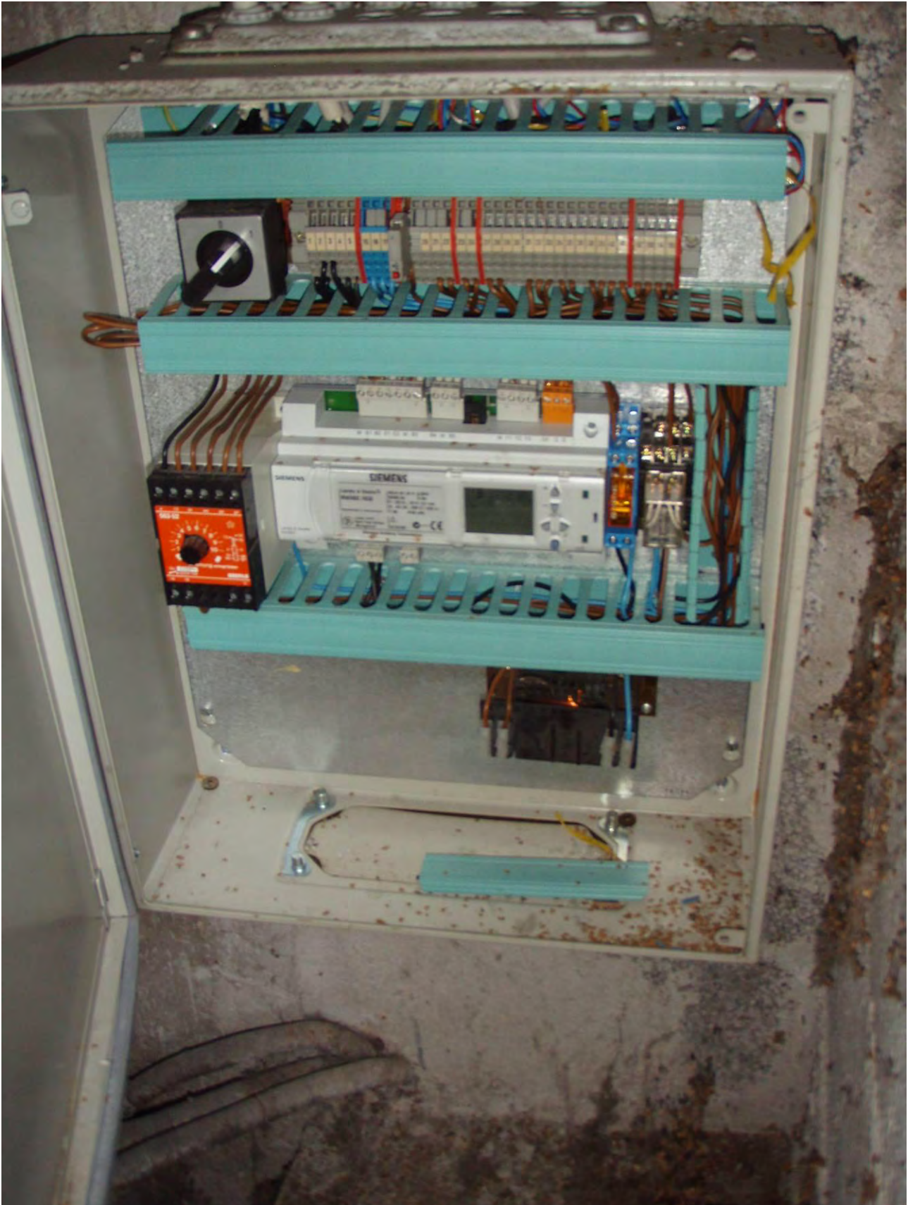
KUVA 30. Yleiskuva uusitusta säätökeskuksesta.
