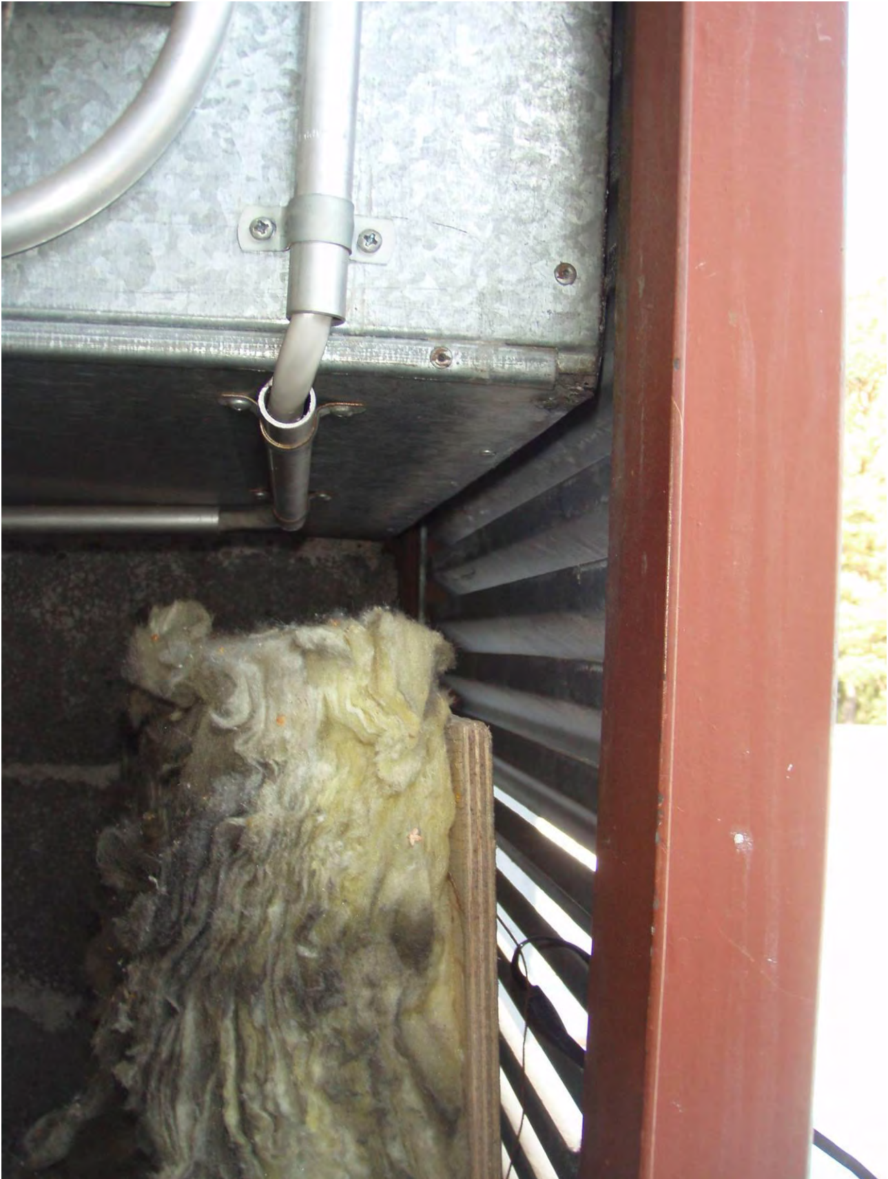
KUVA 2. 4TK koneen ulkosäleikkö ei ole tiivistä kiinni koneessa, minkä seurauksena kone ottaa osan raittiista ilmasta konehuoneesta.
