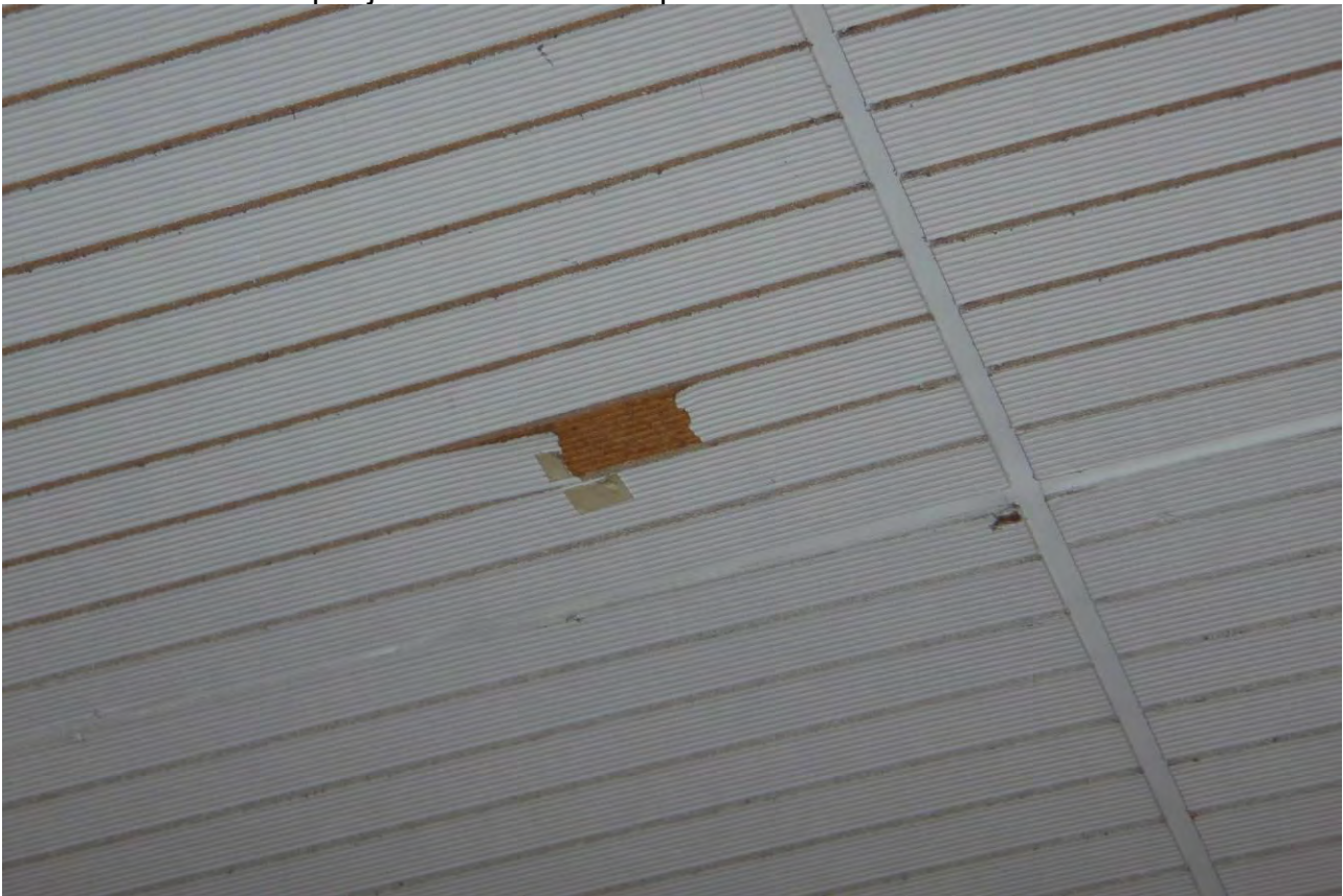
KUVA 26. Luokahuoneiden katossa olevat akustovillalevyt ovat paikoin kolhiintuneet.
