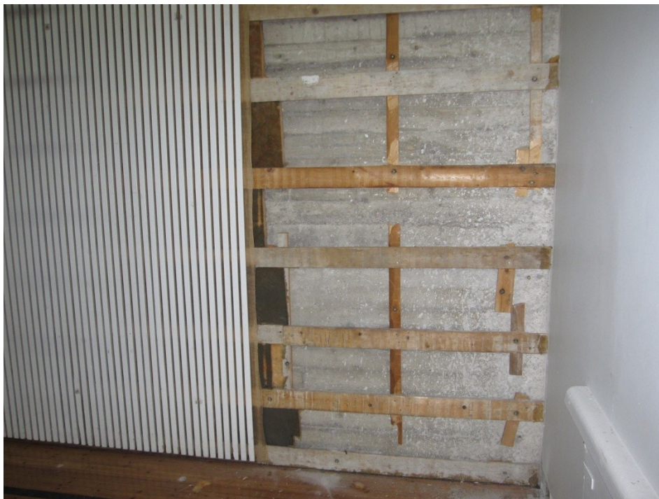
Kuva 4: Villaeriste puurakenteen takana
