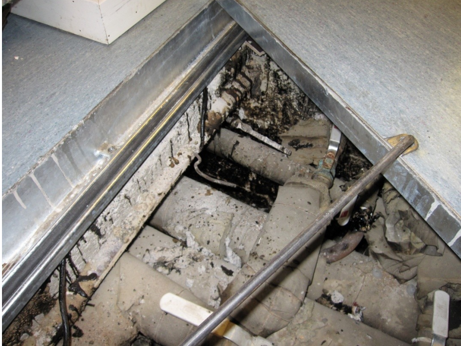
Kuva 7: Kirjaston lattian putkikanaali
