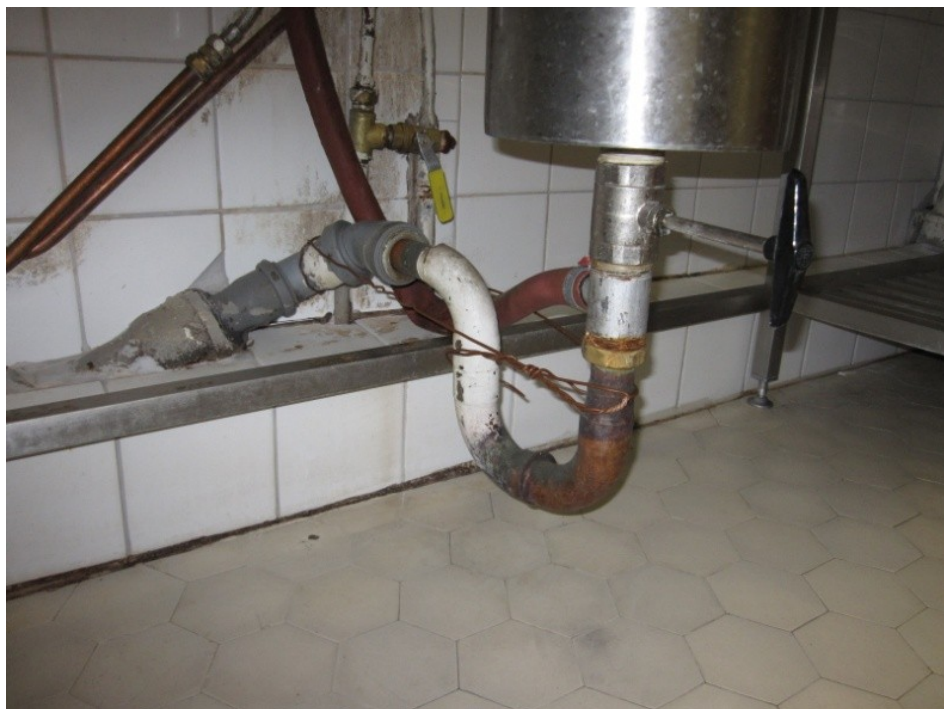
Kuva 12: Rautalangalla kiinnitetty putki
