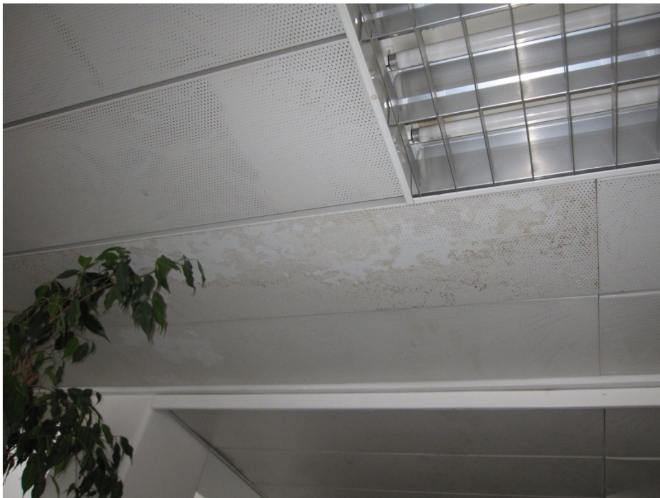
Kuva 16: Aulan kattovuotojälki
