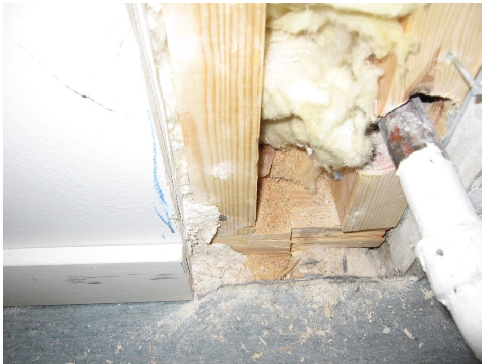
Kuva 9: Kirjaston väliseinän rakenneavaus
