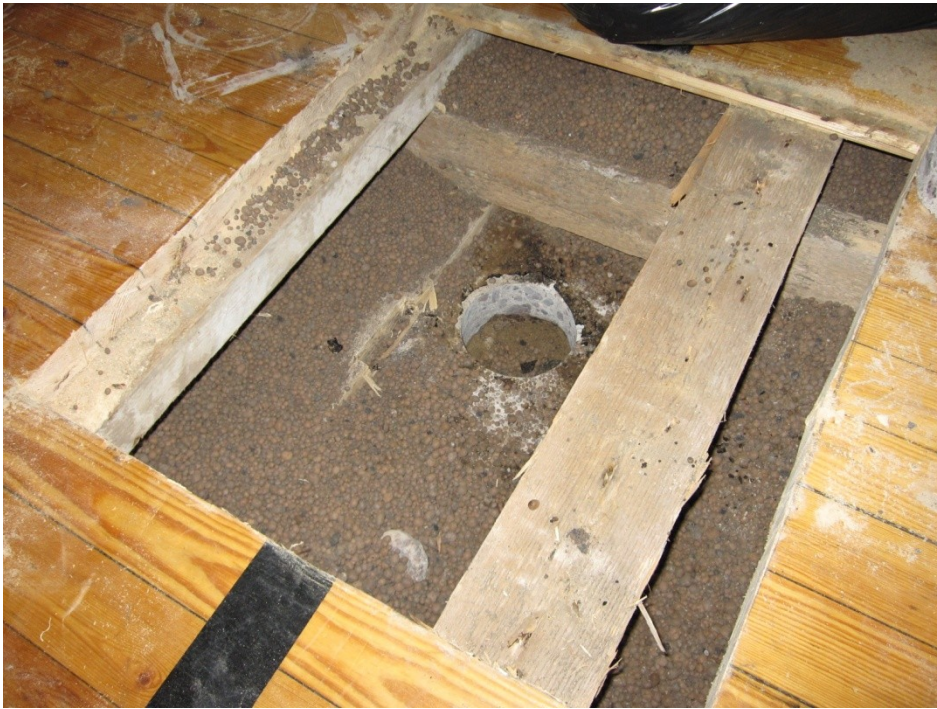
Kuva 3: Rakenneavaus lattiaan salin keskellä
