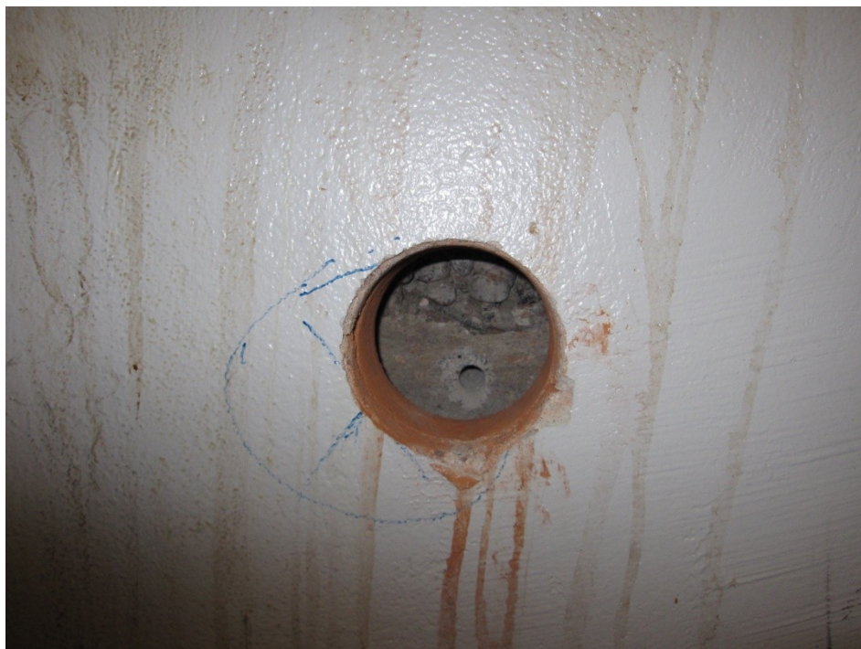
Kuva 6: Ulkoseinän timanttiporausreikä
