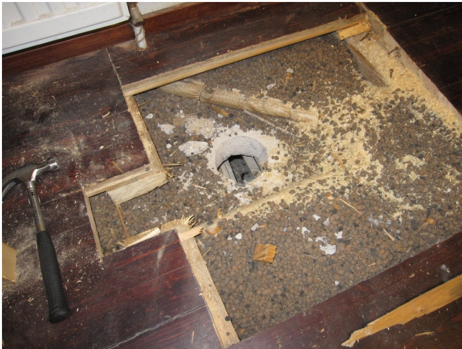
Kuva 5: Rakenneavaus kotitalousluokan lattiaan
