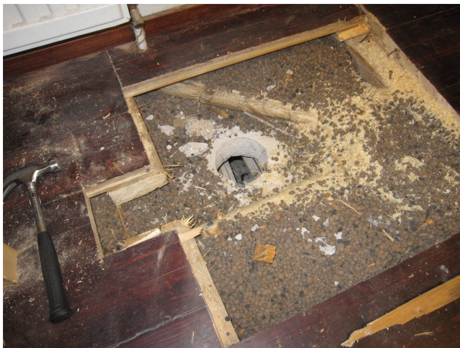
Kuva 5: Rakenneavaus kotitalousluokan lattiaan
