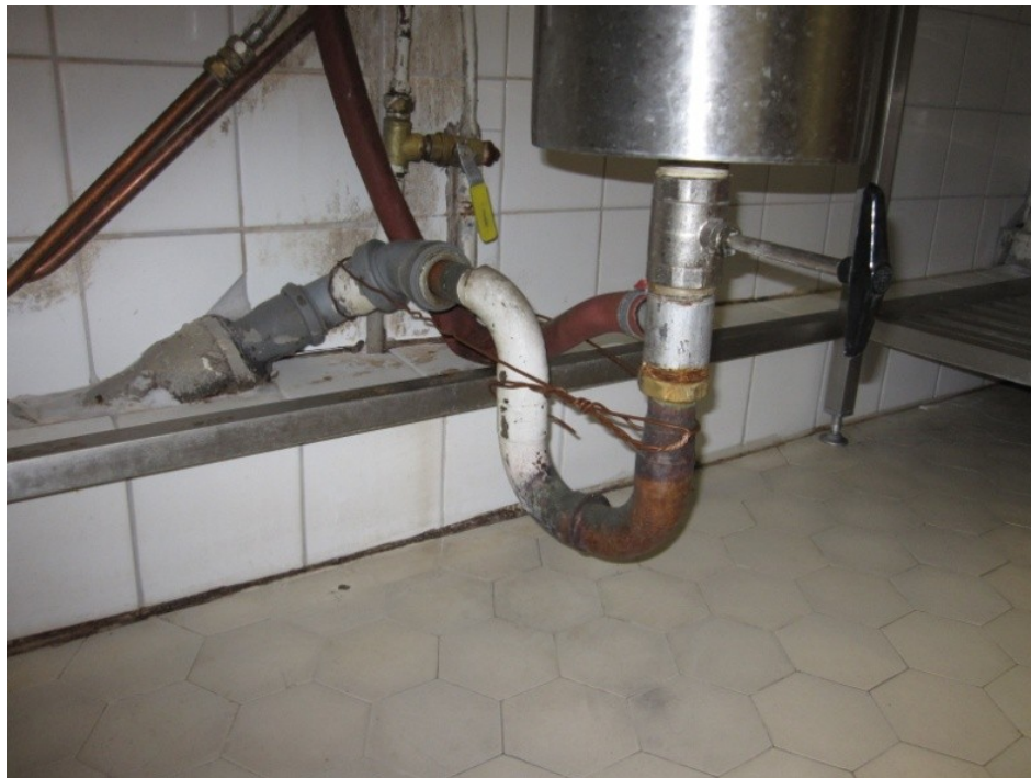
Kuva 12: Rautalangalla kiinnitetty putki
