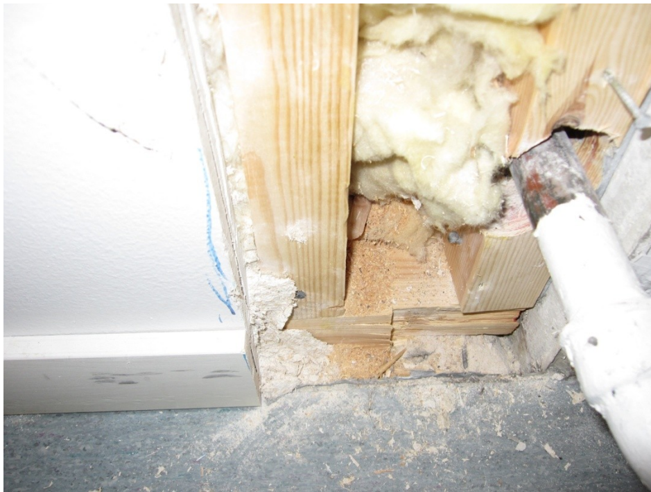
Kuva 9: Kirjaston väliseinän rakenneavaus
