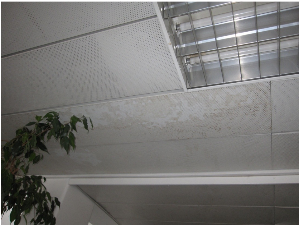
Kuva 16: Aulan kattovuotojälki
