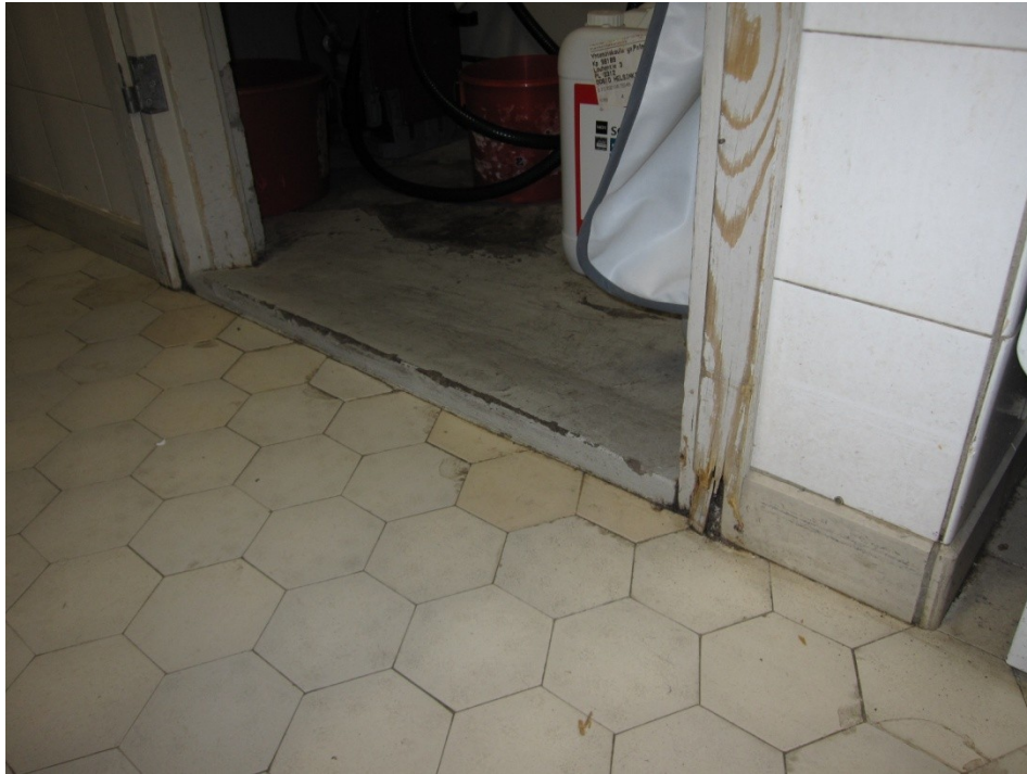
Kuva 11: Keittiön pintarakenteet ja puuosat ovat huonokuntoiset
