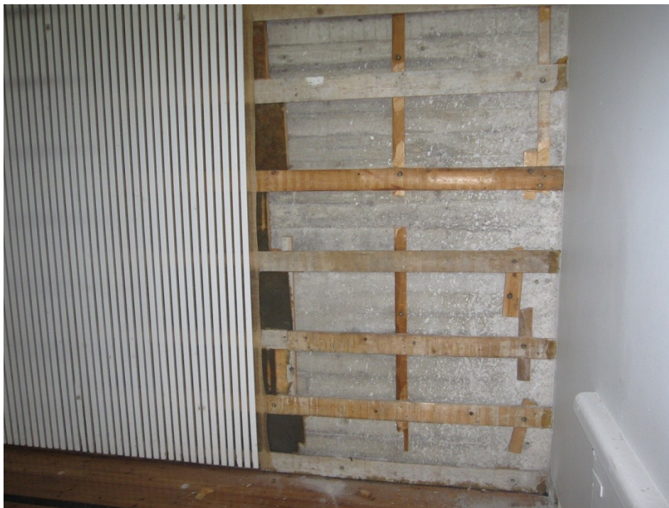
Kuva 4: Villaeriste puurakenteen takana
