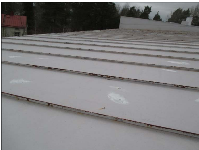
Pystysaumoissa laajat korroosiovauriot
