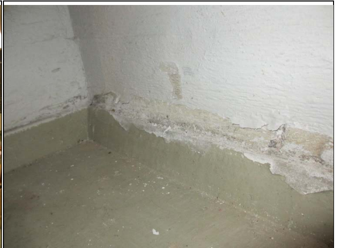
Seinän alaosan maalivaurio väestösuojassa
