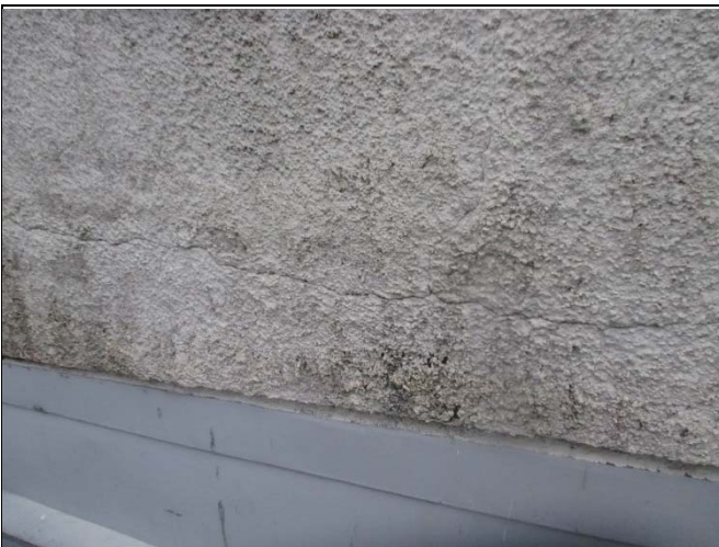
Suurehko halkeama rappauskerroksessa
