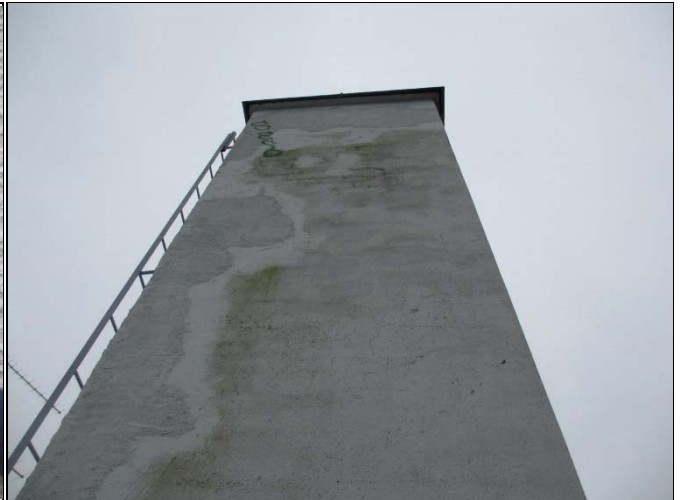
Piipunosalta rappausvauriot ovat huomattavat
