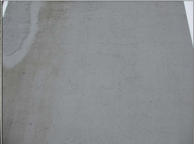
Halkeamaverkostoa piipun rappauspinnassa
