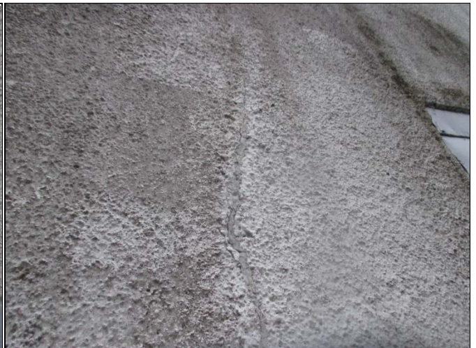
Paikattu halkeama rappauskerroksessa
