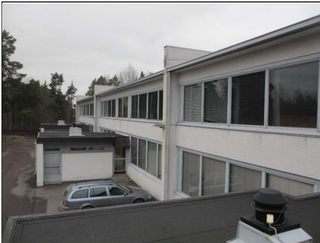
Yleiskuva lännen puolelta
