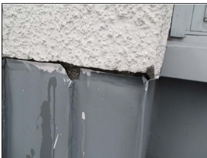
Epätiivittä pellitysten liittymiä havaittiin monin paikoin
