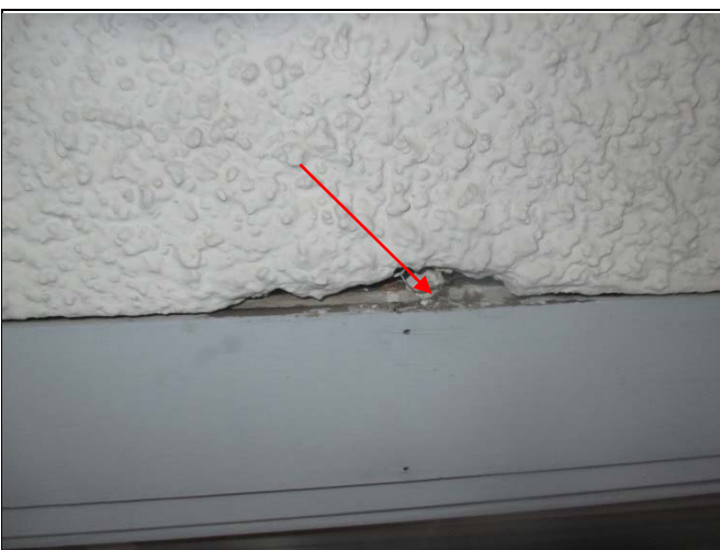
Rappausverkko havaittiin vain yksittäisillä alueilla
