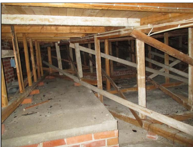
Yleiskuva liikuntasalin yläpohjasta
