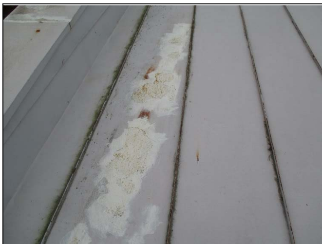
Maali- ja korroosiovauriot ovat yleisiä
