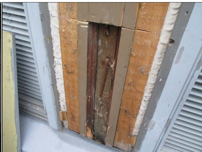
Rakenteet ovat täysin tuulettumattomia
