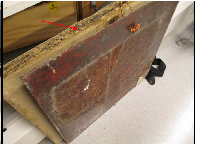
Lastulevyssä kosteuden aiheuttamaa turpoamista
