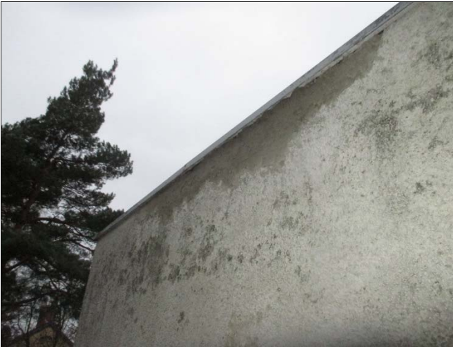
Paikkakorjattu alue räystäällä
