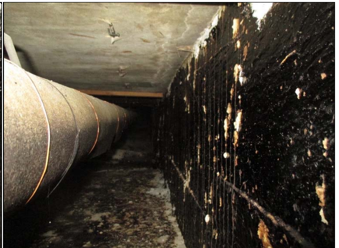
Matalaa putkikanaalia, katossa muottivaneri
