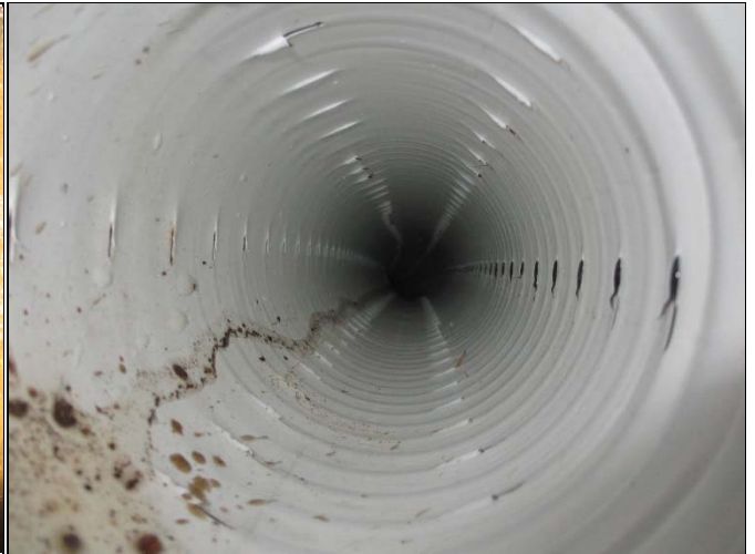
Salaojat ovat kuvatuilta osin puhtaita
