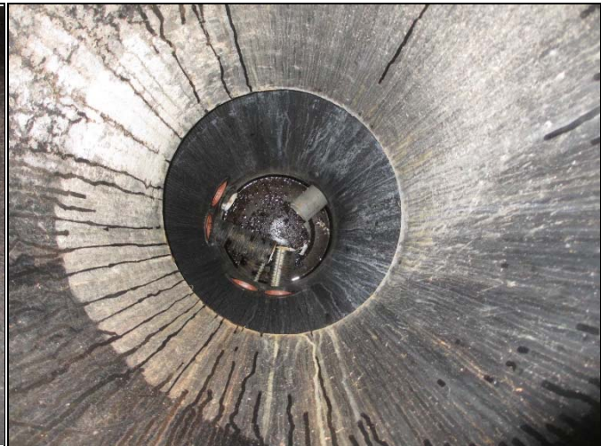
Putket salaoja kaivossa
