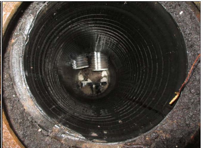
Kaivo, jossa putkien korkoeron on ilmoitettu olevan 1570 mm
