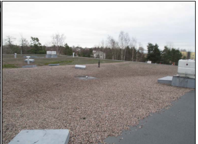
Yleiskuva liikuntasalin katolta
