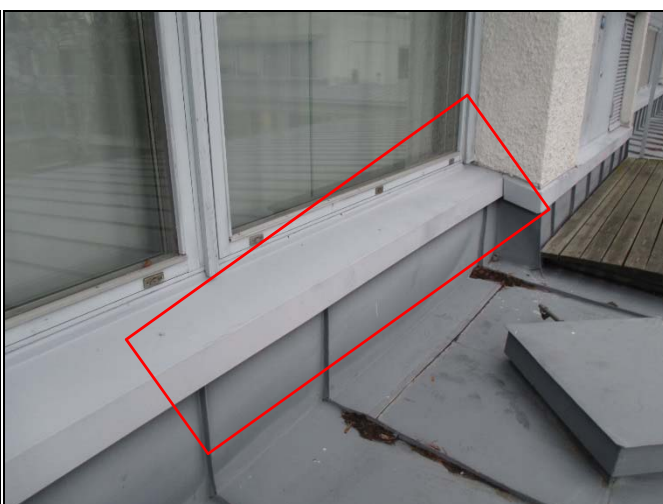
Havaintojen mukaan ilmaväli on ummessa alemman lappeen yläpäästä.
