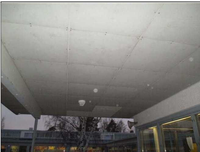
Katoksen alapinnan levytys
