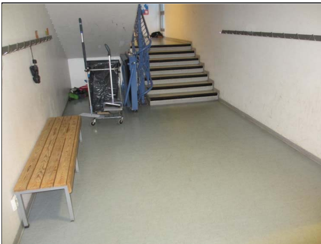
Käyttötiloissa on valtaosin muovimatot
