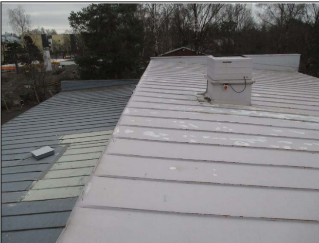
Yleiskuva pulpettikatolta, vasemmalla paikkakorjattu alue
