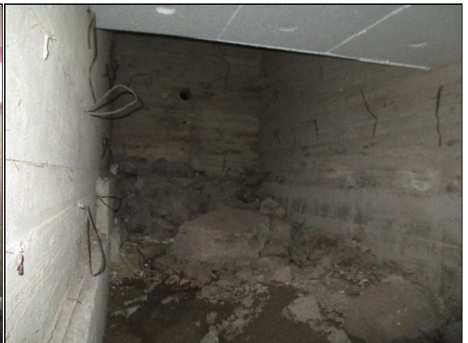
Ryömintätila jossa ei koneellista ilmanvaihtoa
