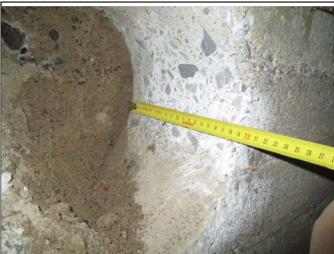
Ryömintätilan ja maanvastaisen alapohjan välinen seinä rakennuksen sisäpuolella, paksuus 200 mm
