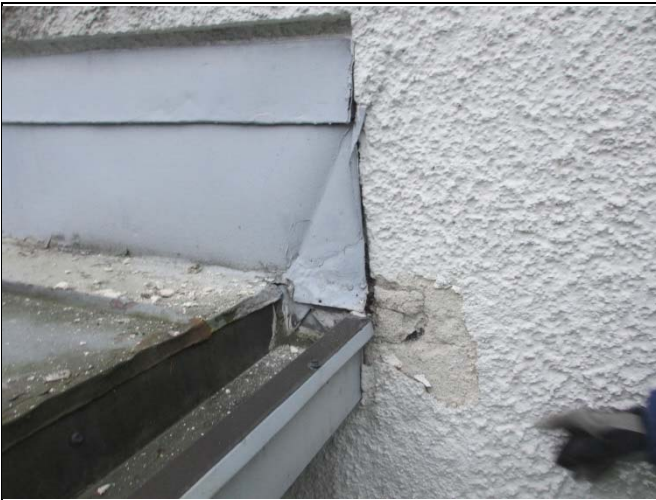
Liittymäpellitys epätiivis, alueella rappausvaurio
