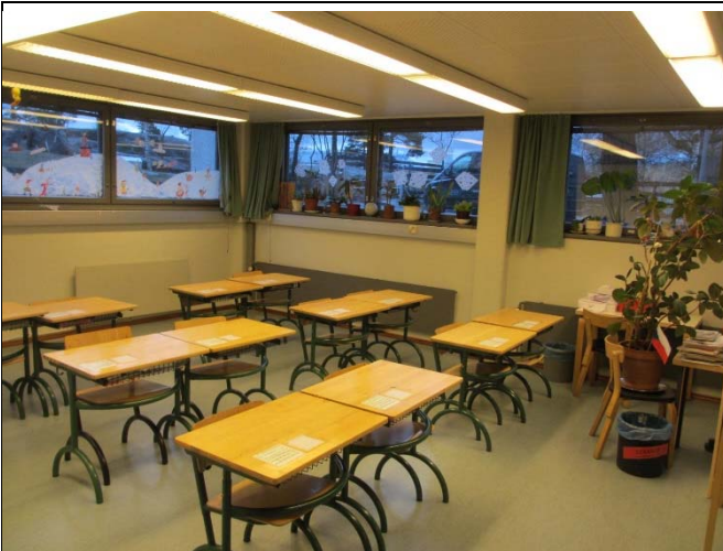
Ikkunoiden alapuolella maanvastaista seinää
