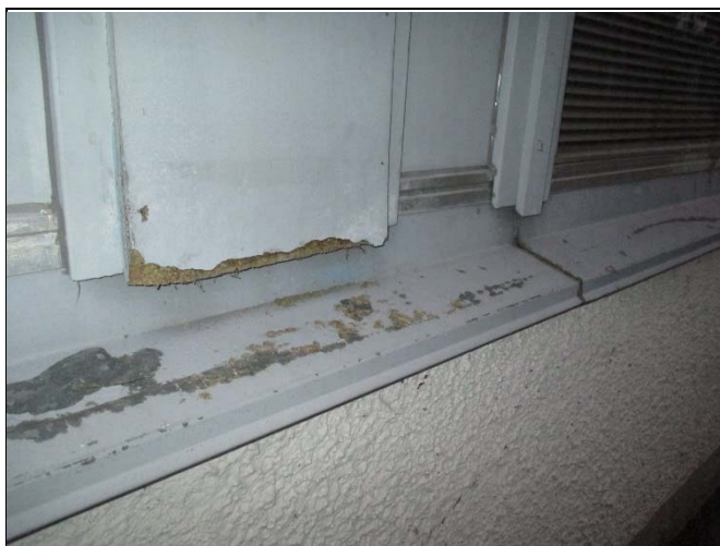
Kosteusvaurio ulkopinnan lastulevyssä
