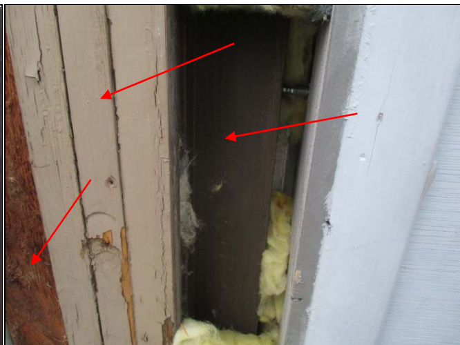
Avauksissa havaittiin useita purkamattomia vanhoja ikkunarakenteita.
