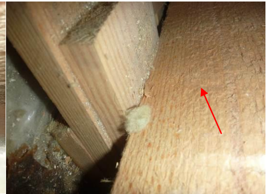
Kuva 13. liikuntasalin lattian puurakenteisessa ei näkynyt merkkejä kosteusrasituksesta.
