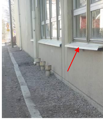
Kuva 21. Ikkunapellit ovat yleisesti hyväkuntoisia ja toimivia. Yksi rikkoontunut pelti todettiin kadun puolella. Rikkonainen pellitys aiheuttaa ylimääräistä kosteusrasitusta
