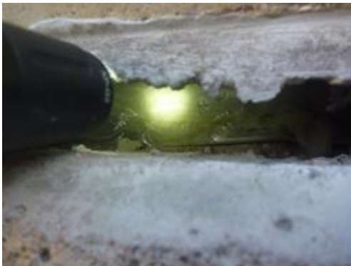
Kuva 25. Betonielementtiseinän saumassa näkyi muovia. Villan ulkopinnassa oleva muovi estää rakenteen kuivumista.
