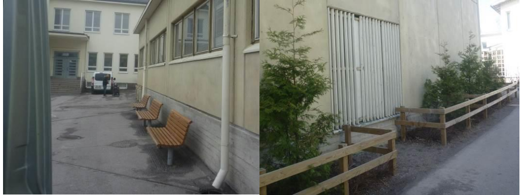
Kuva 1. Koulurakennusten sisäpihat ovat asfalttipintaisia. Asfalttiin on muotoiltu vesikourut syöksyjen alta.
