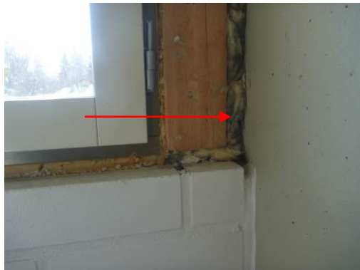
Kuva 29. Tummineet villat ikkunan vieressä viittaavat ilmapuotoihin rakenteessa. Rakenteen sisäpinnassa ei ole tiivistä höyrynsulkua.
