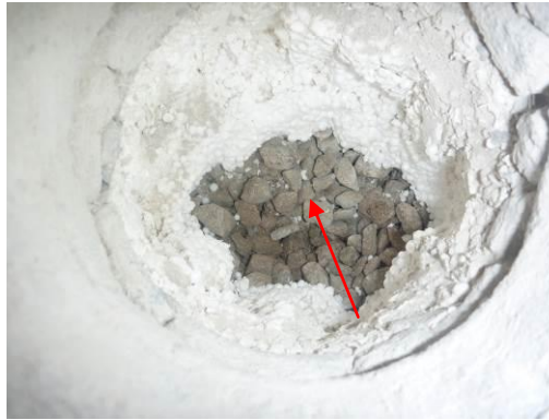
Kuva 16. Teknisen luokan lattian betonilaatan alla on karkea sora, jossa ei ole hienoaainesta.
