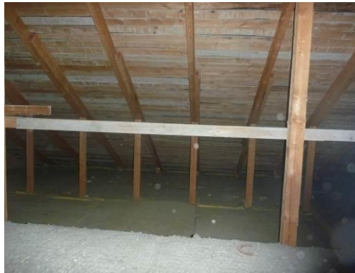
Kuva 32. Yläpohja rakenteissa ei havaittu merkkejä kosteusvaurioista.
