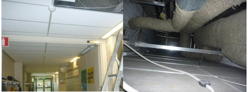
Kuva 38. Kattojen alaslaskut ovat pinnoitettuja akustiikkalevyjä.
