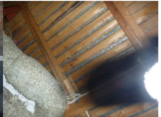
Kuva 33. Peltikatteen alla on harvalauditus ja aluskatetta ei ole. Toisaalta katto on jyrkkä harjakatto ja merkittävää riskiä kosteusvaurioille ei ole.
