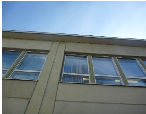
Kuva 23. Liikuntasalin korkealla olevia ikkunoita ei päästy tarkastamaan.
