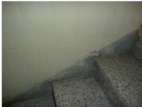
Kuva 18. Kellarin portaikossa on todennäköisesti kosteuden aiheuttamia vaurioita. Todennäköinen syy on kapillaarikosteus portaan alapuolisesta maataytöstä.
