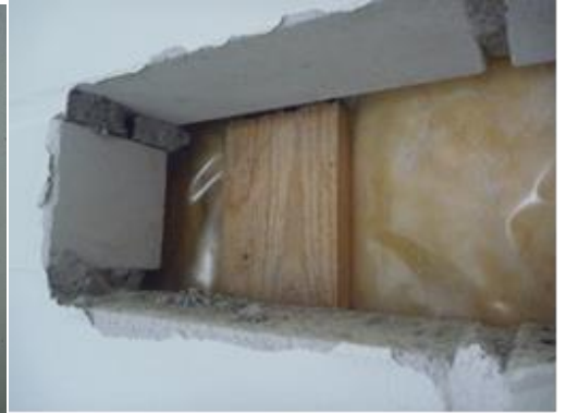
Kuva 30. Tiilirakenteisen ulkoseinän eristetilä, jossa muovi on sisäpinnassa ja muovin sisäpinnalla puutavaraa sekä ilmarako. Ilmaraot eristetilassa heikentävät lämmöneristystä. Vuotokohdista kylmä ilma voi kulkeutua ilmarakoja pitkin muualle.
