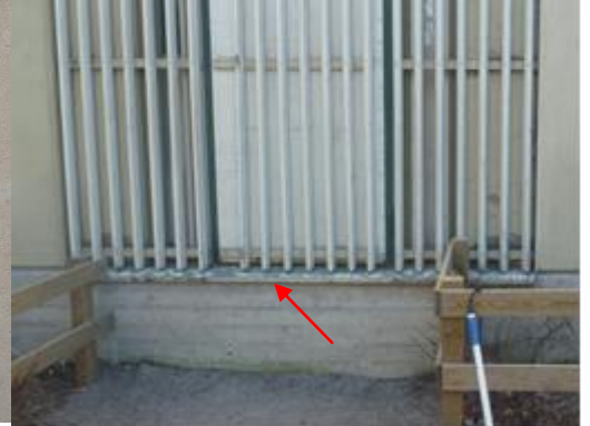
Kuva 22. Vanhan oviaukon pellityksen kaltevuus on vähäinen, joka aiheuttaa ylimääräistä kosteusrasitusta seinärakenteen alaosaan.
