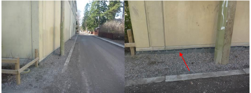
Kuva 3. Veljestentien pinta ja rakennuksen vierusmaat ovat lähes koulun lattiapinnan tasossa. Salaojakaivoja ei havaittu rakennuksen vierustoilla. Leikkauskuviin on piirretty salaojat, joiden tarkastuskaivot on mahdollisesti maan alla.
