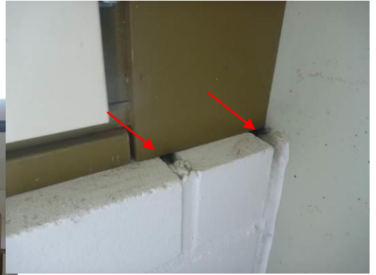
Kuva 28. Tiilen ja levysauman raoista voi päästä epäpuhtauksia sisäilmaan.
