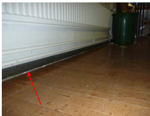
Kuva 14. Teknisentyön luokan lattialistan alla on rako. Syynä voi olla lattiarakenteen painuminen.
