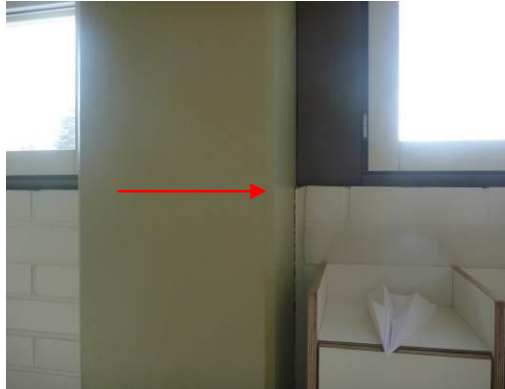
Kuva 27. Tiilirakenteisen sisäkuoren liitokset monin paikoin ovat halkeilleet. Rakenne ei ole ilmatiivis ja ulkoseinästä voi päästä epäpuhtauksia sisäilmaan.
