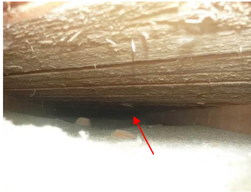
Kuva 12. Liikuntasalin lattian ja villan välissä on 50 mm rako.
