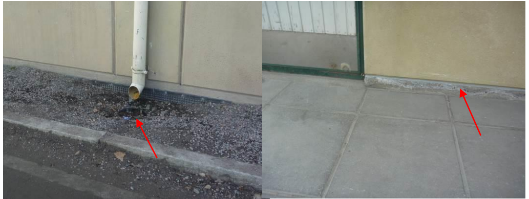
Kuva 5. Syöksytorvien alla on sadevesiviemärit.
