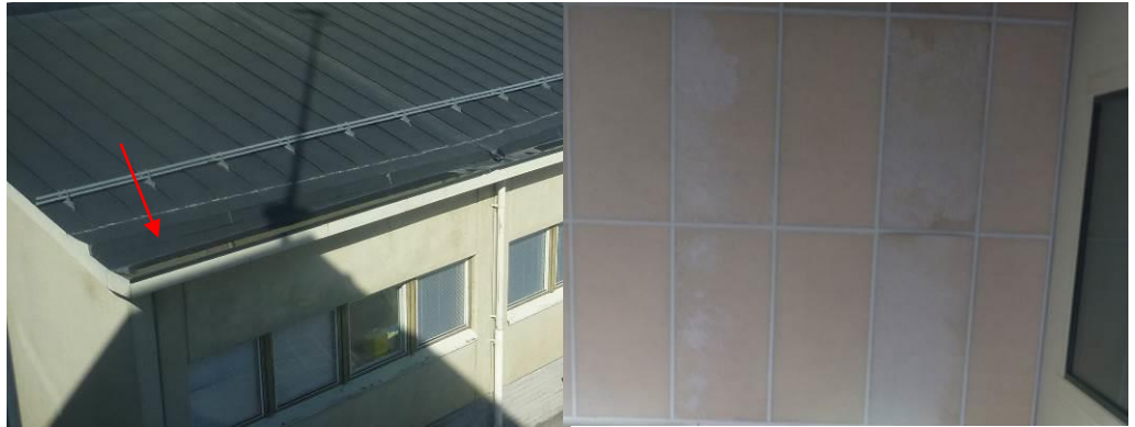
Kuva 34. Rästäspeltti muodostaa kourun ja vesi lammikoituu räystäälle. Lammikoituvaa vettä on riski vesivuodoille. Vuotoja ei kuitenkaan havaittu.
