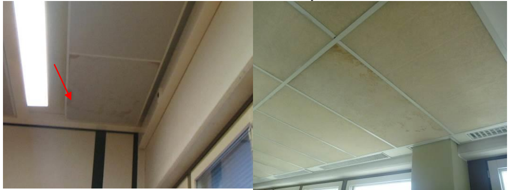
Kuva 36. Teknisen työn katossa on ollut vesivuotoa. Akustiikkalevyssä jälkiä. Akustiikkalevyt ovat pinnoitettu ja niistä ei pitäisi vapautua kuituja sisäilmaan.
