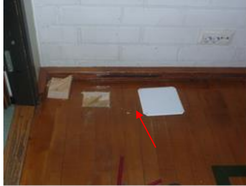
Kuva 10. Liikuntasalin lattiapinnoilla ei havaittu viitteitä vaurioista. Rakenneavauksia tehtiin kosteusmittausten ja riskiarvion perusteella. Lattiaan tehtiin 4 kpl rakenneavauksia.
