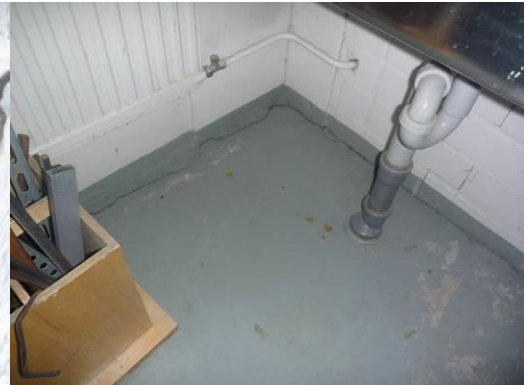
Kuva 17. Teknisentyön "hitsaushuoneessa" on betonilaatta, jonka reunat ovat halkeilleet lattialaatan painuman seurauksena
