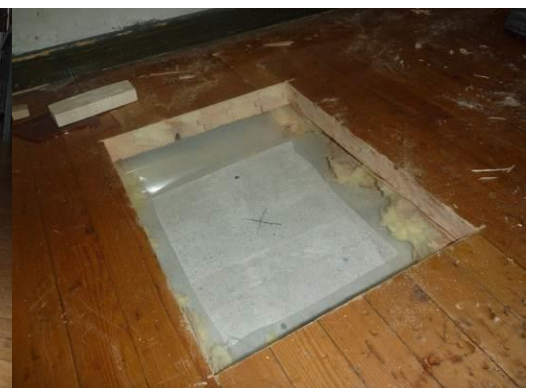
Kuva 15. Teknisentyön lattian puurakenteen ja betonin välissä on muovikalvo.
