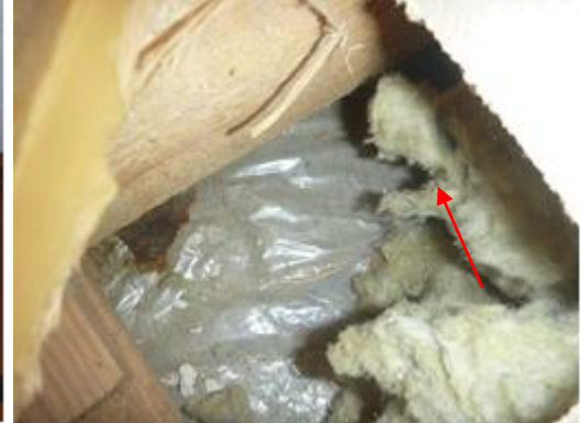
Kuva 11. Liikuntasalin puurakenteisen lattian ja betonilaatan välissä on muovi. Muovissa on jälkiä kosteuden tiivistymisestä.
