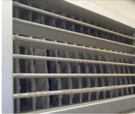
Kuva 10. Tuloilmasäleiköt ovat osin likaisia.
