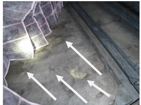
Kuva 4. Kuten myös suodatinkammiossa tuloilmasuodattimien jälkeen.
