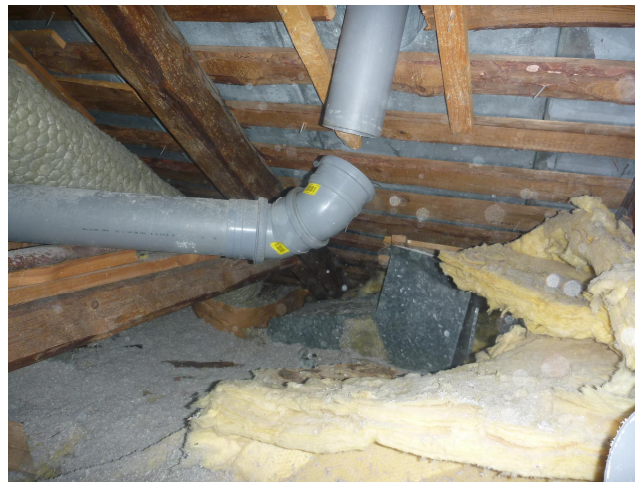
Kuva 15. Puukoulu ullakon viemäri on irti
