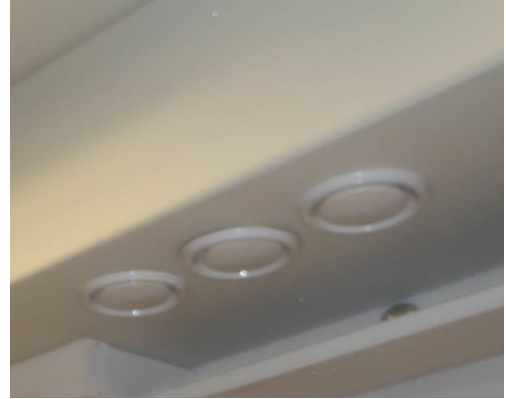
Kuva 11. Poistoilman päätelaitteet ovat KSO-venttiilejä.
