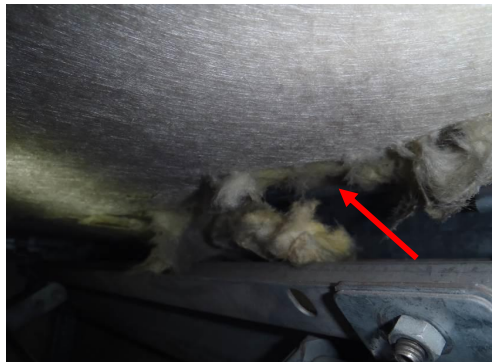
Kuva 3. Tuloilmakoneen 6TK1 puhallinkammiossa olevan mineraalivillan pinta on osin rikki.
