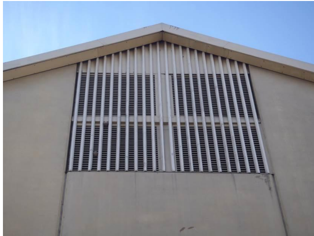
Kuva 5. Tuloilmakoneiden raitisilmasäleiköt sijaitsevat rakennuksen päädyssä.
