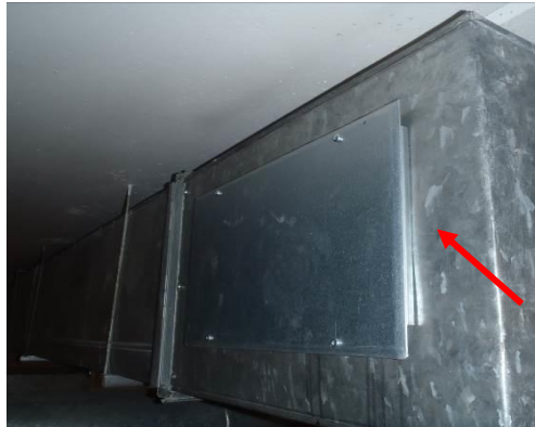
Kuva 7. Puhdistusluukun kehyksen kanavaliitos vuotaa IV-konehuoneessa (5TK1).
