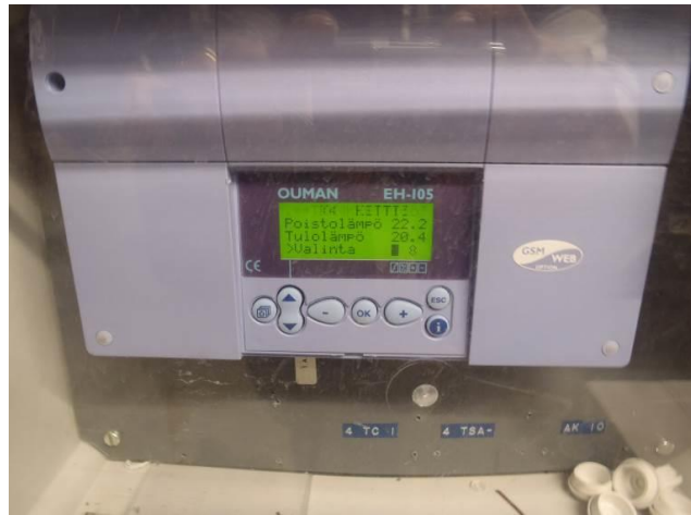
Kuva 14. IV-konehuoneessa oleva Oumanin yksikkösäädin (EH-105).
