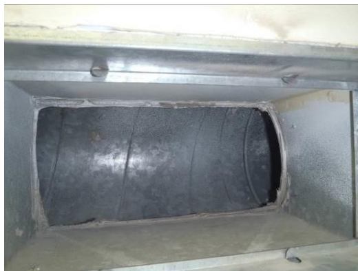
Kuva 9. Tuloilman päätelaitteissa ei ole mittayhteitä / säätöosaa
