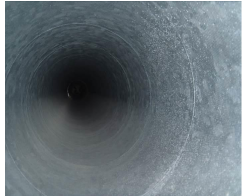
Kuva 8. Tuloilmakanavassa on hieman näkyvää pölykertymää.
