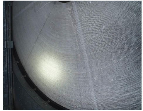
Kuva 2. Ilmanvaihtokoneiden 6TK1/6PK1 lämmöntalteenottokiekon otsapinta on puhdas.
