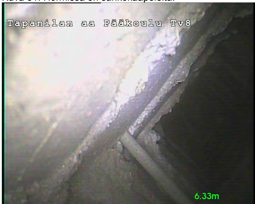
Kuva 32. Hormin lävistää kierretanko.
