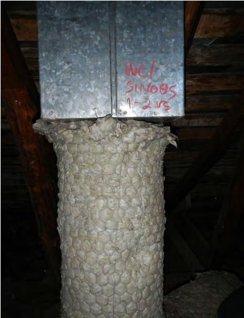
Kuva 23. Yleiskuva poistoilmakoneen poistoilmapiipusta.
