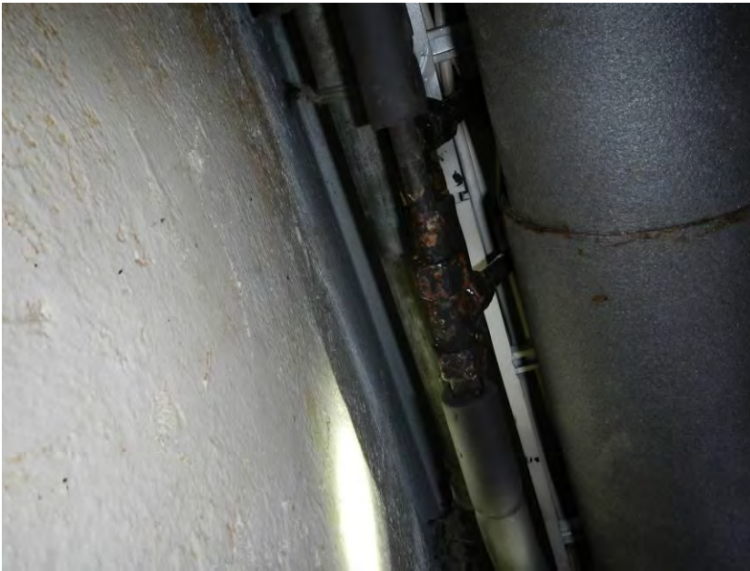
Kuva 10. Yleiskuva vanhoista linjaventtiileistä.
