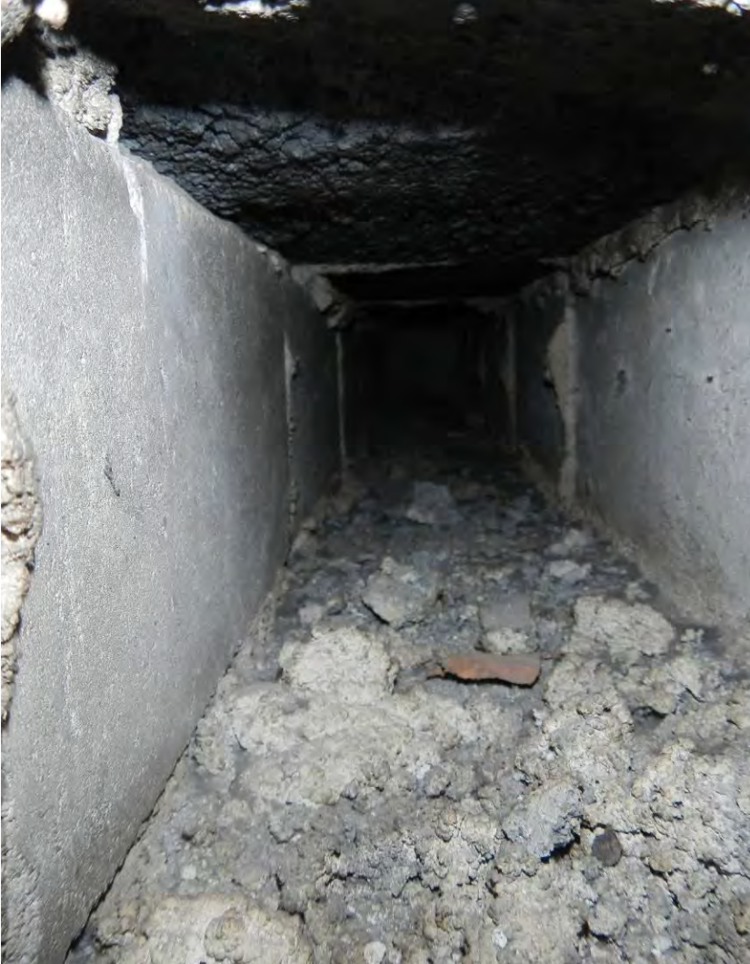
Kuva 30. Vaakahormien pohjalla on paikoin runsaasti rakennusaineista epäpuhtautta.
