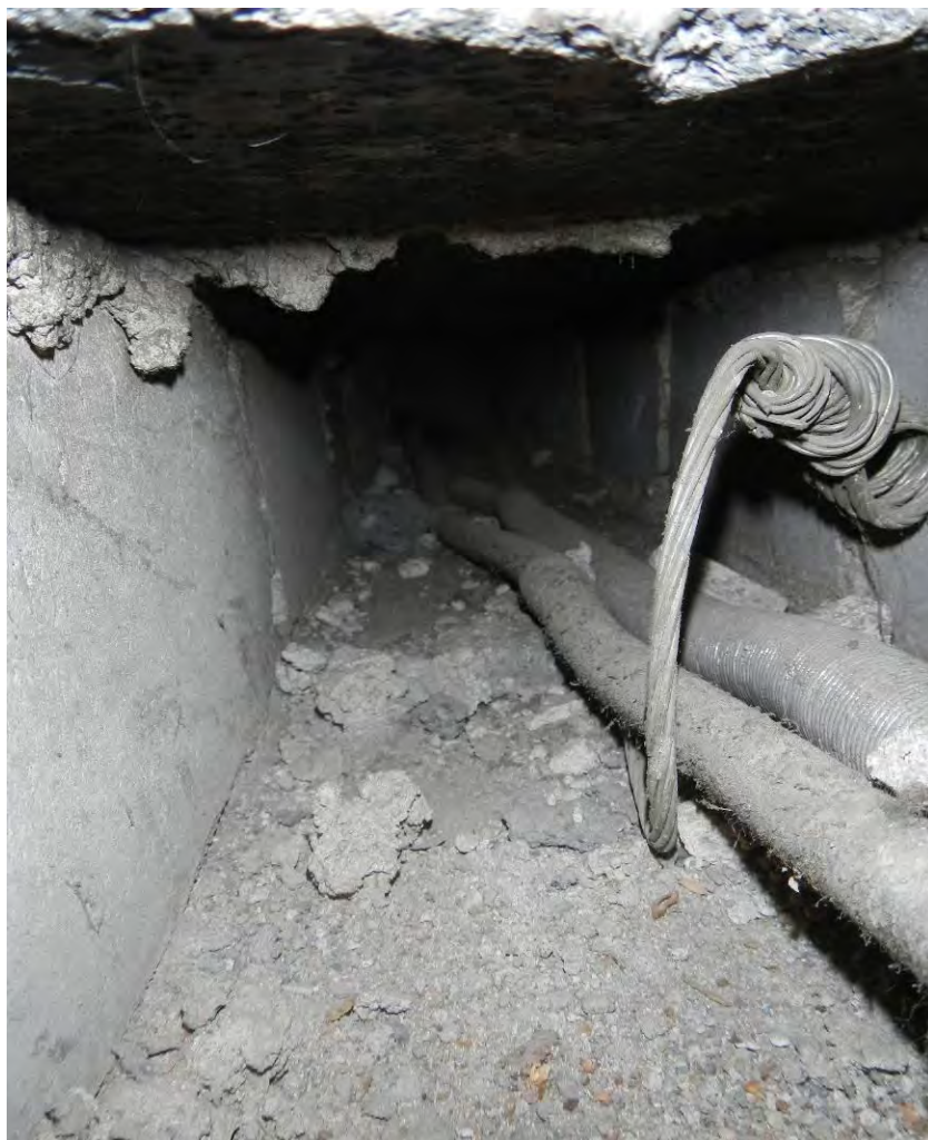
Kuva 31. Hormissa on sähkökaapeleita.
