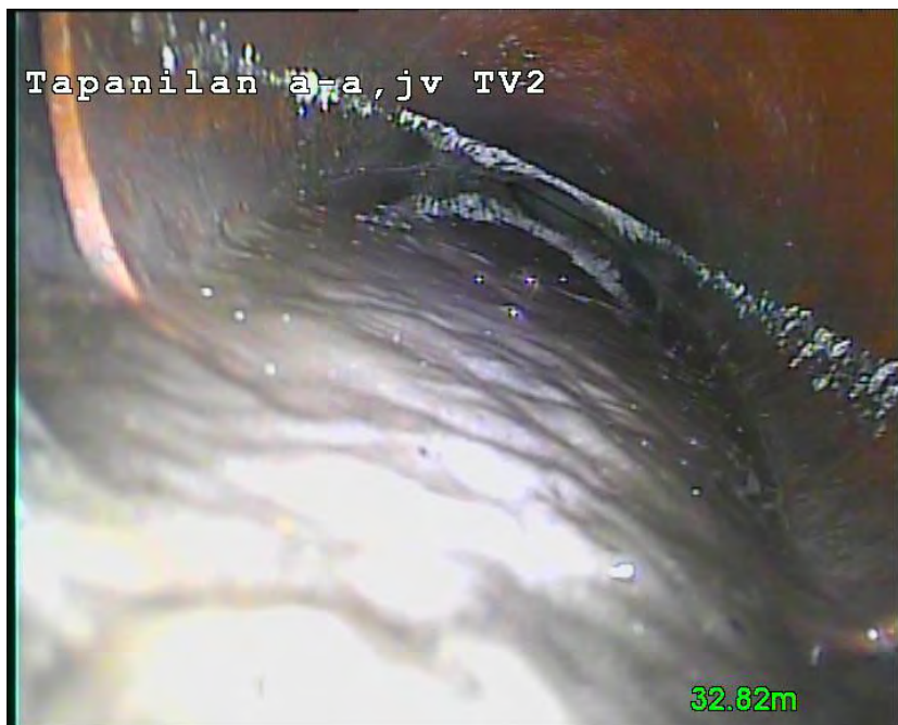
Kuva 18. Tonttviemäri on painunut voimakkaasti JVTK1 purkavan linjan osalta.
