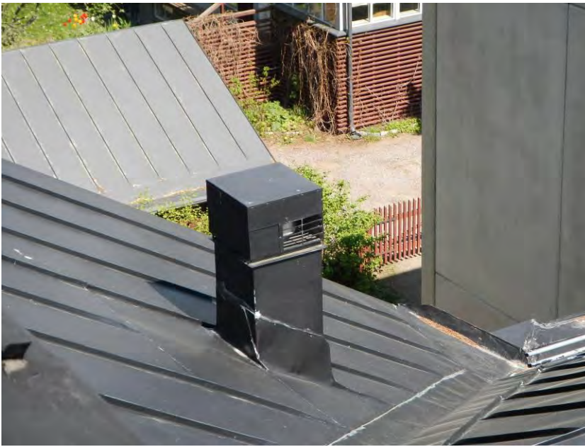
Kuva 22. Yleiskuva wc-tilojen huippuimurista.
