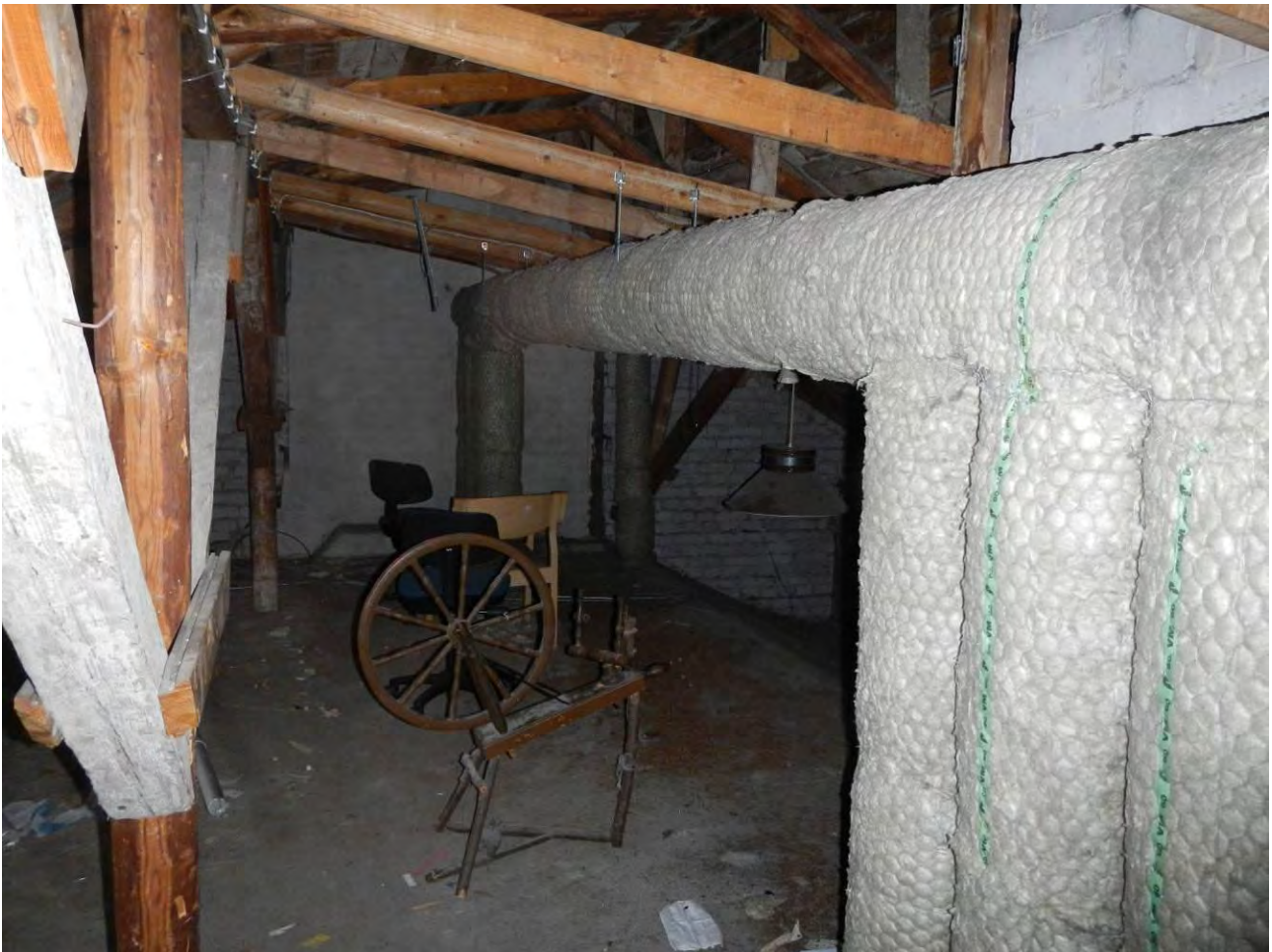
Kuva 42. Yleiskuva ullakon kanavaeristyksistä.
