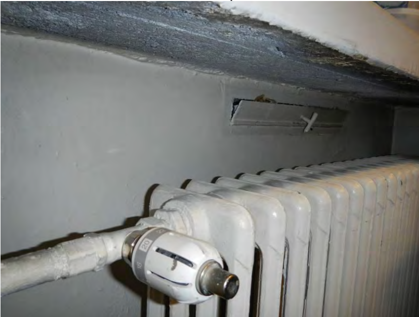
Kuva 37. Alkuperäiset korvausilmaventtiilit ovat tukittu.
