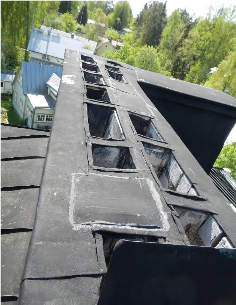
Kuva 33. Osa hormien yläpäistä on tulpattu peltilätkällä.
