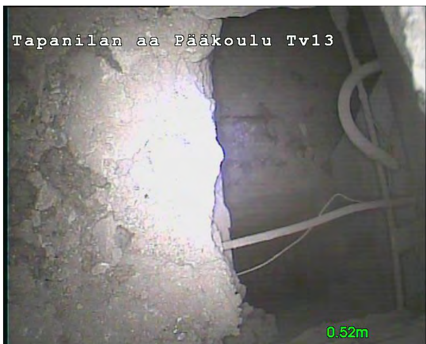
Kuva 26. Yleiskuva hormista, hormissa on rautoja näkyvillä.
