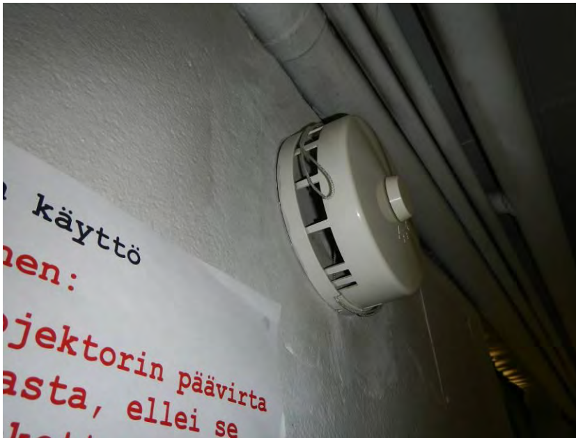
Kuva 38. Uudemmat korvausilmaventtiilit ovat varustettu suodatusmahdollisuudella.
