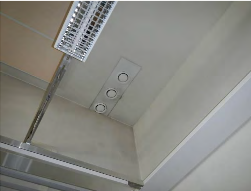
Kuva 36. Yleiskuva koneellisen poiston venttiileistä.
