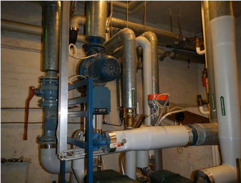
Kuva 46. Yleiskuva rakennusautomaation kenttälaitteista.
