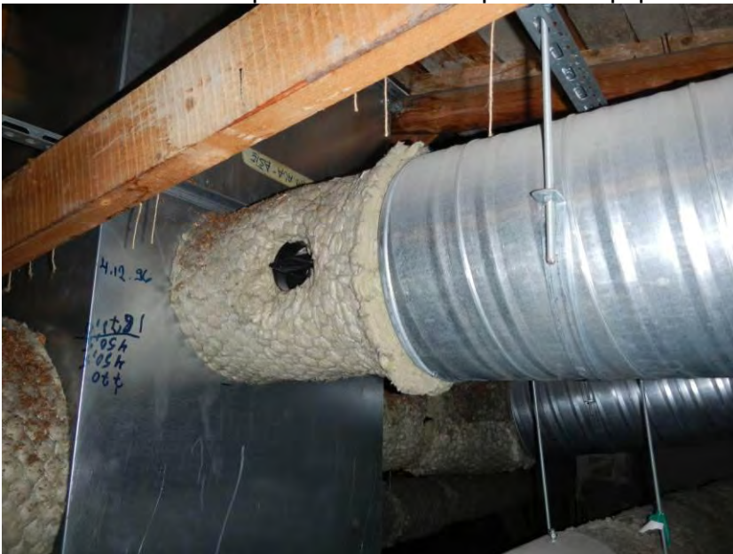
Kuva 24. Säätopelleissä ei havaittu mittayhteitä.
