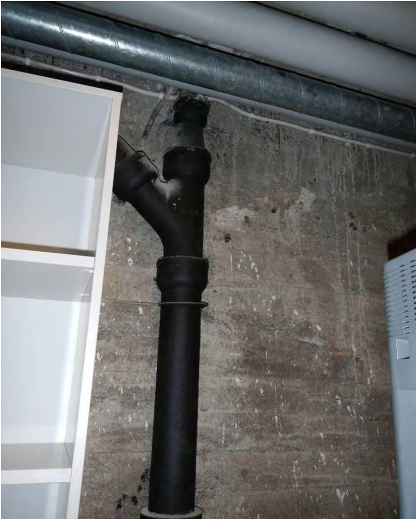
Kuva 13. Viemärit ovat osittain alkuperäiset.
