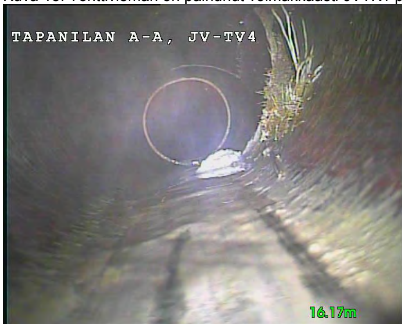
Kuva 19. Viemärin oikeassa kyljessä on juurikasvustoa.
