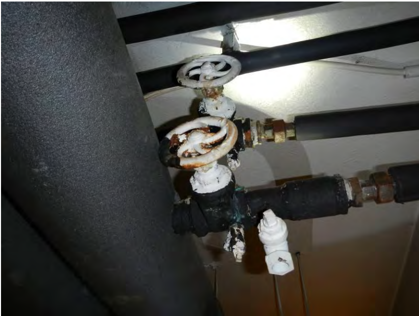
Kuva 4. Vanhoilla linjaventtiileillä ei ole mahdollista säätää verkostojen virtaamia.
