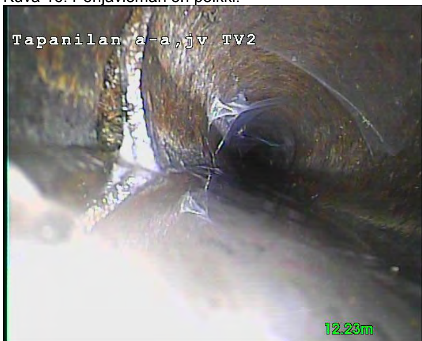
Kuva 17. Pohjaviemäri on poikki.
