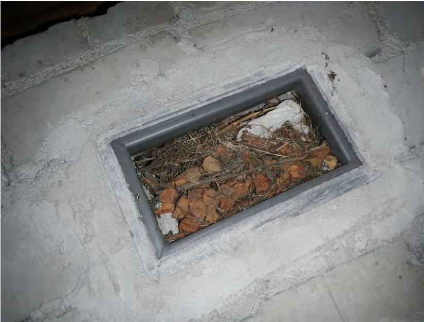
Kuva 29. Hormi on tukossa (mahdollinen linnunpesä / vastaava).
