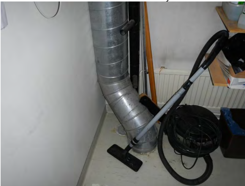
Kuva 43. Yleiskuva paloalueiden välisestä eristetystä nousukanavasta.
