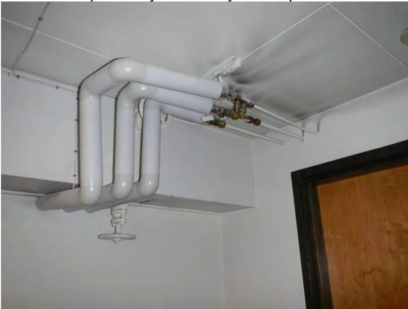
Kuva 9. 1980-luvulla asennetut / uusitut kylmävesiputket ovat kupariputkia.
