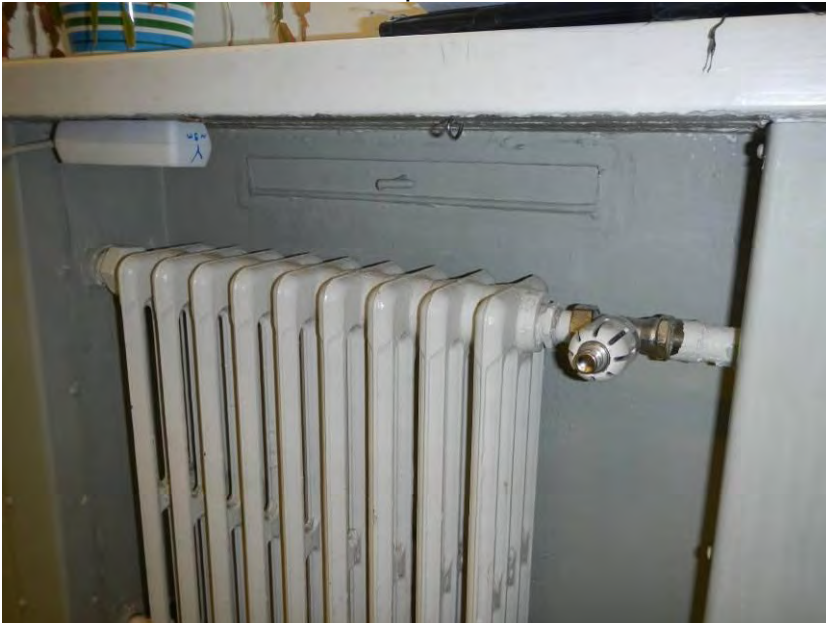
Kuva 6. Yleiskuva uudemmassa patteriventtiilistä.
