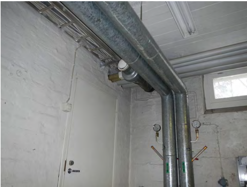
Kuva 20. Yleiskuva lämmönjakohuoneen poistoilmapuhaltimesta.
