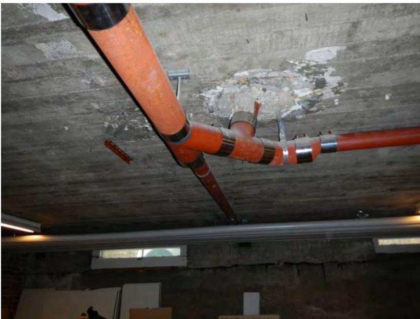
Kuva 14. 1980-luvulla on tehty muutoksia ja viemäreitä on lisätty.
