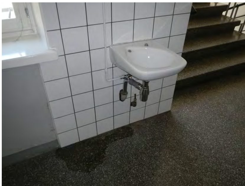
Kuva 15. Juomahanan vuotava viemäri tulee korjata.
