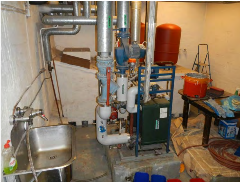
Kuva 3. Yleiskuva lämmönjakuhuoneen laitteista.
