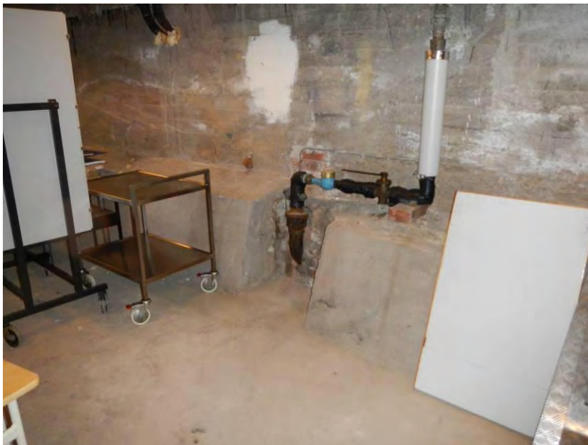
Kuva 7. Yleiskuva vesimittarista ja pääsulkuventtiileistä.
