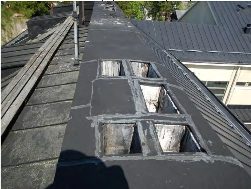
Kuva 34. Osa hormien yläpäistä on tulpattu peltilätkällä.
