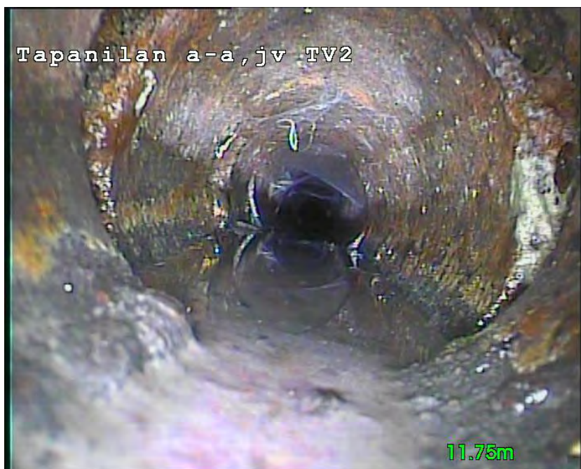
Kuva 16. Pohjaviemäri on poikki.
