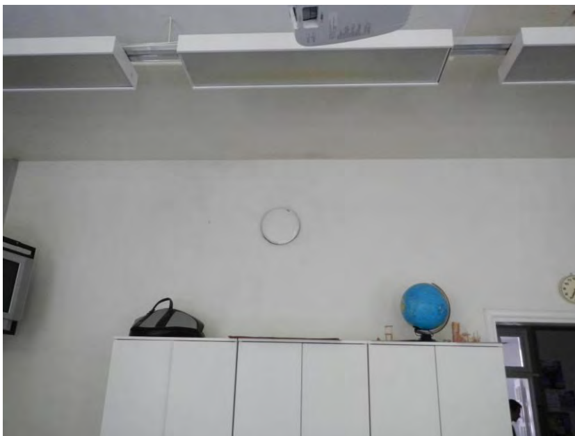
Kuva 35. Yleiskuva painovoimaisen ilmanvaihdon lautasventtiileistä.
