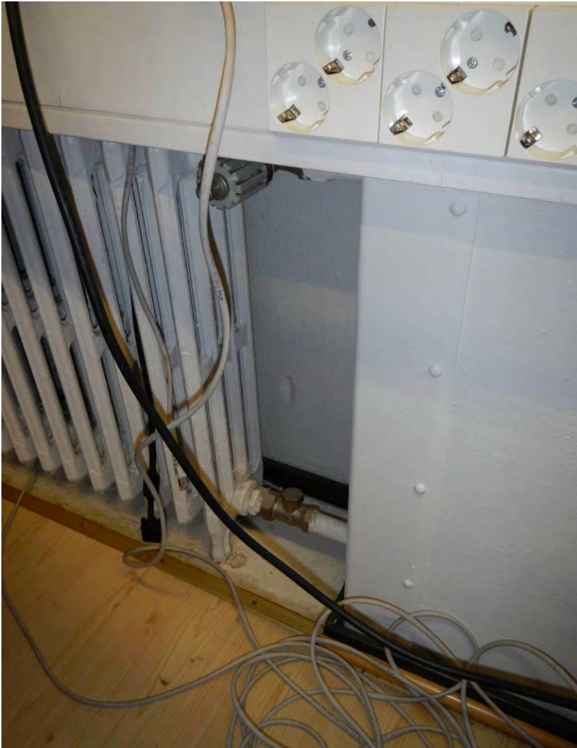
Kuva 5. Yleiskuva vanhasta patteriventtiilistä.
