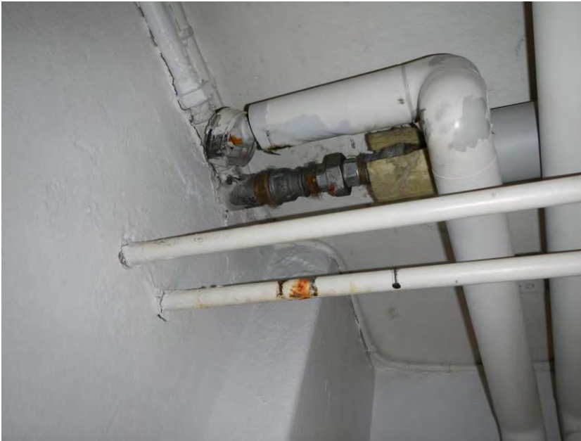
Kuva 8. Alkuperäiset ja vanhat kylmävesiputket ovat kuumasinkittyä teräsputkea.
