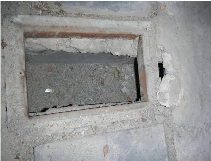
Kuva 27. Hormin puhdistusluukun kehyksen tiiveys on puutteellinen.
