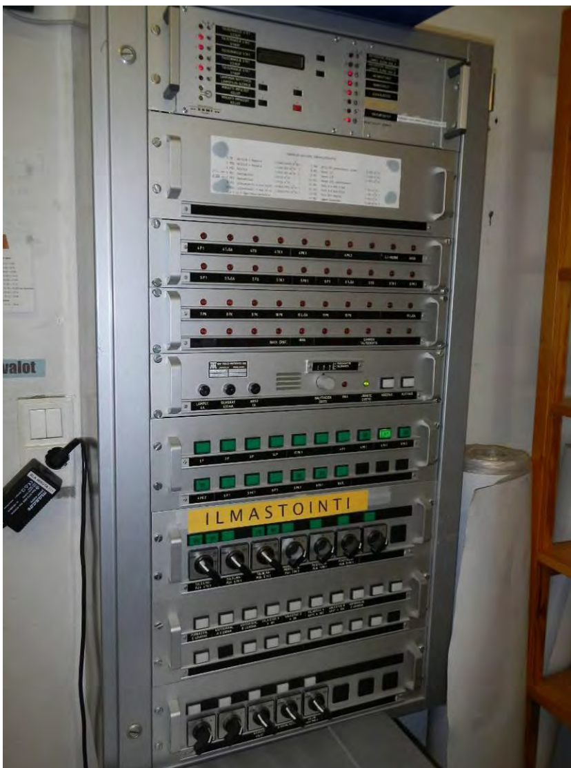
Kuva 44. Yleiskuva kouluisännän huoneessa olevasta hälytys- ja ohjauskeskuksesta.
