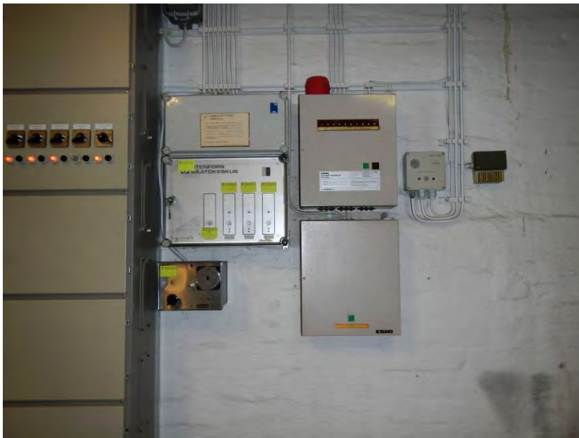
Kuva 45. Yleiskuva lämmönjakohuoneen säätokeskuksista.
