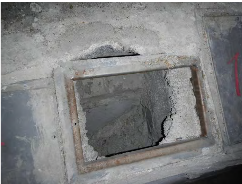
Kuva 28. Hormin puhdistusluukun kehyksen tiiveys on puutteellinen.
