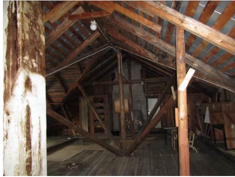
Kuva 24 Ullakkotilassa oli vesikaton puisia tukirakenteita.
