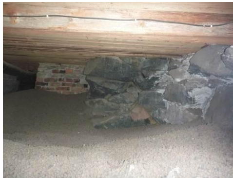
Kuva 8 Ryömintätilan pohjalla oli 200–300 mm paksu kerros kevytsoraa. Kevytsora vähentää maaperän mahdollista kosteusrasitusta. Ryömintätilassa oli kivilatomus todennäköisesti entisen uunin jäljiltä.
