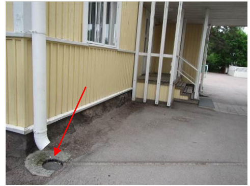
Kuva 5 Syöksytorvet on suunnattu sadevesikaivoihin
