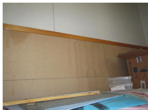
Kuva 41 Vesivuotojälkiä luokkahuoneen seinällä ja ilmoitustaululla (kattovuoto).
