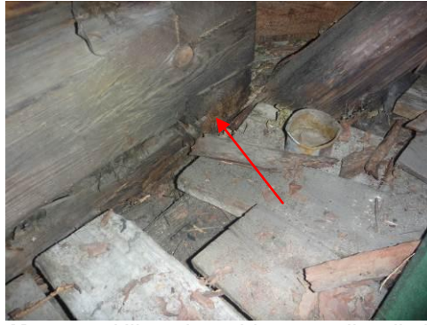
Kuva 35 Ulkoseinän hirressä oli paikallinen lahovaurio, joka johtuu todennäköisesti vesikattovuodosta
