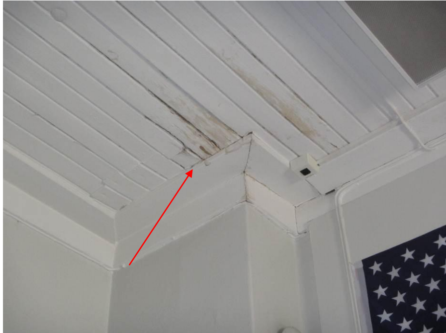
Kuva 30 Vesivuotojälki piipun juuressa 1. kerroksen katossa. Kuva luokasta 3.
