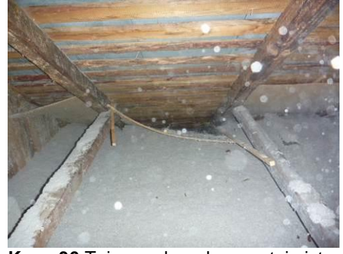
Kuva 36 Toisessa kerroksessa toimistotilojen kohdalla yläpohjassa oli puhallusvillaeristystä. Räystästuuletuksen varmistavien rakennuslevyjen kiinnitys oli paikoin pettänyt.
