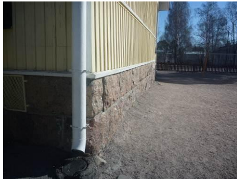
Kuva 4 Maa viettää lievästi rakennuksesta poispäin rakennuksen reunalla
