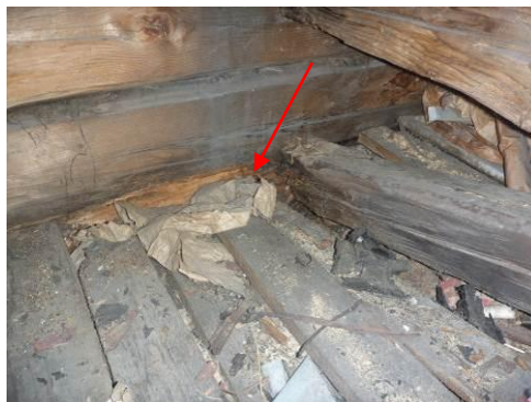
Kuva 28 Ulkoseinän hirressä oli paikallinen lahovaurio. Kuva ullakkotilasta.
