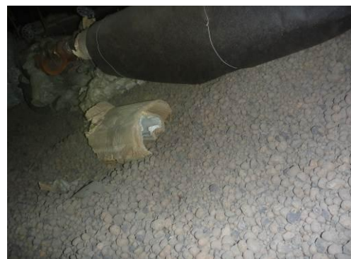
Kuva 11 Ryömintätilassa havaittiin rikoontunut, todennäköisesti asbestipitoinen, putkieriste
