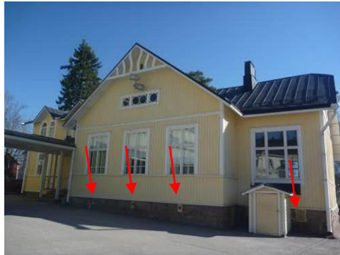
Kuva 6 Perusmuurissa oli riittävästi tuuletusaukkoja. Luonnonkivinen perusmuuri oli 60 ... 80 cm korkea.
