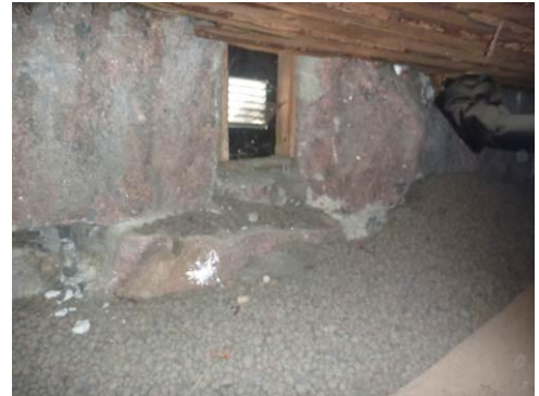
Kuva 7 Tuuletusaukoissa oli säleikkö. Luonnonkivisessä perusmuurissa ei ollut lämmöneristettä.
