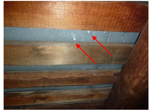
Kuva 27 Peltikatteessa oli muutama yksittäinen reikä, todennäköisesti lummenpudottajien jäljiltä
