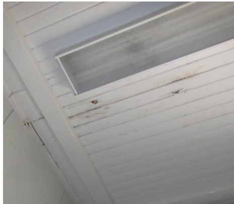
Kuva 31 Vesivuotojälki luokahuoneen katossa. Kuva luokasta 2.
