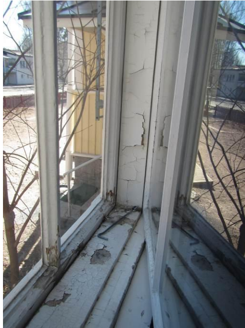
Kuva 20 Maali irtoili paikoin ikkunoiden ulkopuutteesta ja karmista.
