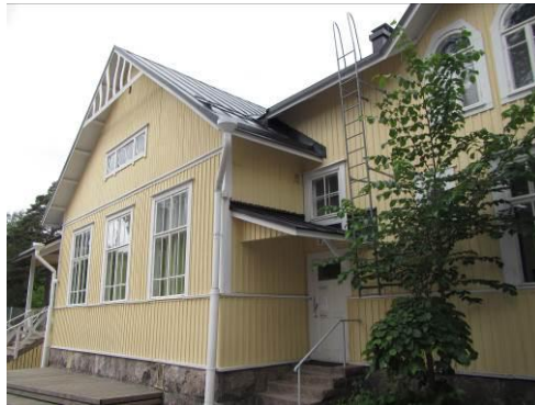
Kuva 26 Portaikkoon johtavan sisäänkäynnin katoksella ei ole jalkaränniä. Vesi pääsee valumaan vapaasti ulkoseinälle.
