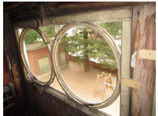
Kuva 23 Kylmän ullakkotilan ikkunat olivat yksilasisiä
