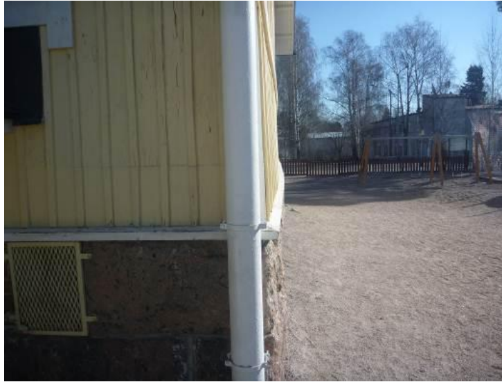
Kuva 14 Ulkoverhous oli lievästi pullistunut ulospäin rakennuksen eteläseinällä
