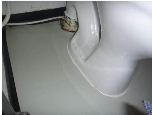
Kuva 42 Henkilökunnan mukaan 1. kerroksen WC:ssä on tulvinut toistuvasti vettä lattialle, syynä todennäköisesti huonokuntoinen viemäri. Tutkimushetkellä WC oli käyttökiellossa. WC:n lattia-rakenteessa voi olla vaurioita. Rakennevauruksia ei tehty rakenteiden kastumisriskin vuoksi.
