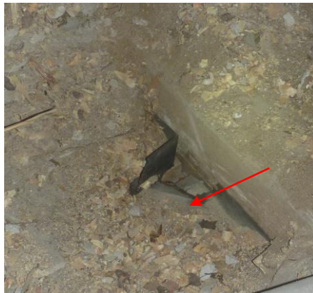
Kuva 37 Yläpohjan hiekka-/purueristeen alla oli musta tervapaperi
