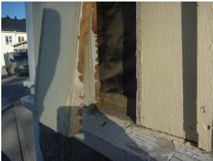
Kuva 17 Ulkolaudoituksen alareuna oli kiinni vaakalistassa, mikä myös estää laudoituksen takana olevan ilmaraon tuulettumisen
