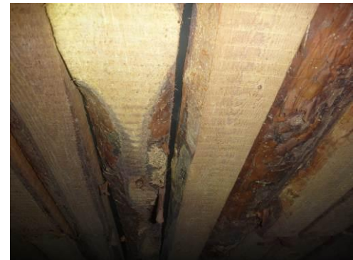
Kuva 9 Alapohjan alapinnassa oli tervapaperi ja laudoitus. Laidoitus ei ollut alkuperäinen. Laidoituksessa ja tervapaperissa ei havaittu epätiiveyskohtia.
