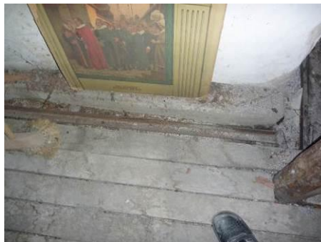
Kuva 33 Savupiipun vieressä laudoituksella oli vanhoja vesivuodonjälkiä
