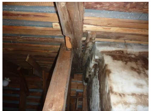
Kuva 29 Savupiipun juuressa on ollut vesivuoto. Kuva ullakkotilasta.
