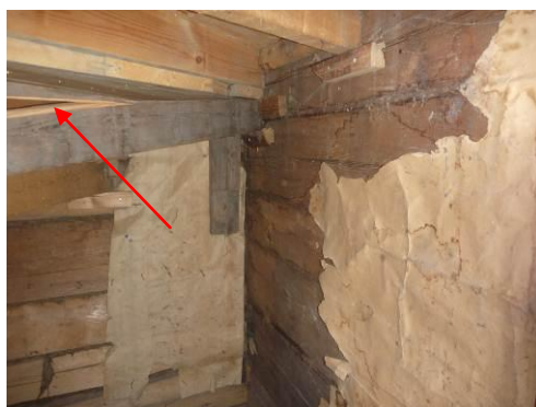
Kuva 40 Toiseen kerrokseen johtavissa portaissa porrasaskelmaa kannatteleva puusoiro oli haljennut. Seinällä oli vanhoja vesivuotojälkiä.
