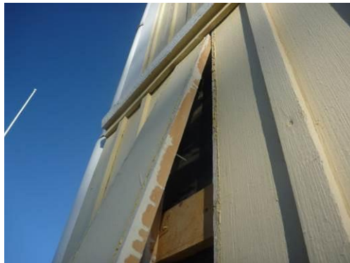
Kuva 15 Julkisivuverhouksen takana on vaakakoolaus ja tervapaperi. Rakenne ei tuuletettu, koska vaakakoolaus tukkii tuuletusraon. Verhouksen taustalle joutunut kosteus ei kuivu tehokkaasti.
