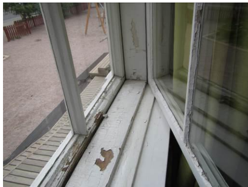
Kuva 22 Osassa ikkunoita ei ollut tiivisteitä
