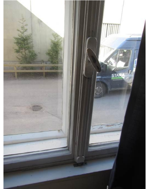
Kuva 21 Paikoin ikkunoiden puupinnat ovat hyväkuntoiset
