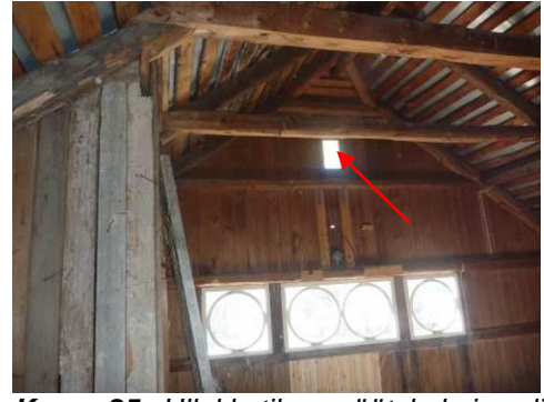
Kuva 25 Ullakkotilan päätykolmio oli kevytrakenteinen. Peltikatteella ei ollut aluskatetta. Ullakkotila tuulettui päätykolmiossa olevan tuuletusaukon (merkitty kuvaan nuolella) ja seinän rakojen kautta.
