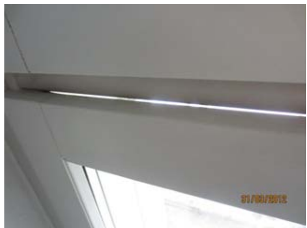
Kuvat 111-114: Ilmanvuotoja ikkunan vaakavälialueen ja puitteen välistä (37)
