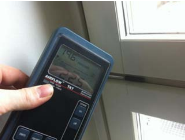
Kuvat 91-93: Ilmanvuotoja ikkunan karmin ja puitteen liitoksesta (30)
