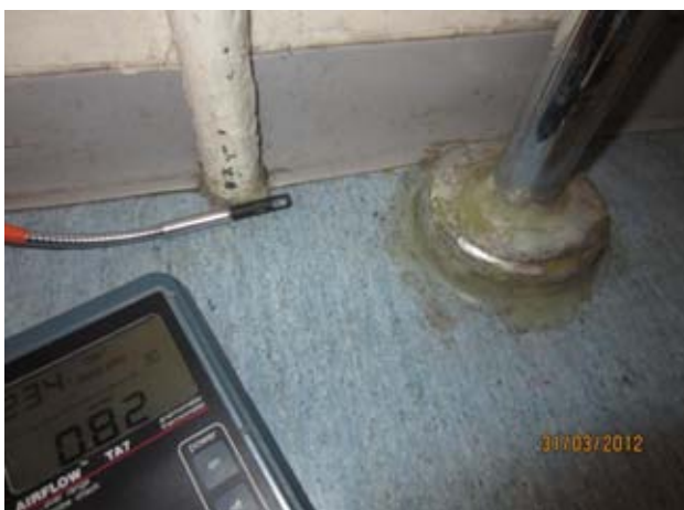
Kuvat 46-48: Ilmanvuotoja välipohjan läpiviennistä putkea varten (16)
