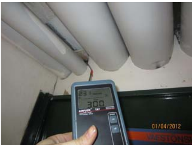
Kuvat 11-13: Ilmanvuotoja väestönsuojan vastaisessa seinässä olevista läpivienneistä (5)
