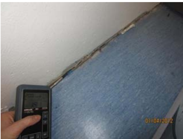
Kuvat 30-33: Ilmanvuotoja huoneiden välisen seinän ja välipohjan liitoksesta (10)
