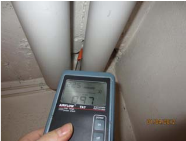
Kuvat 8-10: Ilmanvuotoja lämpöputkien läpivienneistä (4)
