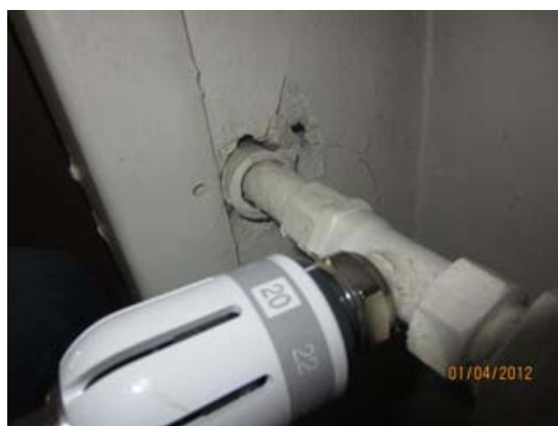
Kuvat 15-19: Ilmanvuotoja patterin vesiputkien ja ulkoseinän liitoksesta (6)
