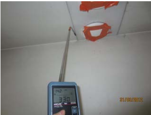
Kuvat 115-117: Ilmanvuotoja IV-venttiilien asennuslevyn takaa (38)
