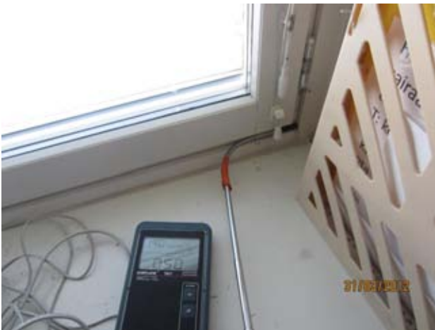
Kuvat 1-3: Ilmanvuotoja ikkunan puitteen ja karmin välistä (1)
