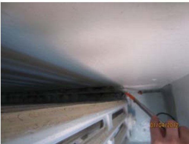
Kuvat 20-22: Ilmanvuotoja ulkoseinän ja välipohjan liitoksesta patterin takana (7)
