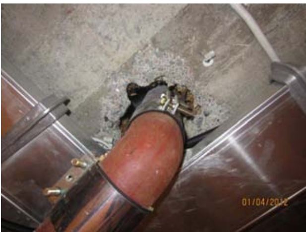
Kuvat 12-14: Ilmanvuotoja viemärin läpiviennistä (4)
