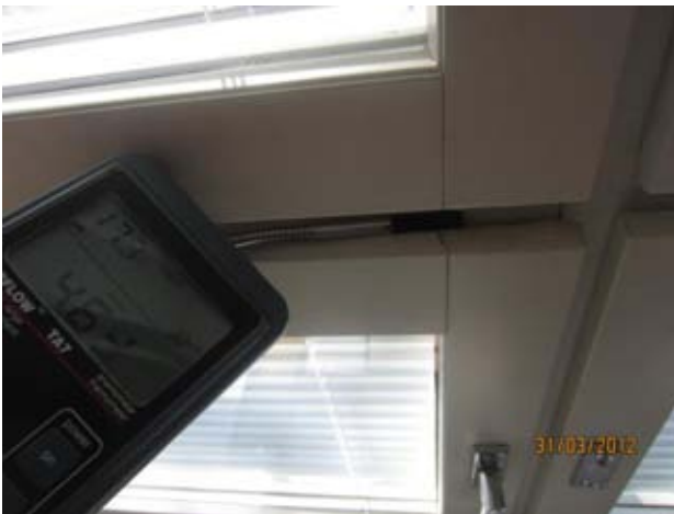
Kuvat 49-51: Ilmanvuotoja ikkunan vaakavälikarmin ja alapuitteen välistä (19)
