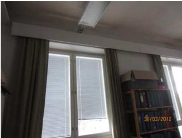
Kuvat 34 ja 35: Ilmanvuotoja ikkunan yläkarmin ja puitteen välistä (14)
