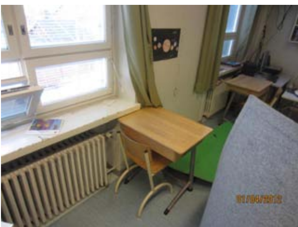
Kuvat 34 ja 35: Ilmanvuotoja patterisyyvennyksessä välipohjan ja ulkoseinän liitoksesta (11)
