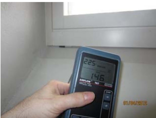
Kuvat 29-31: Ilmanvuotoja ikkunan karmin liitoksesta seinärakenteeseen (12)
