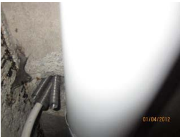
Kuvat 1-3: Ilmanvuotoja välipohjassa olevista sähköläpivientiputkista (1)
