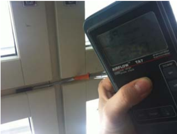
Kuvat 23-25: Ilmanvuotoja ikkunan karmin ja puitteen välistä (8)
