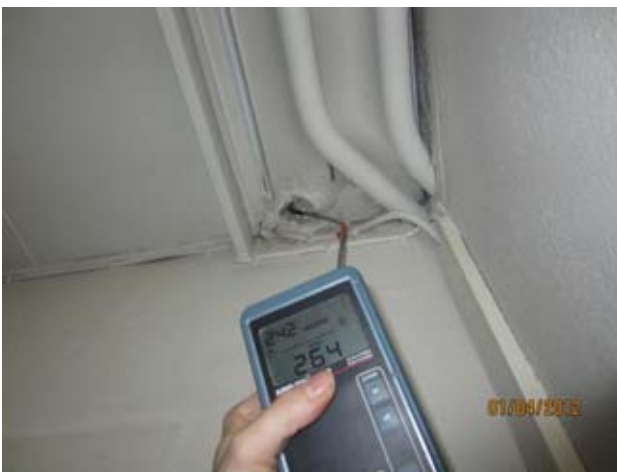
Kuvat 36-38: Ilmanvuotoja välipohjassa olevasta tiivistetystä läpiviennistä rakennuksen ulkonurkassa (15)
