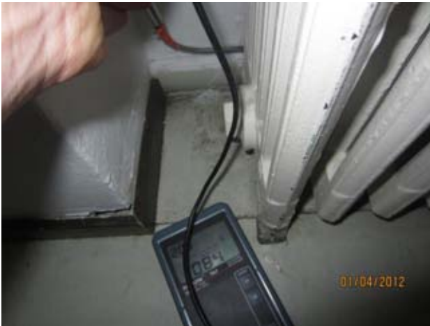
Kuvat 43-45: Ilmanvuotoja ulkoseinän ja välipohjan liitoksesta (15)
