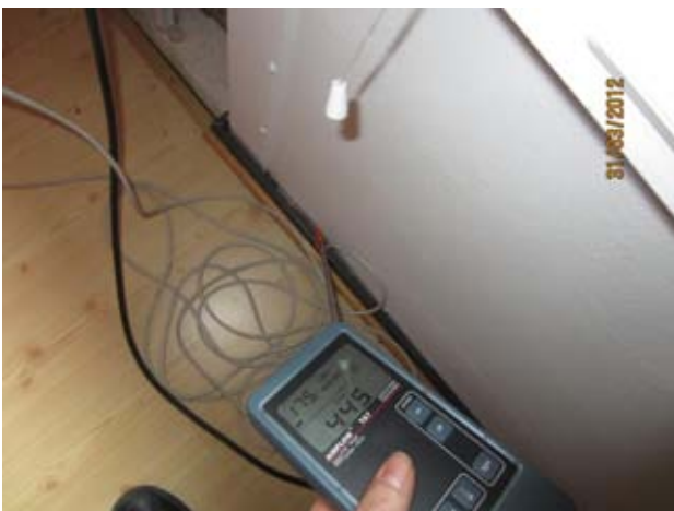
Kuvat 64-66: Suuria ilmanvuotoja ulkoseinän ja lattiapäällysteen liitoksesta, havaittu myös savun avulla (24)
