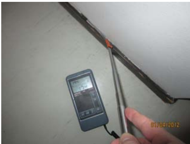
Kuvat 40-42: Ilmanvuotoja väliseinän ja välipohjan liitoksesta (14)
