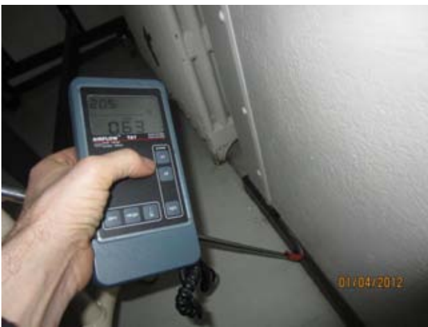
Kuvat 56-58: Ilmanvuotoja ulkoseinän ja välipohjan liitoksesta (19)
