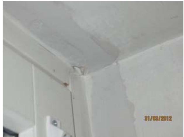
Kuvat 71-74: Ilmanvuotoja ikkunan karmin liitoksesta seinärakenteeseen (25)
