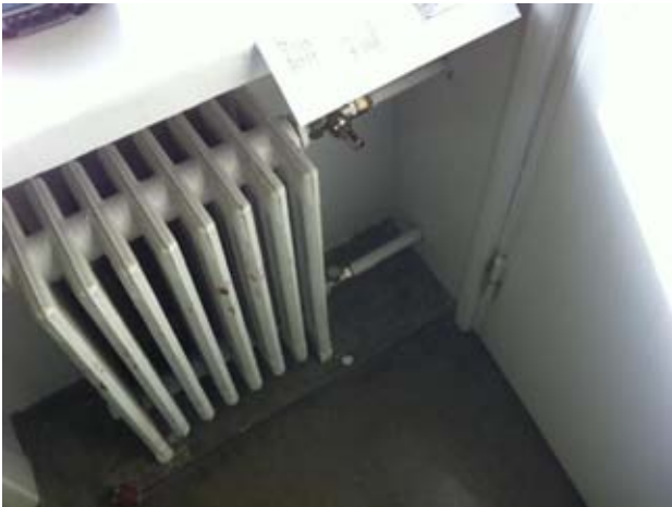
Kuvat 36 ja 37: Ilmanvuotoja seinän läpiviennistä patterin vesiputkea varten (12)
