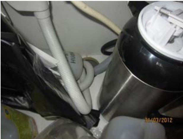
Kuvat 62 ja 63: Ilmanvuotoja allaskaapin pohjalevyssä olevasta reiästä (23)
