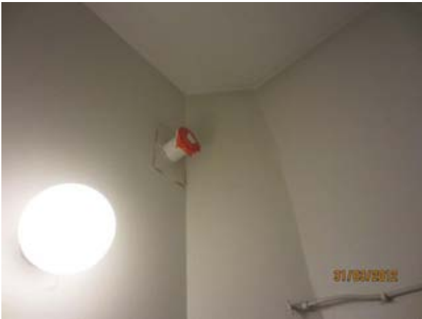
Kuvat 1 ja 2: Ilmanvuotoja IV-venttiilin kehyksen ja seinän liitoksesta (1)
