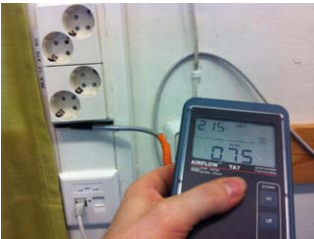
Kuvat 49-51: Ilmanvuoja sähkökotelosta, havaittu myös savun avulla (17)
