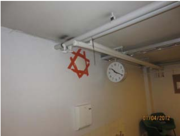
Kuvat 31 ja 32: Ilmanvuotoja WC:n vastaisessa seinässä olevasta läpiviennistä sähköjohtoja varten (10)
