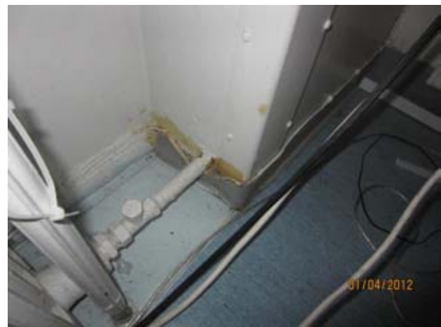
Kuvat 25-29: Ilmanvuotoja ulkoseinän ja välipohjan liitoksesta patterisyvennyksessä (9)
