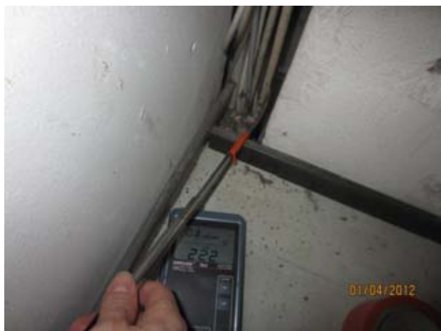
Kuvat 36 ja 37: Ilmanvuotoja välipohjan läpiviennistä sähköjohtoja varten (12)
