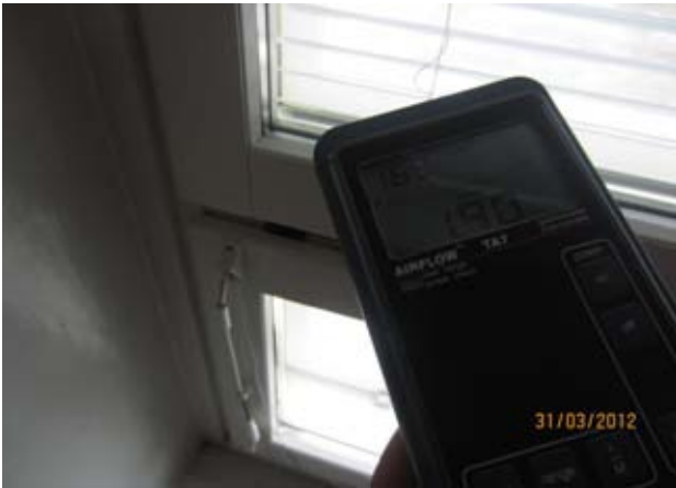
Kuvat 9-10: Ilmanvuotoja ikkunan karmin ja puitteen välistä (4)
