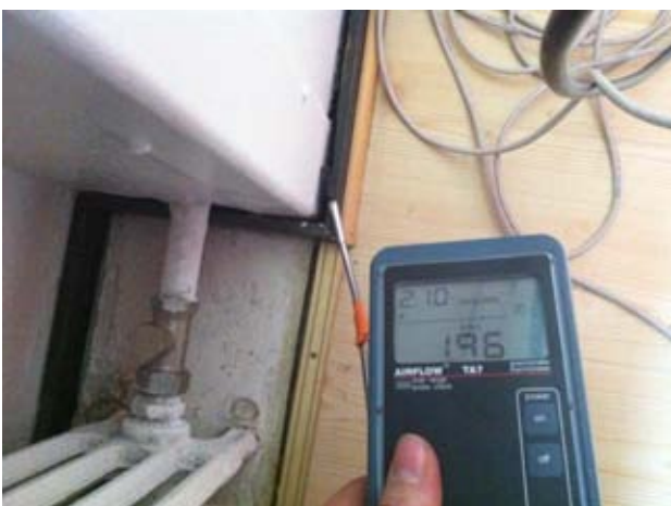
Kuvat 65-67: Ilmanvuotoja ulkoseinän ja lattiapäällysteen liitoksesta jalkalistan takaa (21)
