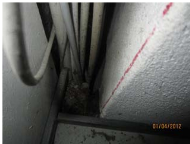
Kuvat 36 ja 37: Ilmanvuotoja välipohjan läpiviennistä sähköjohtoja varten (12)
