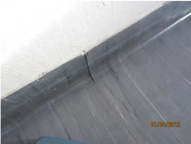
Kuvat 3-5: Ilmanvuotoja lattiapäällysteen saumasta (2)
