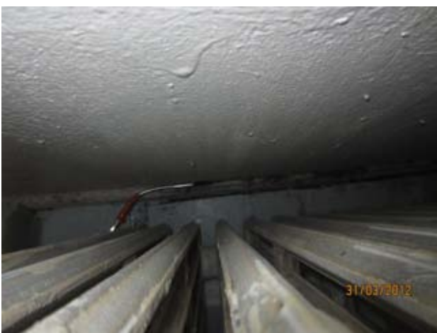
Kuvat 55-57: Ilmanvuotoja patterisyvennyksessä välipohjan ja ulkoseinän liitoksesta jalkalistan takaa (21)
