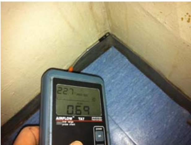
Kuvat 42-44: Ilmanvuotoja OT 3:n vastaisen väliseinän ja ulkoseinän nurkan liitoksesta lattiaan jalkalistan takaa (14)
