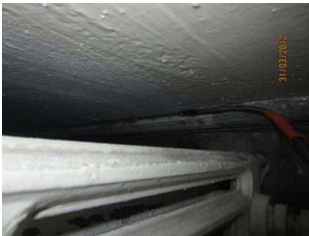
Kuvat 25-27: Ilmanvuotoja ulkoseinän ja välipohjan liitoksesta jalkalistan takaa patterisyvennyksessä (11)
