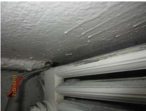
Kuvat 104-106: Ilmanvuotoja patterisyvennyksessä ulkoseinän ja välipohjan liitoksesta jalkalistan takaa (35)
