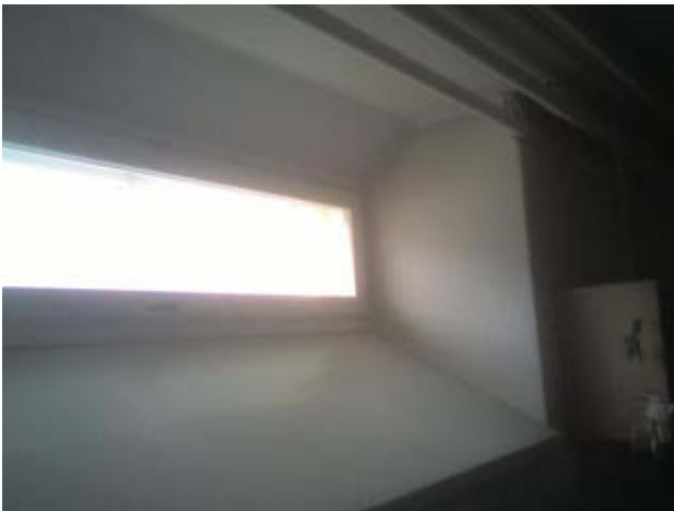
Kuvat 34 ja 35: Ilmanvuotoja ikkunan liitoksesta seinärakenteeseen (14)
