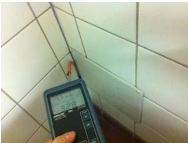
Kuvat 81-83: Ilmanvutoja pystykotelon tarkistusluukun reunoista (32)
