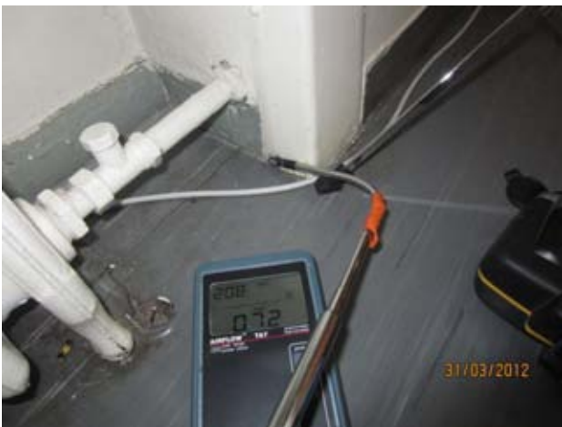
Kuvat 15-17: Ilmanvuotoja ulkoseinän ja välipohjan liitoksesta patterisyvennyksessä (7)
