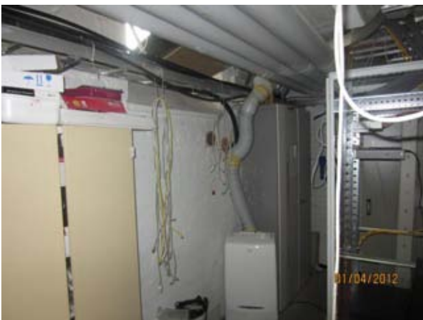
Kuvat 17 ja 18: Ilmanvuotoja ulkoseinässä olevasta puutteellisesti tiivistetystä läpivientiputkesta (7)
