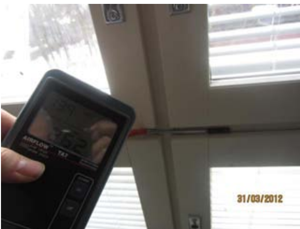
Kuvat 84-86: Ilmanvuotoja ikkunan vaakavälialueen ja puitteen välistä (28)
