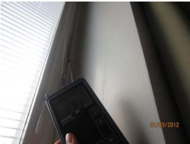
Kuvat 39-41: Ilmanvuotoja ikkunan karmin ja puitteen välistä (16)
