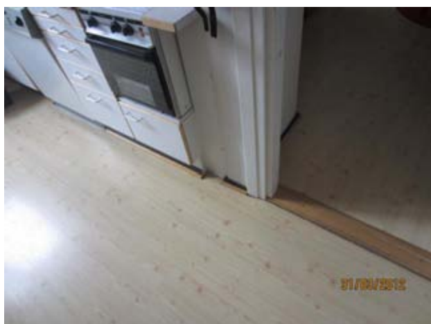
Kuvat 58 ja 59: Ilmanvuotoja johtajahuoneen vastaisen seinän ja lattiapäällysteen liitoksesta, havaittu myös savun avulla (21)
