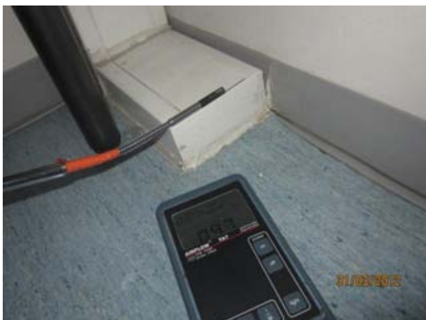
Kuva 45: Ilmanvuotoja huoneen nurkassa olevasta johtokotelosta, havaittu myös savun avulla (15)
