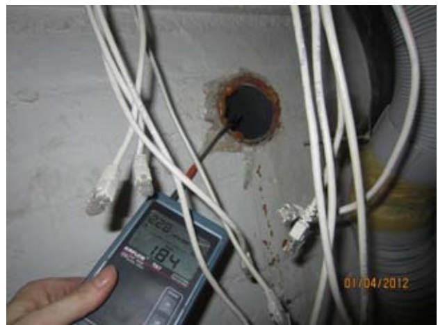
Kuvat 17 ja 18: Ilmanvuotoja ulkoseinässä olevasta puutteellisesti tiivistetystä läpivientiputkesta (7)
