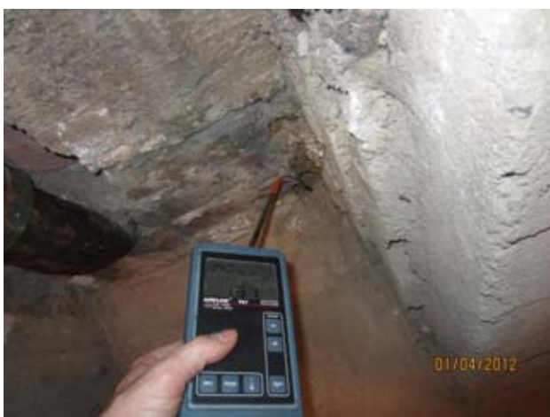
Kuvat 1-3: Ilmanvuotoja ulkoseinän ja alapohjan liitoksesta (1)
