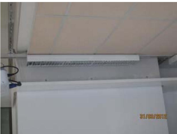
Kuvat 93 ja 94: Ilmanvuotoja kaapelisillan kiinnityspaikoista (31)
