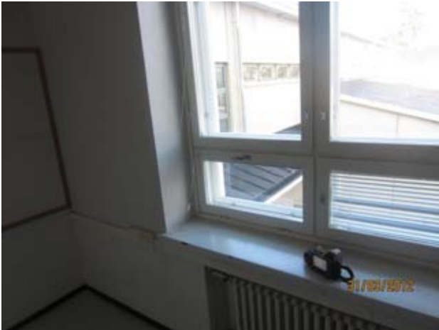
Kuvat 124 ja 125: Ilmanvuotoja ikkunan vaakavälikarmin ja puitteen välistä (41)
