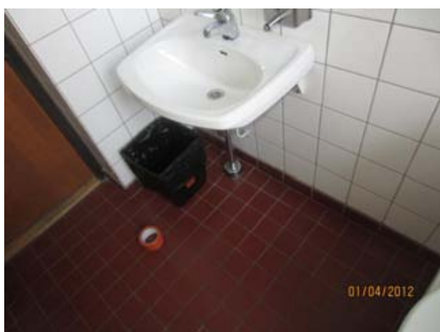
Kuvat 71 ja 72: Ilmanvuotoja viemärin liitoksesta välipohjaan (24)
