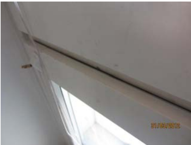
Kuvat 128-130: Ilmanvuotoja vaakavälialueen ja puitteen välistä (43)
