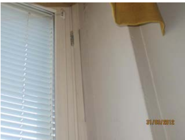
Kuvat 121-123: Ilmanvuotoja tiivistämättä jääneestä ikkunan vuorilistan ja seinän liitoksesta (40)
