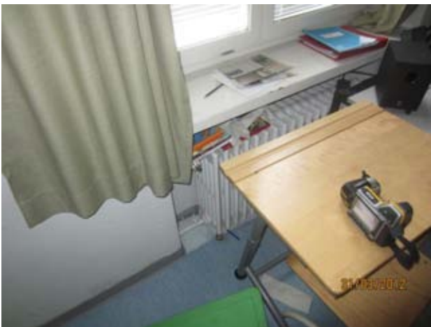
Kuvat 75 ja 76: Ilmanvuotoja patterisyvennyksessä välipohjan ja ulkoseinän liitoksesta jalkalistan takaa (26)
