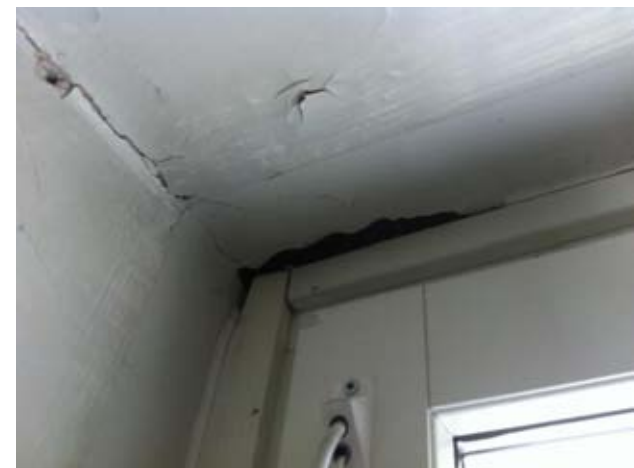
Kuvat 26-29: Ilmanvuotoja ikkunan karmin liitoksesta seinärakenteeseen (9)
