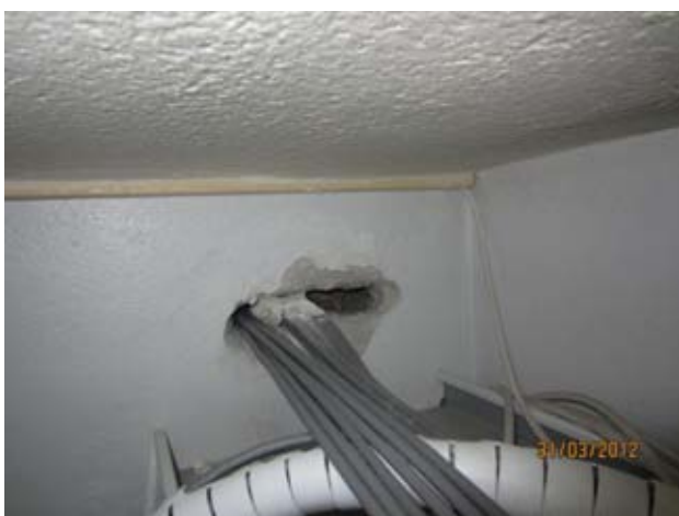
Kuvat 62-64: Ilmanvuotoja läpiviennistä johtoja varten (23)
