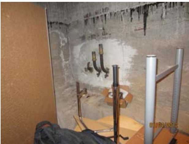
Kuvat 6 ja 7: Ilmanvuotoja puutteellisesti tiivistetystä ulkoseinän läpiviennistä (3)
