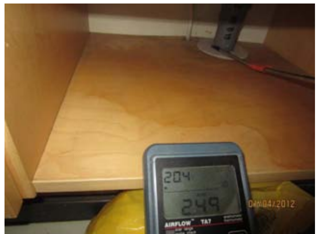
Kuvat 54 ja 55: Ilmanvuotoja kaapin pohjalevyssä olevasta viemäriputken läpiviennistä (18)
