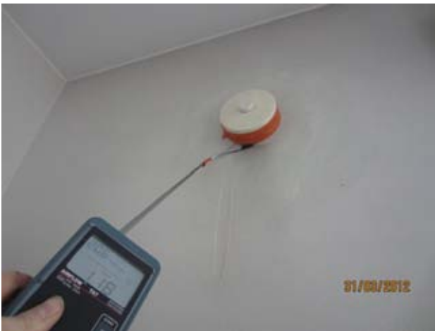
Kuvat 4-6: Ilmanvuotoja korvausilmaventtiin ja seinän liitoksesta (2)
