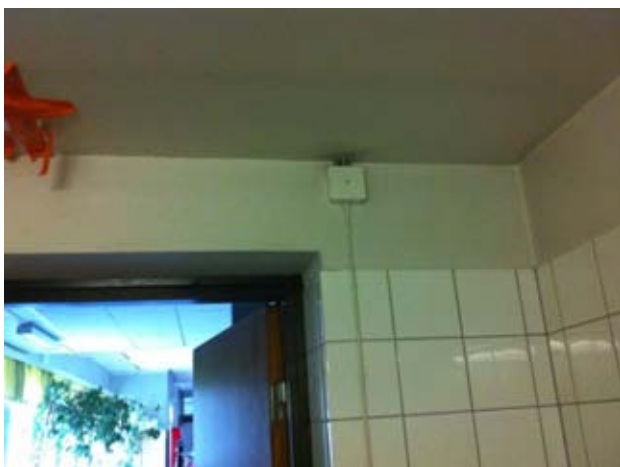
Kuvat 86 ja 87: Ilmanvuotoja alasasketussa katossa olevasta läpiviennistä sähköasennusta varten (28)
