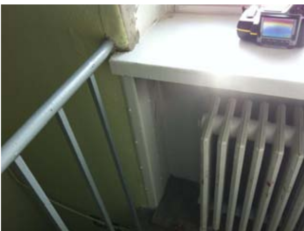
Kuvat 34 ja 35: Ilmanvuotoja patterisivyennyksen sivuseinässä olevasta halkeamasta (11)
