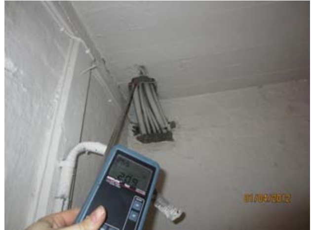
Kuvat 27 ja 28: Ilmanvuotoja välipohjassa läpiviennistä kaapeleita varten (8)
