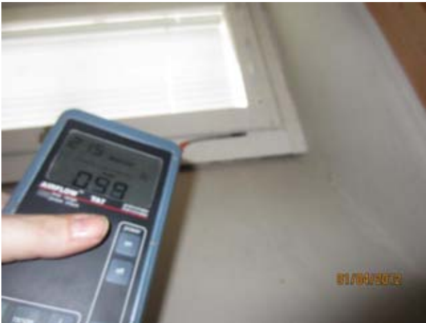
Kuvat 26-28: Ilmanvuotoja ikkunan karmin ja puitteen välistä (11)
