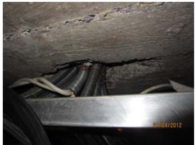
Kuvat 15-18: Ilmanvuotoja välipohjan läpiviennistä sähköjohtoja varten (5)
