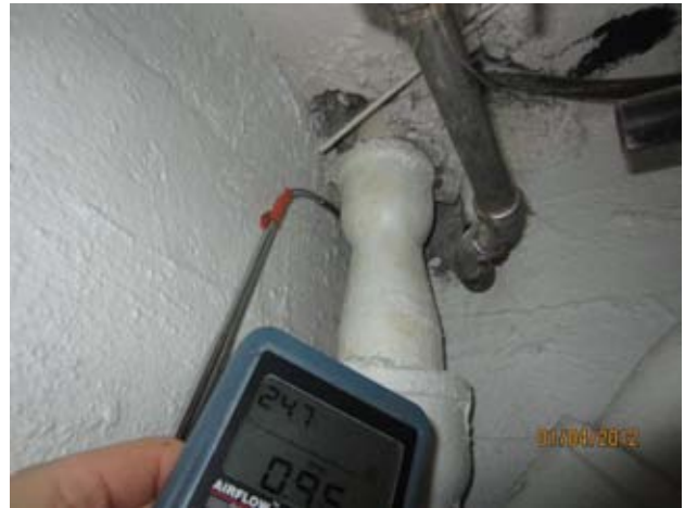
Kuvat 19-22: Ilmanvuotoja vesijohdon ja viemäriputken läpiviennistä sekä kannatinkoukun asennuspaikasta (6)
