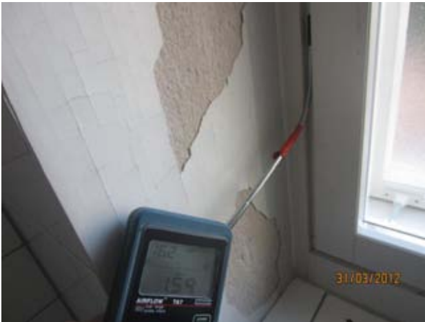
Kuvat 118-120: Ilmanvuotoja ikkunan karmin ja puitteen välistä (39)
