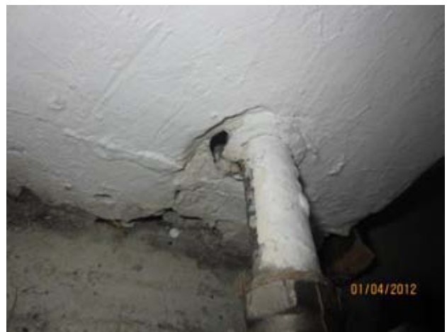
Kuvat 46-49: Ilmanvuotoja ulkoseinän ja välipohjan sekä ulkoseinän ja patterin vesiputken liitoksesta (16)
