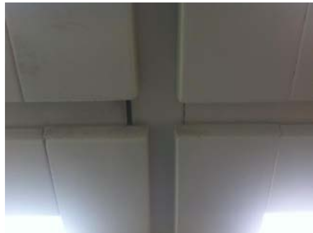
Kuvat 14-17: Ilmanvuotoja pysty- ja vaakavälialueen liitoksesta sekä karmin ja puitteen välistä (5)
