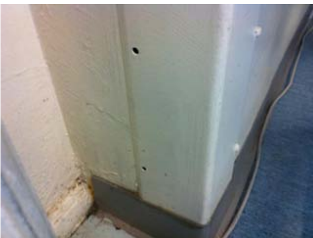
Kuvat 54-56: Ilmanvuotoja patterisyvennyksen nurkkasuojauksen takaa (18)
