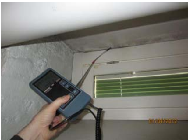
Kuvat 19-21: Ilmanvuotoja ikkunan karmin liitoksesta seinärakenteeseen (8)
