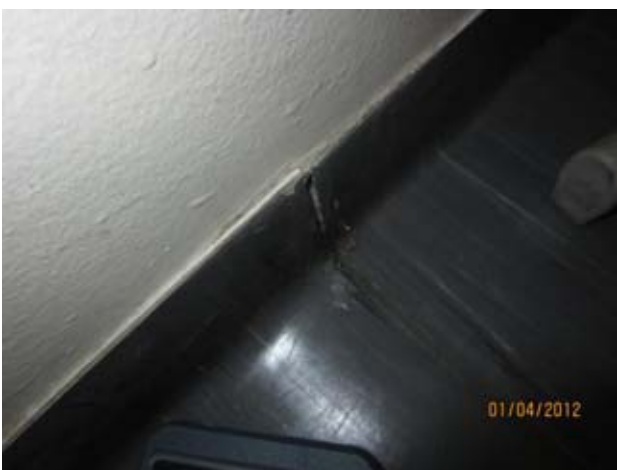
Kuvat 6-8: Ilmanvuotoja lattiapäällysteen saumasta (3)
