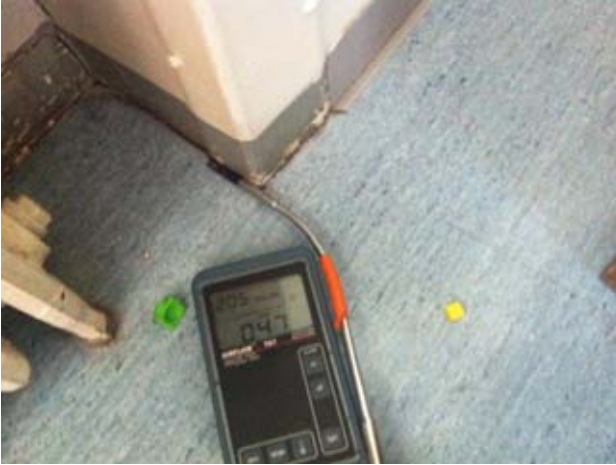
Kuvat 18-20: Ilmanvuotoja lattiapäällysteen ja seinän liitoksesta patterisyvennyksessä (6)
