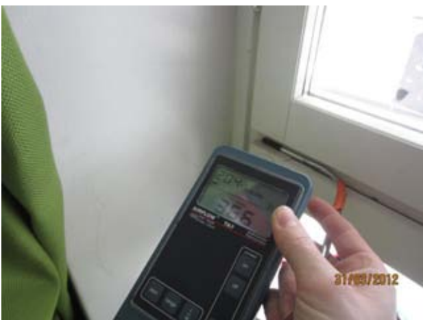
Kuvat 11-13: Ilmanvuotoja ikkunan karmin ja puitteiden välistä (4)
