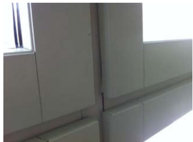
Kuvat 38-41: Ilmanvuotoja ikkunan pystyvälikarmin ja puitteen välistä (13)
