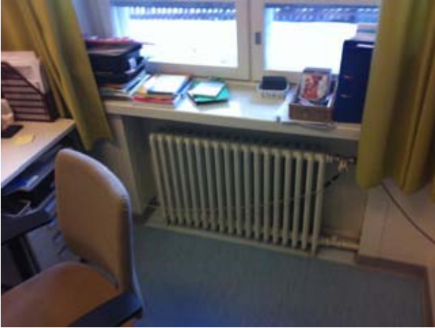
Kuvat 54 ja 55: Ilmanvuotoja ulkoseinän ja lattian liitoksesta patterisyvennyksestä, havaittu myös savua (19)
