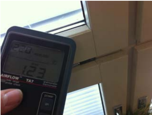
Kuvat 45-47: Ilmanvuotoja vaakavälikarmin ja puitteiden välistä (15)
