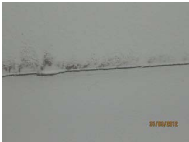
Kuvat 98-100: Ilmanvuotoja seinän ja katon välisestä halkeamasta (33)
