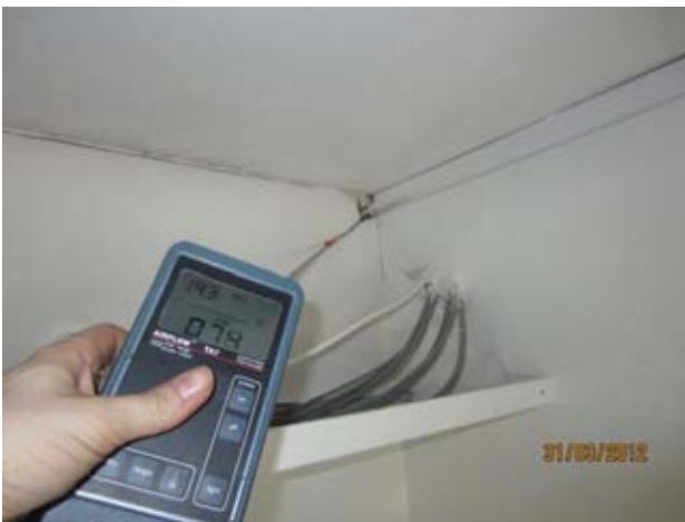
Kuvat 95-97: Ilmanvuotoja seinän läpiviennistä johtoja varten (32)
