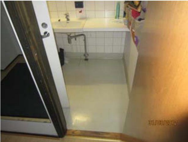
Kuvat 56 ja 57: Ilmanvuotoja välipohjan läpiviennistä viemäriä varten (20)
