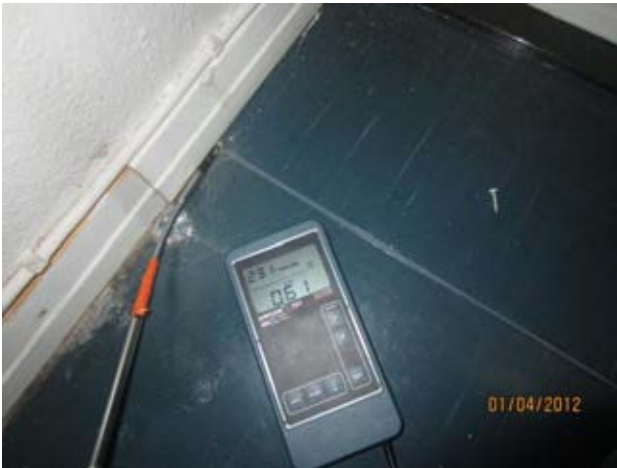
Kuvat 39-41: Ilmanvuotoja alapohjan ja ulkoseinän liitoksesta (16)
