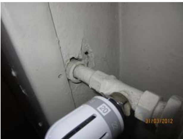
Kuvat31-33: Ilmanvutoja ulkoseinästä patteriputken kohdalla (13)
