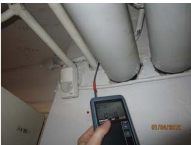
Kuvat 33-35: Ilmanvuotoja lämpöputkien läpiviennistä (11)
