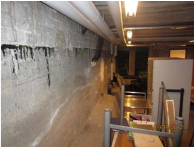
Kuvat 4 ja 5: Ilmanvuotoja puutteellisista johtojen läpiviennin tiivistyksistä (2)
