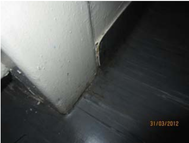
Kuvat 28-30: Ilmanvutoja välipohjan ja ulkoseinän liitoksesta lattiapäällysteen takaa (12)
