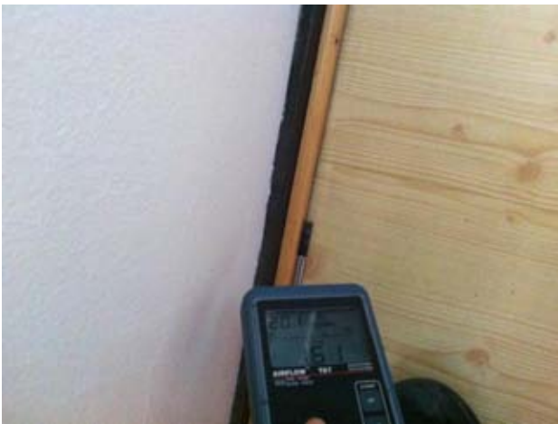
Kuvat 68-70: Suuria ilmanvuojoja ulkoseinän ja lattiapäällysteen liitoksesta jalkalistan takaa (22)
