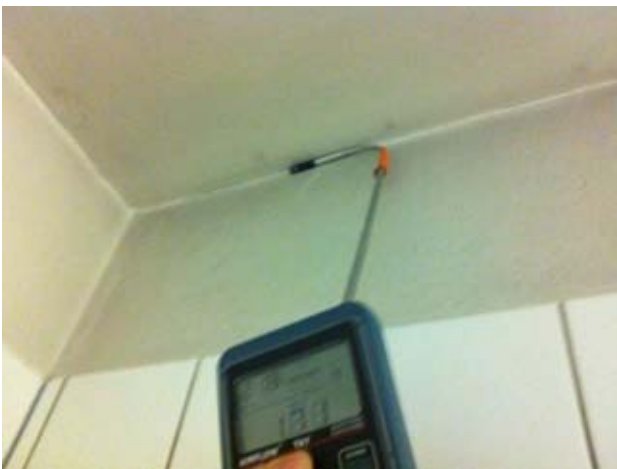
Kuvat 88-90: Ilmanvuotoja kotelorakenteen liitoksesta alaslaskettuun kattoon (29)
