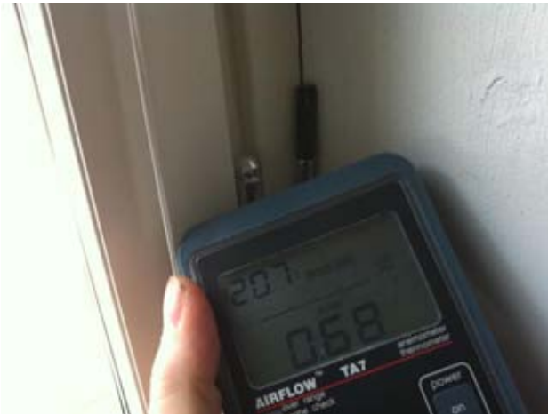
Kuvat 71-73: Ilmanvuotoja ikkunan karmin liitoksesta seinärakenteeseen (23)
