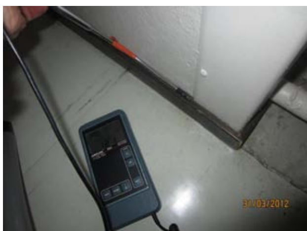
Kuvat 101-103: Ilmanvuotoja ulkoseinän ja välipohjan liitoksesta jalkalistan takaa (34)
