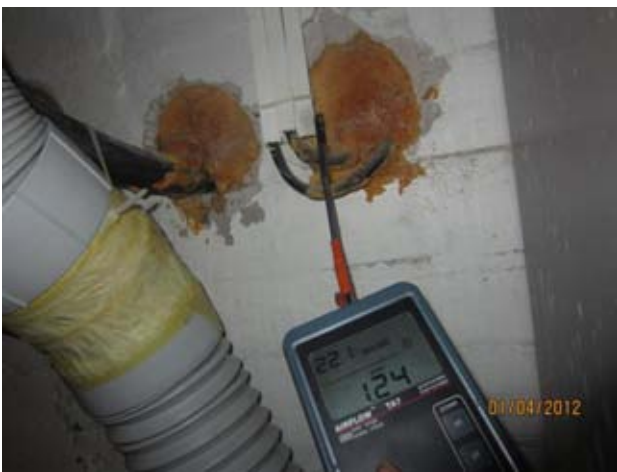
Kuvat 14-16: Ilmanvuotoja ulkoseinässä olevista läpivientien puutteellisista tiivistyksistä (6)
