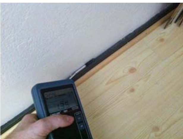
Kuvat 80-82: Ilmanvuotoja ulkoseinän ja kellarin vastaisen välipohjan liitoksesta jalkalistan takaa (26)
