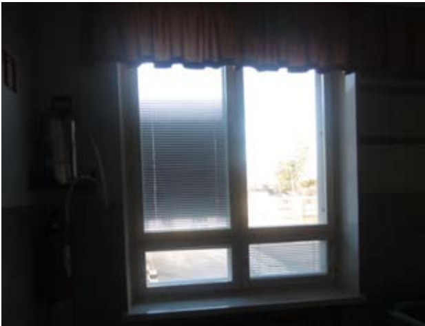
Kuvat 126 ja 127: Ilmanvuotoja ikkunan vaakavälikarmin ja puitteen välistä (42)
