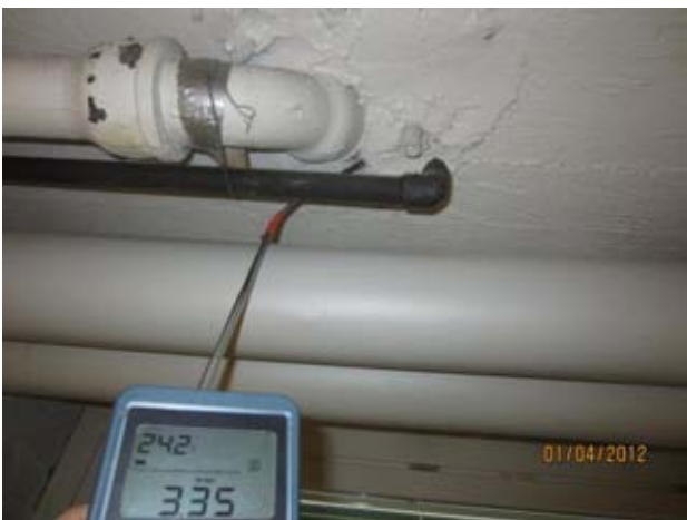
Kuvat 23-26: Ilmanvuotoja välipohjan läpiviennistä viemäriä varten sekä välipohjan betonissa olevasta reiästä (7)
