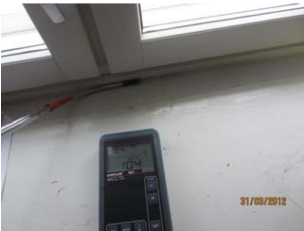
Kuvat 22-24: Ilmanvuotoja ikkunan alakarmin ja seinärakenteen välistä (10)
