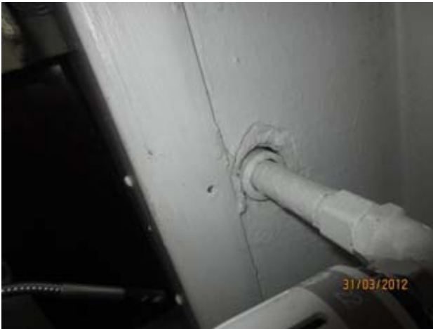
Kuvat 52-54: Ilmanvuotoja ulkoseinästä patteriputken liitoskohdasta (20)
