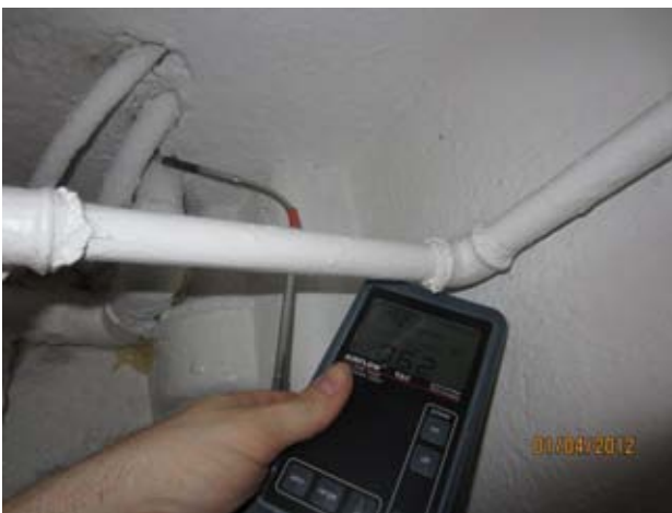
Kuvat 38-40: Ilmanvuotoja välipohjan läpivienneistä (13)
