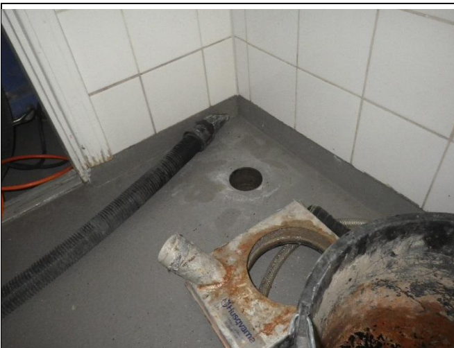
Kuva 14.3 Rakenneavaus.
