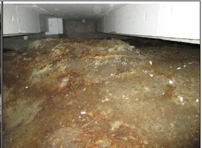
Kuva 8.2 Ryömintätilassa mikrobikasvustoa.
