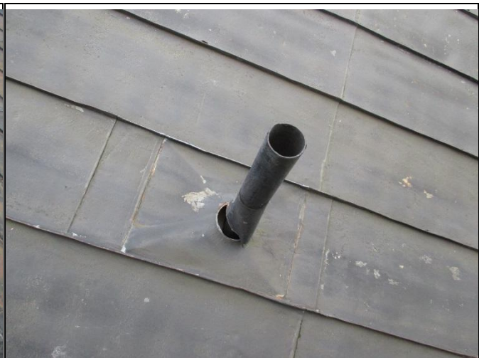
Kuva 18.2 Läpivienti epätiivis.
