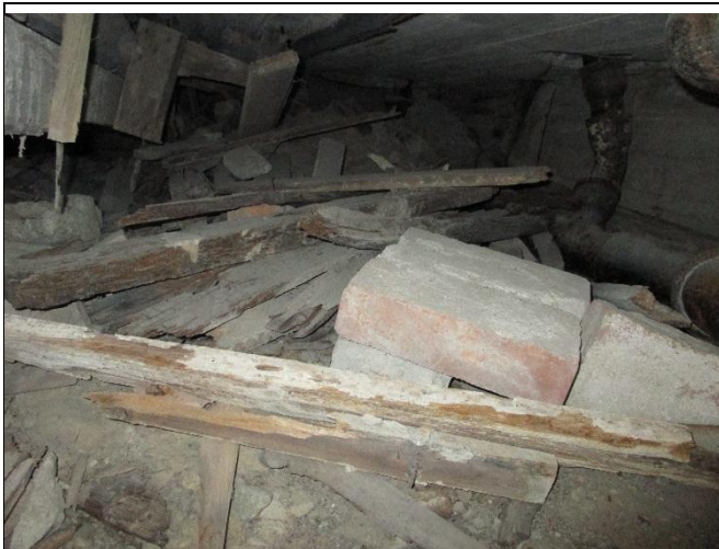
Kuva 8.1 Ryömintätilassa muottilautoja.
