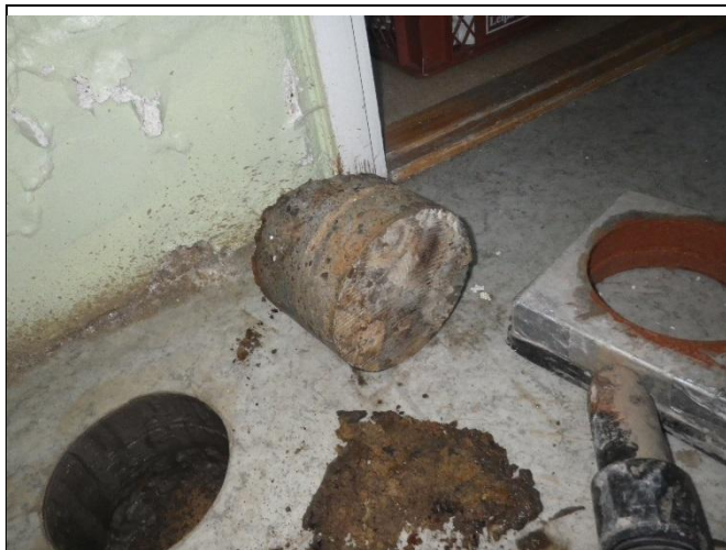
Kuva 7.2 Rakenneavaus.
