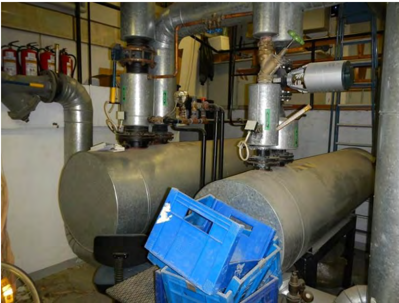
Kuva 1. Yleiskuva lämmönjakohuoneen laitteista.
