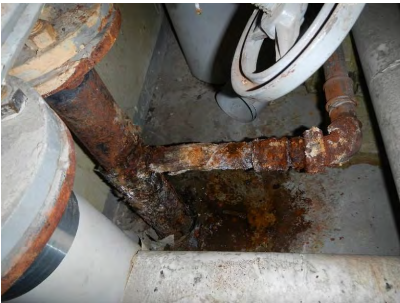
Kuva 2. Pumppuhuoneessa havaittiin vuotava venttiili.
