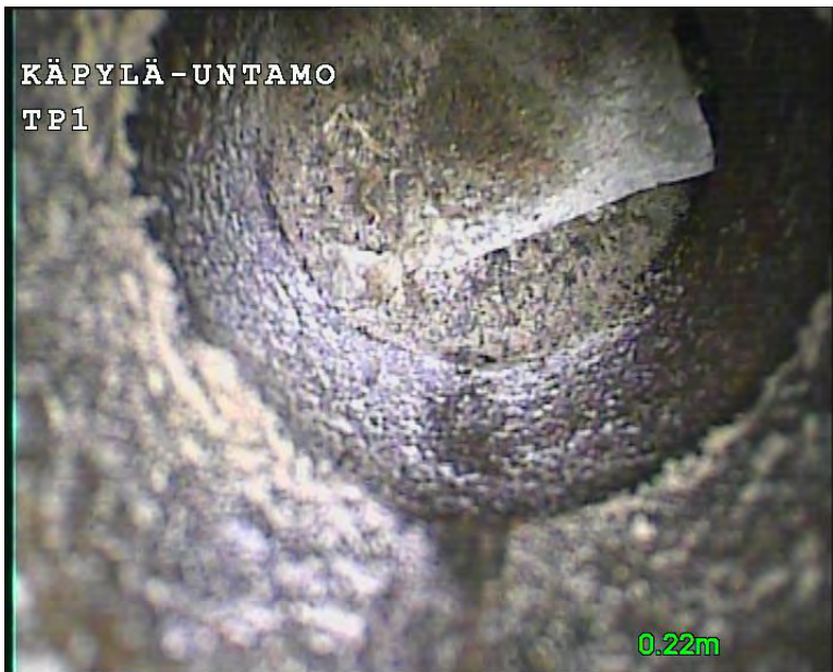
Kuva 8. Viemäri on tukossa.
