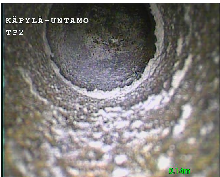
Kuva 9. Viemäri on tukossa.
