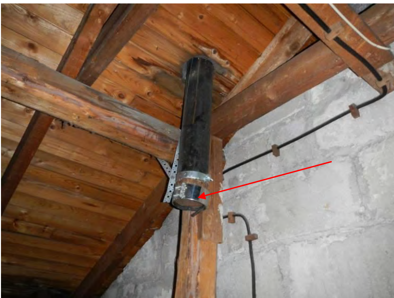
Kuva 5. Tuuletusviemärit ovat osittain irti muhveista.
