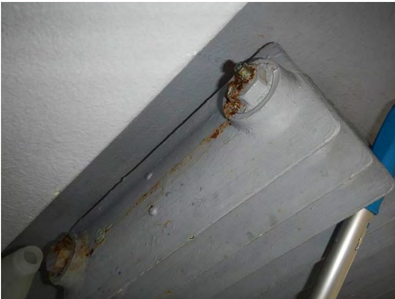
Kuva 4. Ilmausruuvit tulee tarkastaa ja korjata vuotavat.
