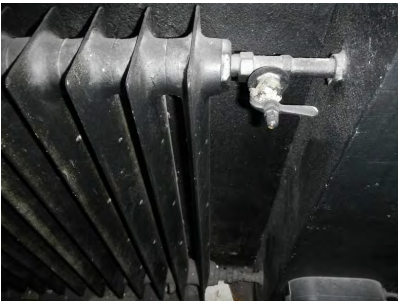
Kuva 3. Yleiskuva vanhasta patteriventtiilistä.
