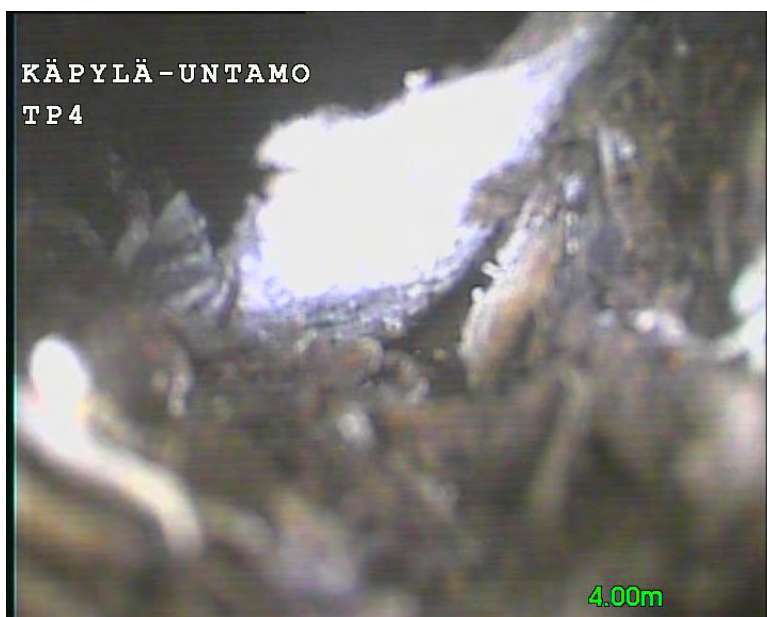
Kuva 10. Viemärissä on kuivunutta kertymää.
