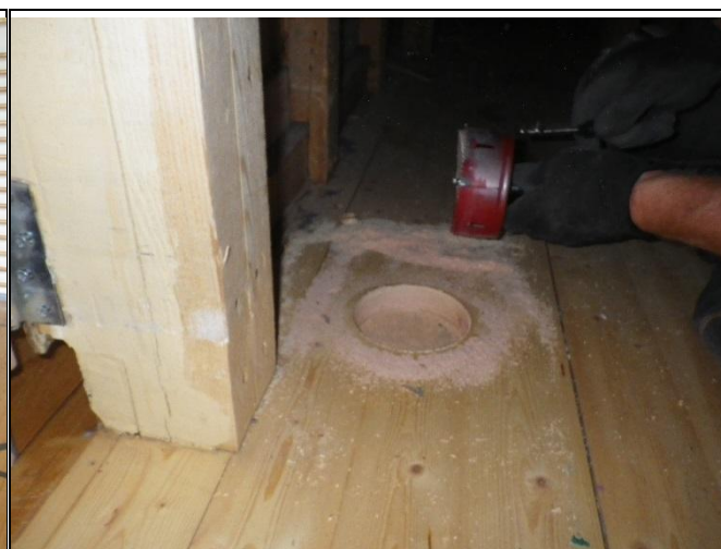
Kuva 16.2 rakenneavaus tehtiin näyttämön alatiilaan
