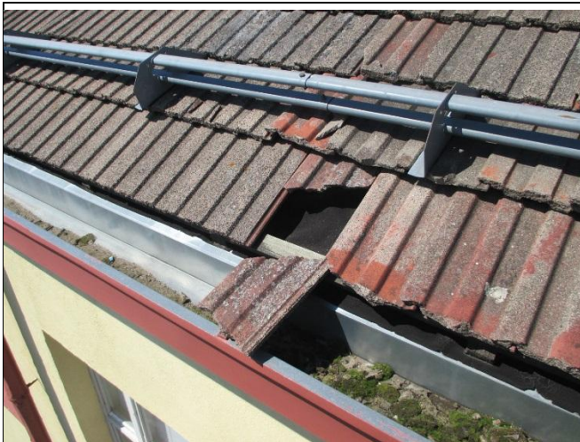
Kuva 22.1 Rikkoontuneet tiilet aiheuttavat niiden putoamisvaaran
