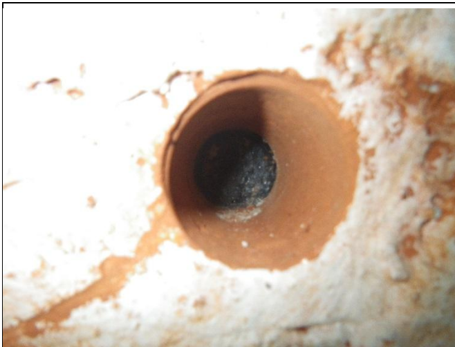
Kuva 7.1 Maanvastaisen ulkoseinän bitumisively on betonin lämpimällä puolella.
