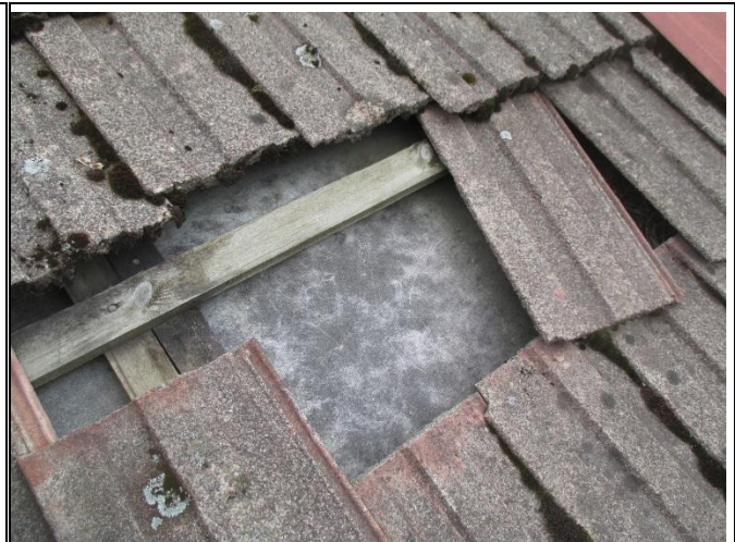
Kuva 23.2 Irronneita tiiliä
