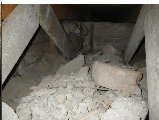
Kuva 16.4 Välitilaan on jätetty vanhaa rakennusjätettä.
