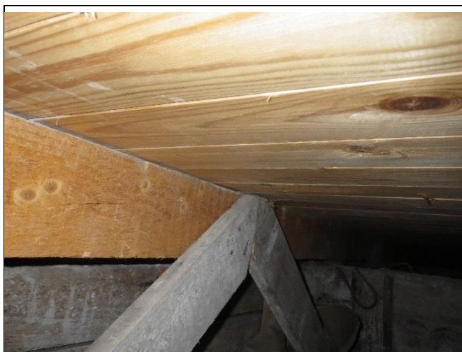
Kuva 16.3 Välitilassa on vanhat muottilaudat.
