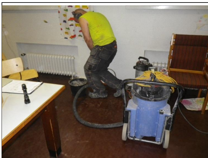
Kuva 8.2 Maanvastaiseen alapohjaan tehtiin rakennevaus rakennetyypin selvittämiseksi.
