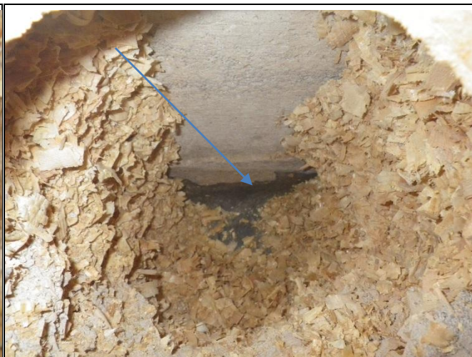
Kuva 15.2 Eristekerroksen alla on tervapaperi
