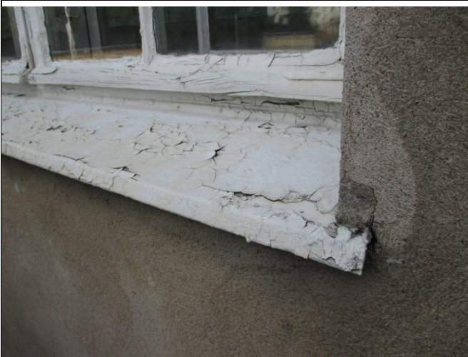
Kuva 19.1 Maalipinta hilseilee.
