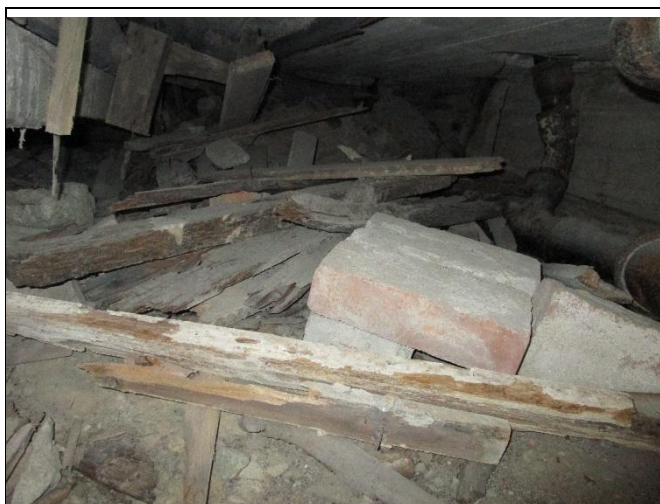
Kuva 8.1 Ryömintätilassa muottilautoja.
