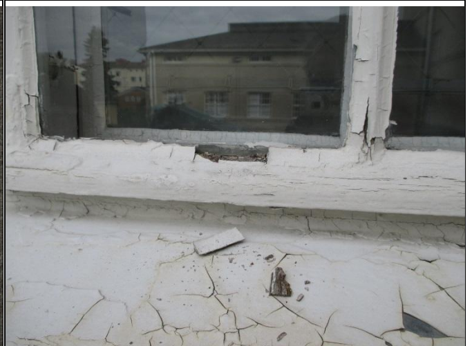
Kuva 19.2 Ikkunakittaukset lohkeilee.
