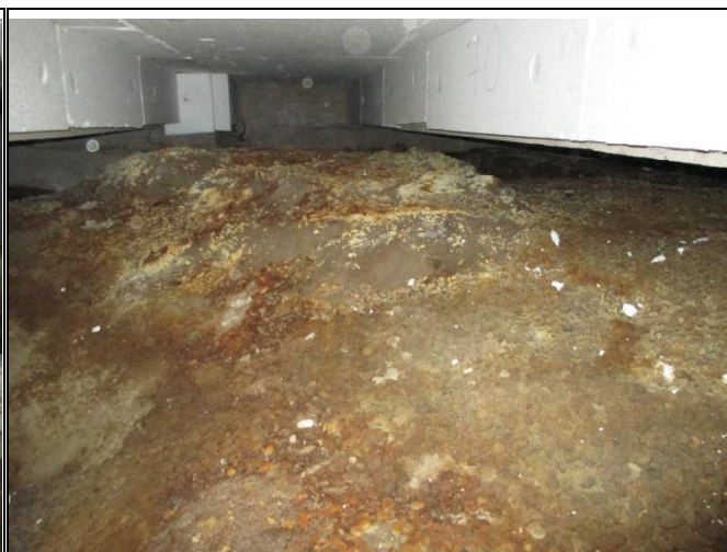
Kuva 8.2 Ryömintätilassa mikrobikasvustoa.
