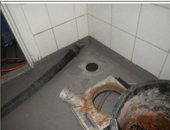
Kuva 14.3 Rakenneavaus.
