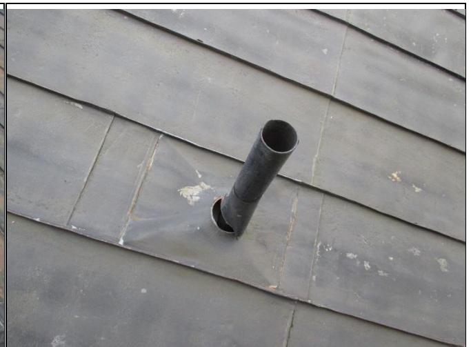
Kuva 18.2 Läpivienti epätiivis.
