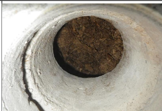
VP1, rakenneavaus RA.02, 4 krs
