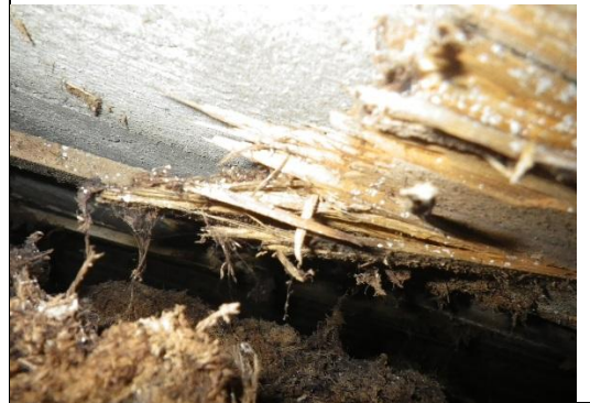
VP1, rakenneavaus RA.06, 5 krs
