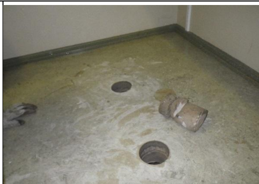
VP1, rakenneavaus RA.05, 5 krs
