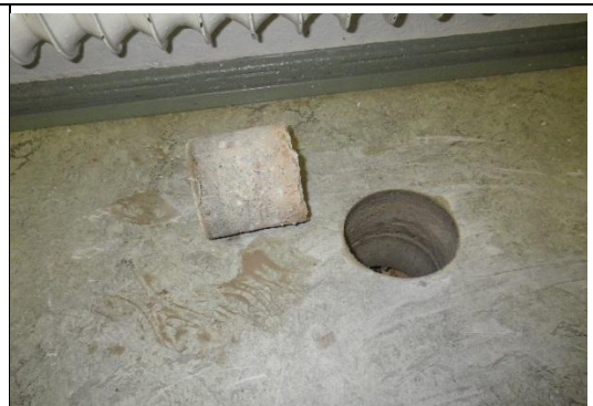
VP1, rakenneavaus RA.08, 5 krs
