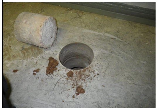
VP1, rakenneavaus RA.07, 5 krs
