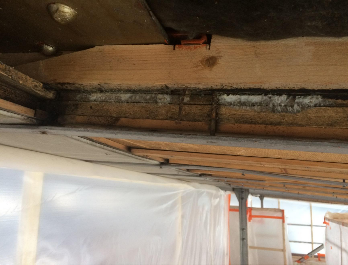
Kuva 1, Kattolevyjen kiinnitys. Hometta insuliittilevyissä ja ruostuneet puuruuvit
