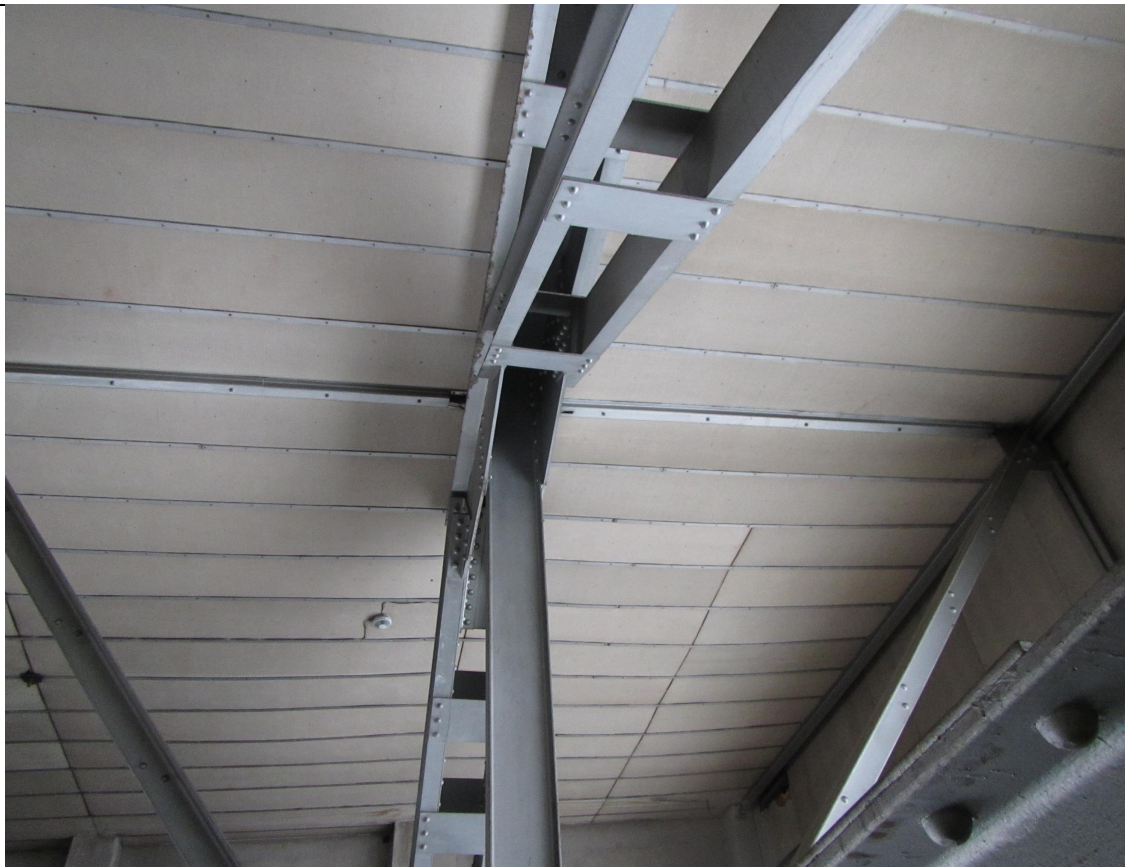
Kuva 1, Kattolevyjen kiinnitys. Hometta insuliittilevyissä ja ruostuneet puuruuvit
