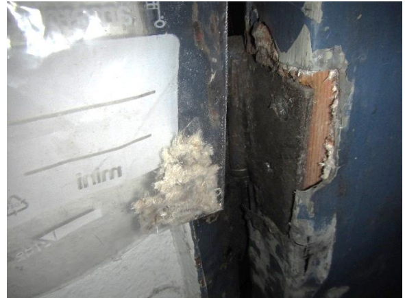
Kuva 37. Lentokonehallin ja tilan 324 välinen vanha metalliovi sisältää asbestia.
