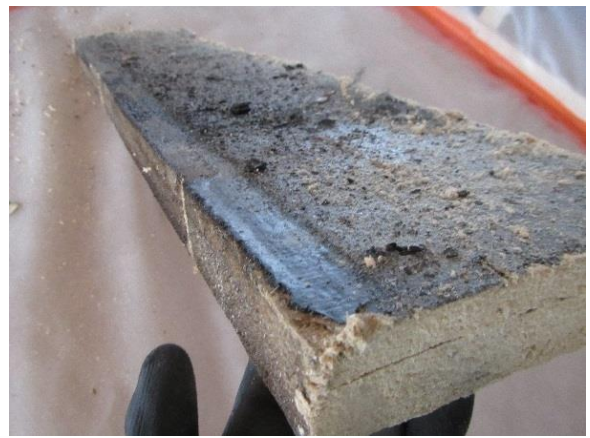
Kuva 12. Yläpohjan puukuitulevyjen yläpinnassa asbestipitoinen bitumisively
