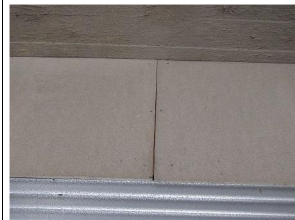
Kuva 35. Katoksen levyt ovat lännen puolella paksumpia ja kiinnitetty nauloilla.
