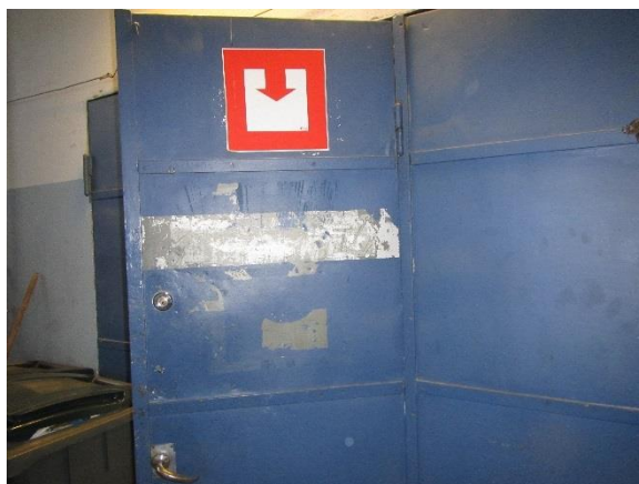
Kuva 38. Lentokonehallin ja tilan 328 välinen vanha metalliovi sisältää mahdollisesti asbestia.
