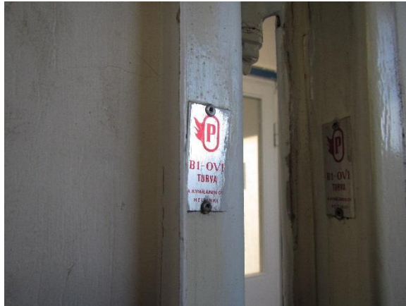
Kuva 36. Vanha B1-luokan metallipalo-ovi karmeineen sisältää asbestia.
