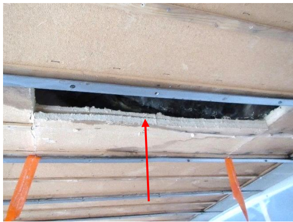
Kuva 11. Lentokonehallin yläpohjaa avattuna, 2-kertainen puukuitulevytyks näkyvissä, avaus 1.
