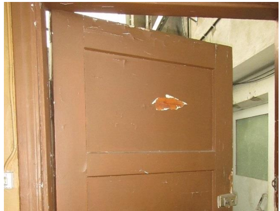
Kuva 48. Toimistotornin 2. kerrokset ovi- ja karmi- maalit sisältävät sinkkiä ja lyijyä yli vaarallisen jätteen raja-arvon.
