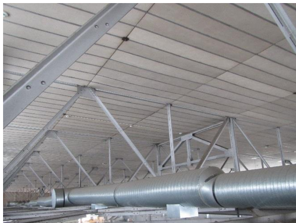
Kuva 17. Lentokonehallin kattoverhouslevyt sisältävät asbestia, näyte 47)
