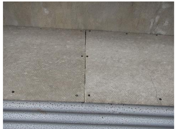
Kuva 34. Katoksen levyt ovat idän puolella ohuita ja kiinnitetty ruuveilla.
