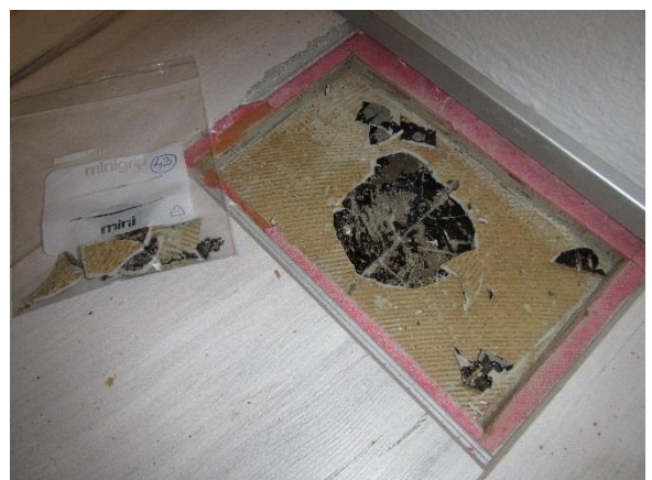
Kuva 32. Uudempien kahden lattiapinnoitteen alla havaittiin lattialaatta, joka on kiinnitetty mustalla liimalla. Sekä laatta että liima sisältävät asbestia.
