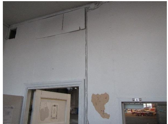
Kuva 46. Tilan 304 seinämaali sisältää sinkkiä yli vaarallisen jätteen raja-arvon.
