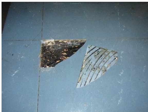
Kuva 26. Tilan 340 siniharmaa lattialaatta ja musta liima sisältävät asbestia.
