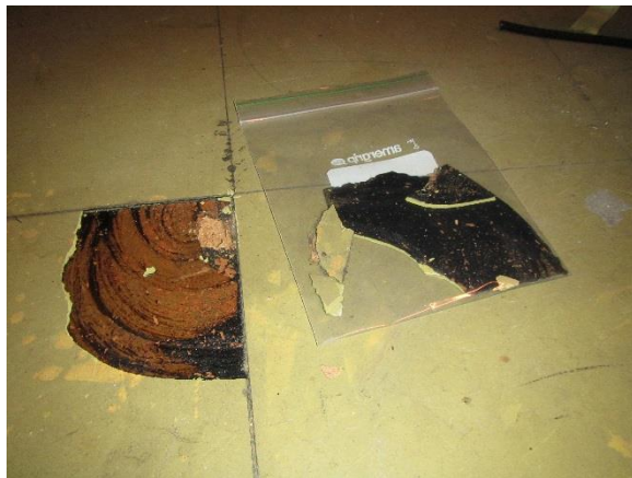
Kuva 19. Tilan 349 lattialaatta ja musta liima sisältävät asbestia.
