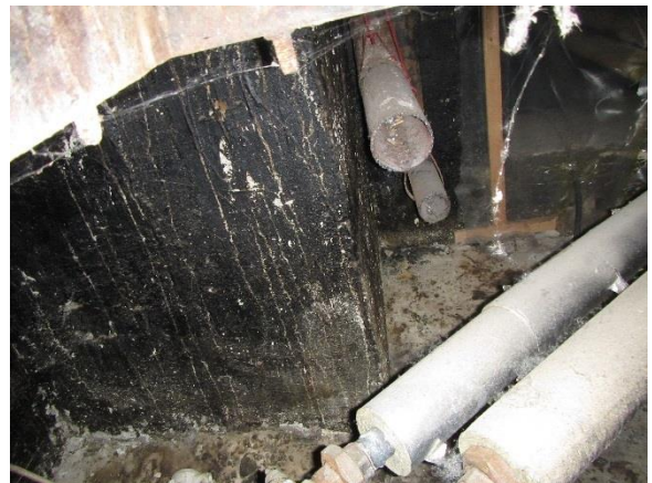
Kuva 14. Putkikanaalin seinämissä pikisively, kuvattuna lentokonehallin lattialuukusta portaikon oven kohdalta.
