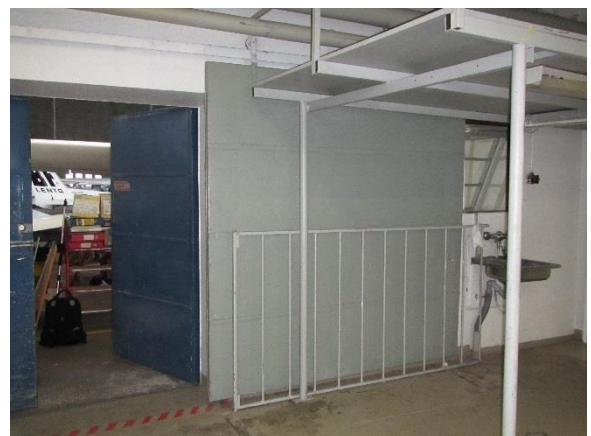
Kuva 39. Korjaamo-osan liukupalo-ovi sisältää mahdollisesti asbestia.
