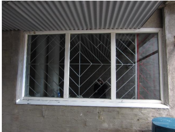
Kuva 62. Autotallin ikkuna välikatoksen alla on lämpölasikkuna, jonka tiivistysmassat mahdollisesti sisältävät PCB:tä.
