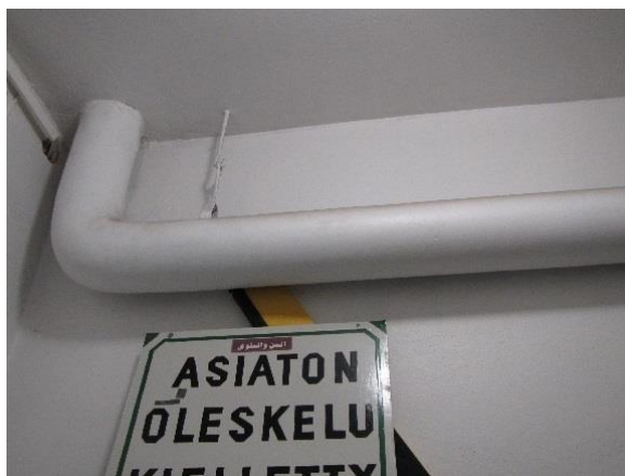
Kuva 8. Toimistosiiven 1. kerroksen eteisen 331 putkieriste sisältää asbestia.
