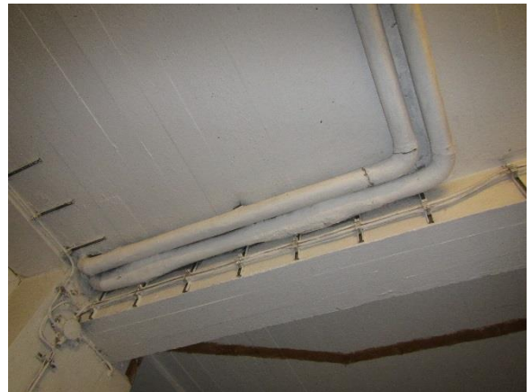
Kuva 7. Varaston 354 putkieristeet sisältävät asbestia.
