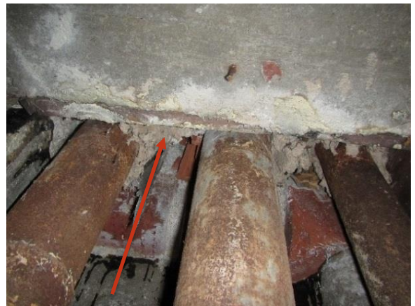
Kuva 10. Läpivienneissä on jäljellä asbestipitoisia putkieristeitä.
