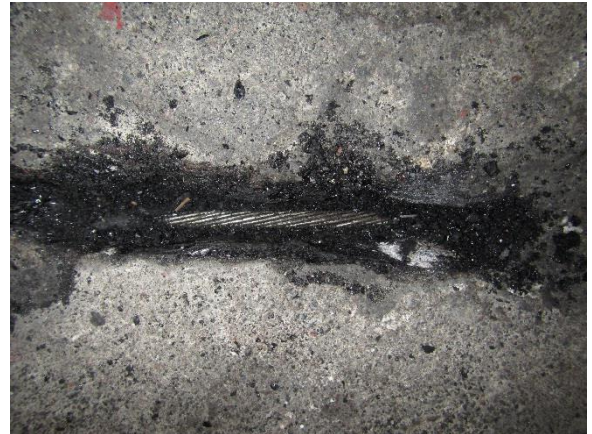
Kuva 42. Hallin alapohjan saumamassassa havaittiin teräsvaijeri.
