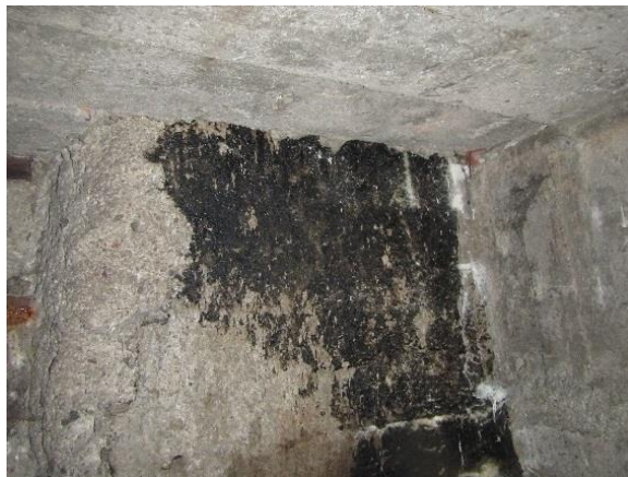
Kuva 13. Putkikanaalin seinän pikisively sisältää asbestia.
