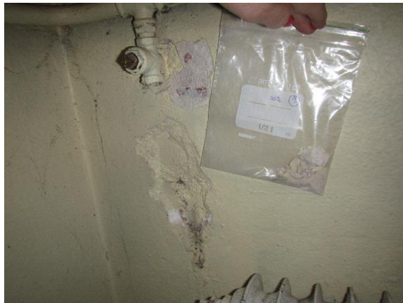
Kuva 45. Tilan 302 keltainen seinämaali sisältää sinkkiä yli vaarallisen jätteen raja-arvon.
