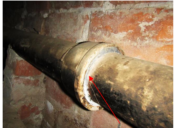
Kuva 63. Putkikanaalin valurautaputken muhvilii- toksessa on lyijyä.
