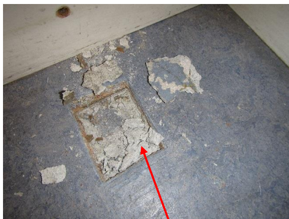
Kuva 28. Tilan 350 lattiapinnoitteiden alainen taasoitekerros sisältää asbestia.
