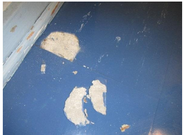
Kuva 25. Tilan 339 sininen lattialaatta sisältää asbestia.
