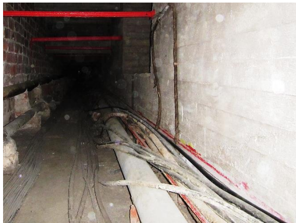
Kuva 64. Putkikanaalissa havaittiin vanhoja sähkö- johtoja, joiden eristeet mahdollisesti sisältävät PAH-yhdisteitä.
