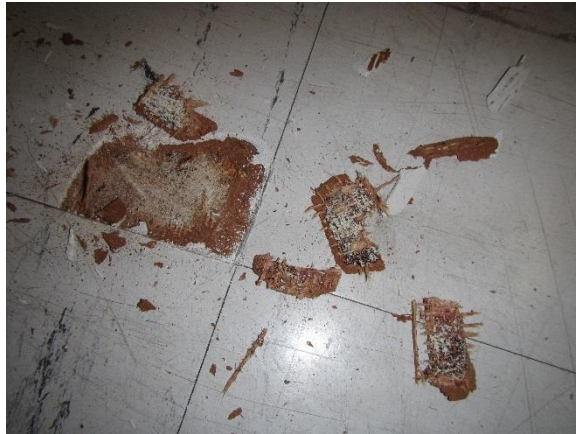
Kuva 24. Tilan 335 lattiapinnoitteet ja liimat sisältävät asbestia.
