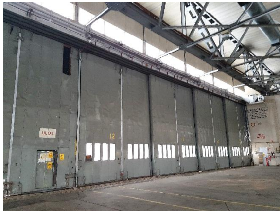
Kuva 43. Lentokonehallin liukuovia
