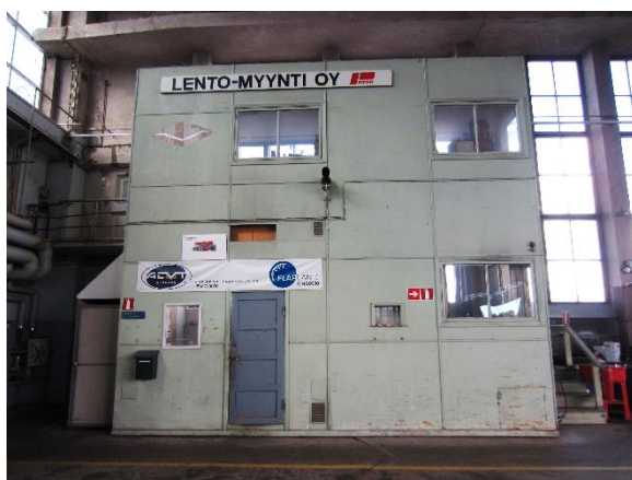
Kuva 49. Toimistotornin ulkopuolen seinien vihreä maali sisältää sinkkiä yli vaarallisen jätteen raja- arvon.
