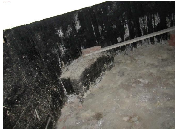
Kuva 16. Portaikon aluskomeron alaisen tyhjän tilan seinämissä havaittiin bitumisively, joka sisältää mahdollisesti asbestia.
