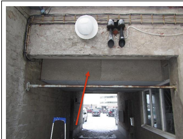
Kuva 33. Toimistosiiven ja hallirakennuksen välisen katoksen pystylevytykset sisältävät asbestia.
