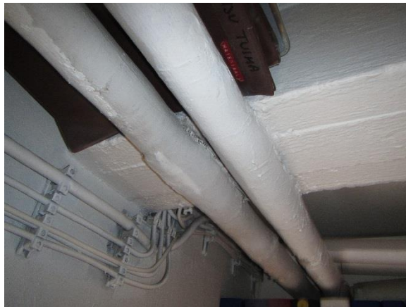
Kuva 6. Toimiston 354a putkieristeet sisältävät asbestia.
