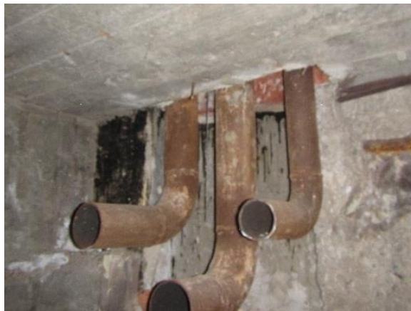
Kuva 9. Putkikanaalin katossa havaittiin vanhojen, katkaistujen putkien läpivientejä.
