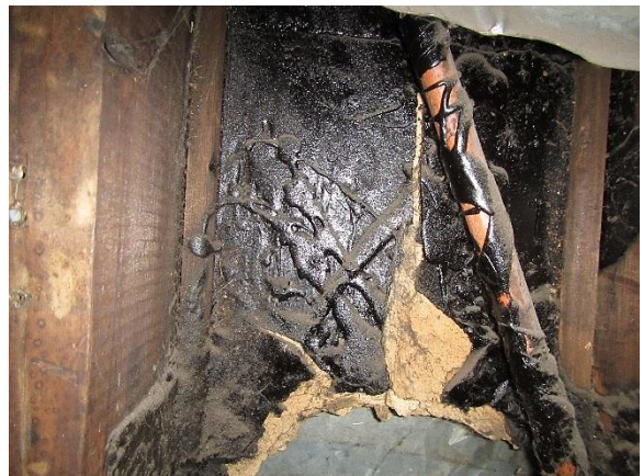
Kuva 44. Liukuoven sisällä olevan puukuitulevyn sisäpinnan bitumisivelyn PAH-yhdisteiden kokonaispitoisuus ylittää purkutöissä henkilösuojautumista edellyttävän ohjearvon.
