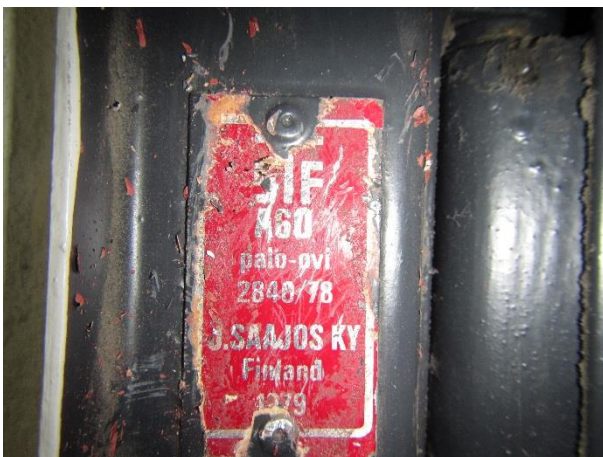
Kuva 4. Vanhat palo-ovet ovat J. Saajos Ky:n valmistamia vuoden 1979 palo-ovia. Nämä voivat sisältää asbestia ja tulisi siksi käsitellä asbestipitoisena materiaalina.
