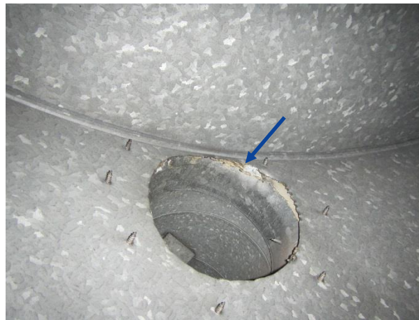
Kuva 2. IV-kanavan saumamassa (WML 20) sisältää asbestia (antofylliitti).
