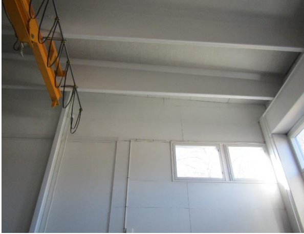
Kuva 3. Vahasen raportin (helmikuu, 2017) mukaan vanhan rakennusosan sisäverhouslevyt ja tuulensuojalevyt sisältävät asbestia.
