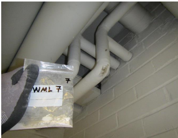
Kuva 1. Putkieristeen mutka (WML 7) sisältää asbestia (antofylliitti/amosiitti).
