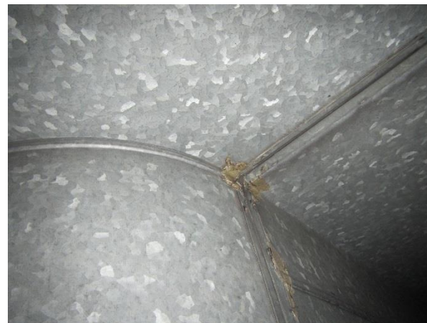
Kuva 12. IV-kanavan saumamassa (WML 20) sisältää haitallisen määrän nikkeliä.
