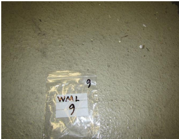
Kuva 9. Vihertävän harmaa lattiamaali (WML 9) sisältää haitallisen määrän sinkkiä.
