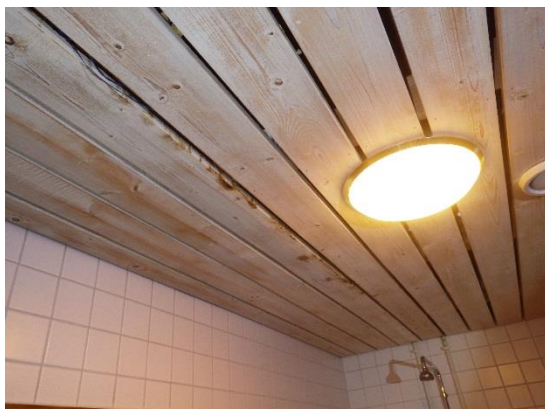
Kuva 12 a ja b: Uuden osan kylpyhuoneen katon paneloinnissa (kuva a) sekä siivouskomerossa olevan teräspilarin liitoksessa välipohjaan (kuva b) havaittiin kosteusjälkiä.
