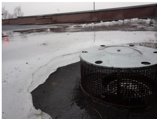
Kuva 15 a ja b: Vanhan osan vesikatolla havaittiin yhdellä sivustalla paksu jääkerros.
