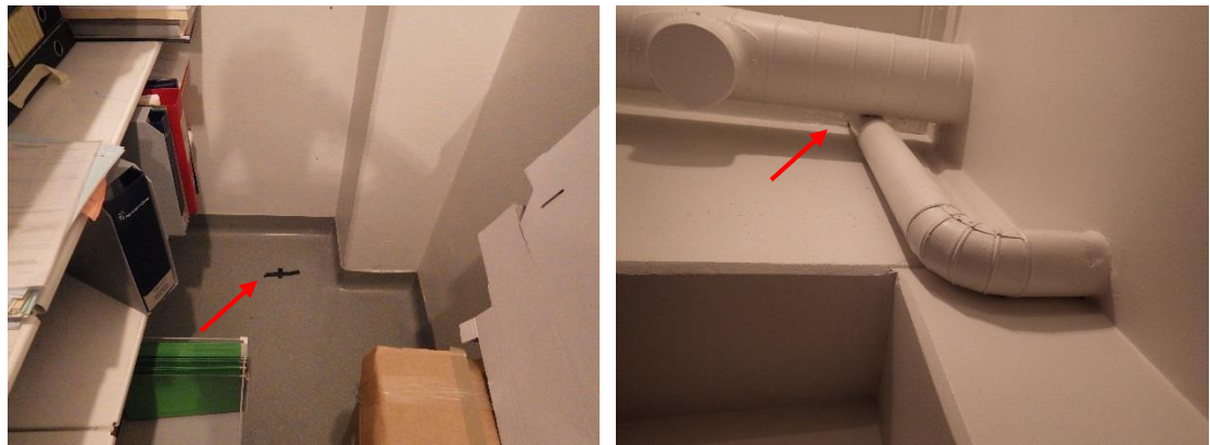
Kuva 14 a ja b: Viiltomittauskohta arkistohuoneessa (kuva a). Mittauksesta saatiin korkea suhteellisen kosteuden lukema. Kyseisen kohdan päällä oli kattokaivon läpivienti (kuva b), joka on todennäköisesti vuotanut. Myös viereisessä pilarissa havaittiin kosteusvalumajälkiä sekä seinän tasoitteessa havaittiin kosteusperäisiä vaurioita.
