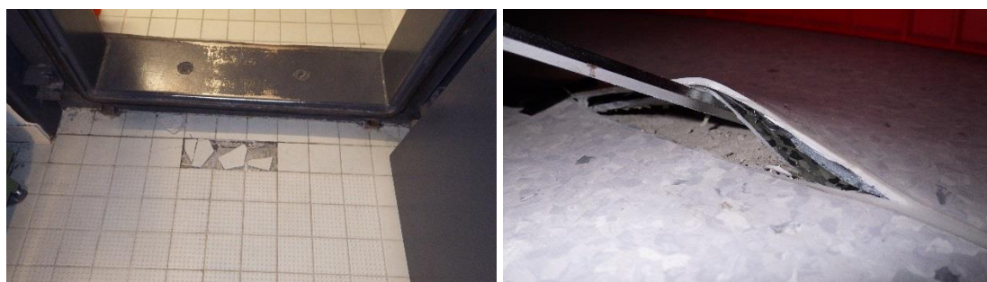
Kuva 2 a ja b: a) Irtonaisia laattoja uuden osan väestönsuojan edustalla. b) Sähkötyötilassa 151 havaittiin olevan kaksi muovimattopinnoitetta päällekkäin.
