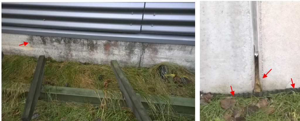
Kuva 8 a ja b: a) Sokkelissa havaittiin kosteusjälkiä. b) Sokkelielementtien saumat olivat paikoin vajaita. Perusmuurilevyn yläreuna oli suojaamatta. Rakennuksessa havaittiin patolevy vanhalla rakennusosalla, uudella osalla sitä ei ollut.
