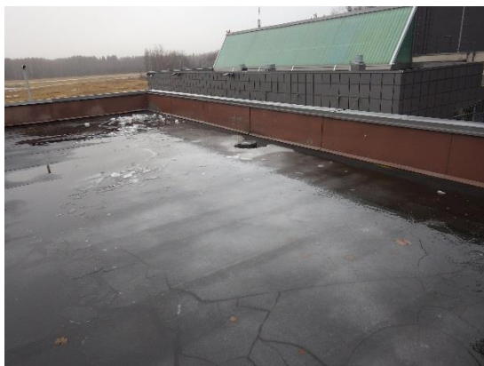
Kuva 15 a ja b: Vanhan osan vesikatolla havaittiin yhdellä sivustalla paksu jääkerros.
