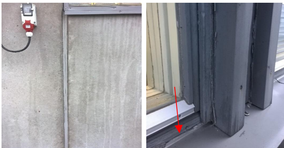
Kuva 9 a ja b: a) Betonielementin sauma oli haljennut. b) Vanhan osan ikkunoiden ulkopuutteet olivat ikääntyneitä ja huonokuntoisia, niiden maalipinta hilseili ja puisissa alalistoissa oli paikallisia vaurioita (vauriokohta on osoitettu nuolella).
