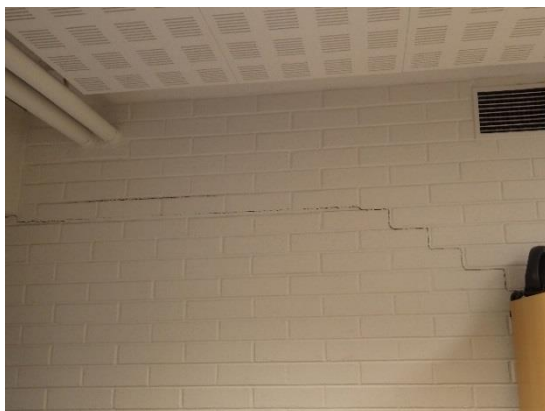
Kuva 11: Vanhan osan 1. kerroksen huoneessa 162 (kuva a) sekä 2. kerroksen huoneessa 254 (kuva b) havaittiin halkeama tiiliseinässä.
