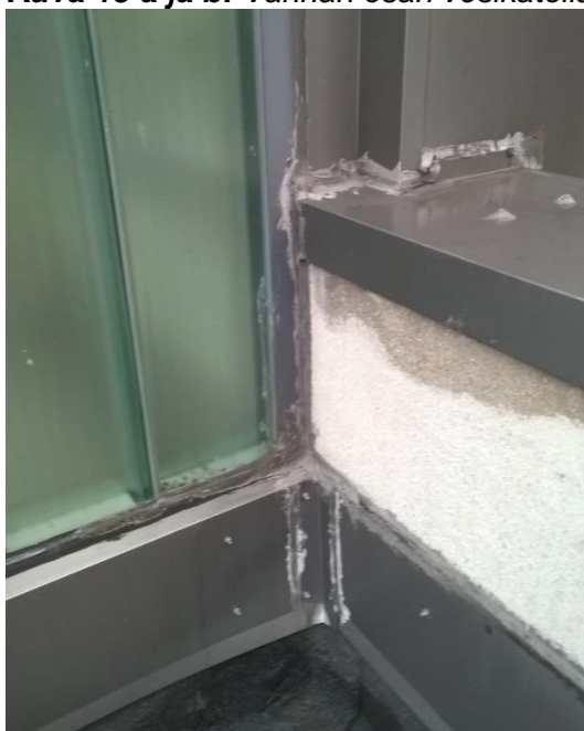
Kuva 16 a ja b: Uuden osan vesikatolla räystäs- ja ikkunapellitysten liitoksia oli tiivistetty joustavalla saumamassalla, silikonilla sekä erilaisilla teipeillä.
