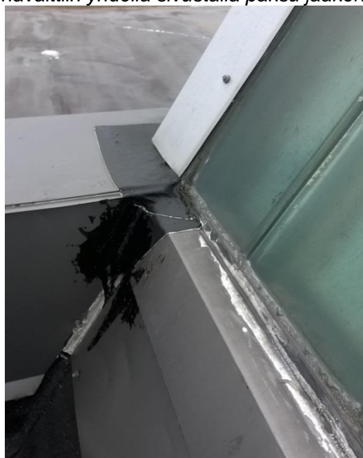
Kuva 16 a ja b: Uuden osan vesikatolla räystäs- ja ikkunapellitysten liitoksia oli tiivistetty joustavalla saumamassalla, silikonilla sekä erilaisilla teipeillä.
