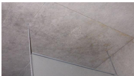
Kuva 19 a ja b: Uuden osan IV-konehuoneen katossa havaittiin vuotojälkiä.
