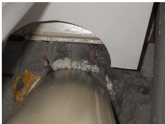
Kuva 12 a ja b: Uuden osan kylpyhuoneen katon paneloinnissa (kuva a) sekä siivouskomerossa olevan teräspilarin liitoksessa välipohjaan (kuva b) havaittiin kosteusjälkiä.
