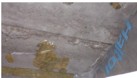
Kuva 19 a ja b: Uuden osan IV-konehuoneen katossa havaittiin vuotojälkiä.
