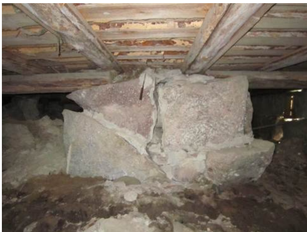
Kuvat 13 ja 14. Ryömintätilainen alapohja on epätasainen. Siellä on orgaanista aineesta. Sokkelikivetyksen rakoilu on parantanut alapohjan tuulettuvuutta.
