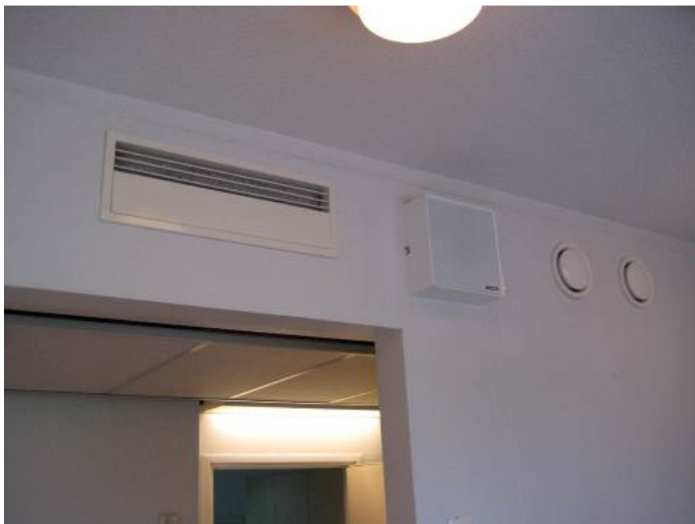
Kuva 37. Uuden osan tulo- ja poistoventtiileitä; ovat tyydyttävässä kunnossa.
