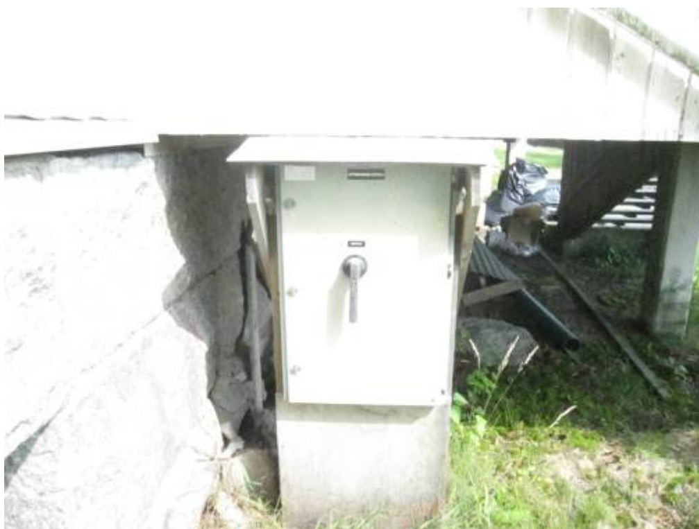
Kuva 58. Takapihalla oleva sähkökeskus ei ole suojattuna ilkivaltaa vastaan. Sähköt voidaan kääntää pois liian helposti.
