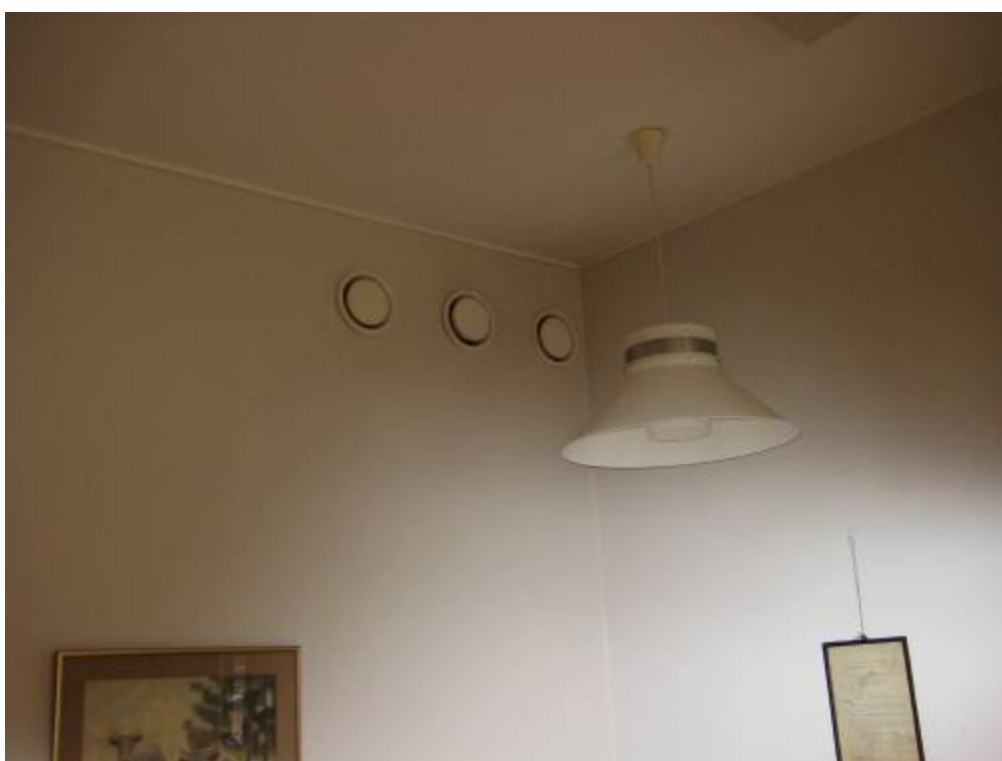
Kuva 32 . Ruokalan poistoilmaventtiileitä; ovat tyydyttävässä/ välttävässä kunnossa.
