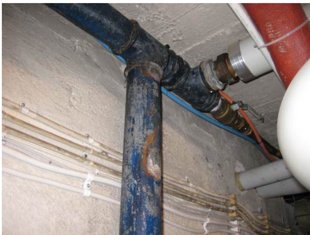
Kuva 24. Lämmönjakohuoneessa on vielä sinkittyä kylmävesiputkea; varauduttava uusimaa.
