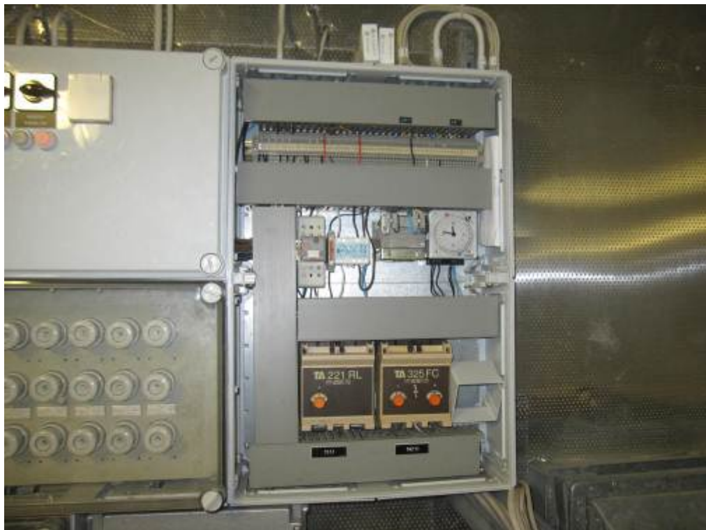
Kuva 48. IV- konehuoneiden vanhat automaatiolaitteet tulisi uusia.
