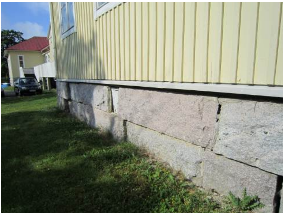
Kuva 8. Kivisokkeli on vaurioitunut.
