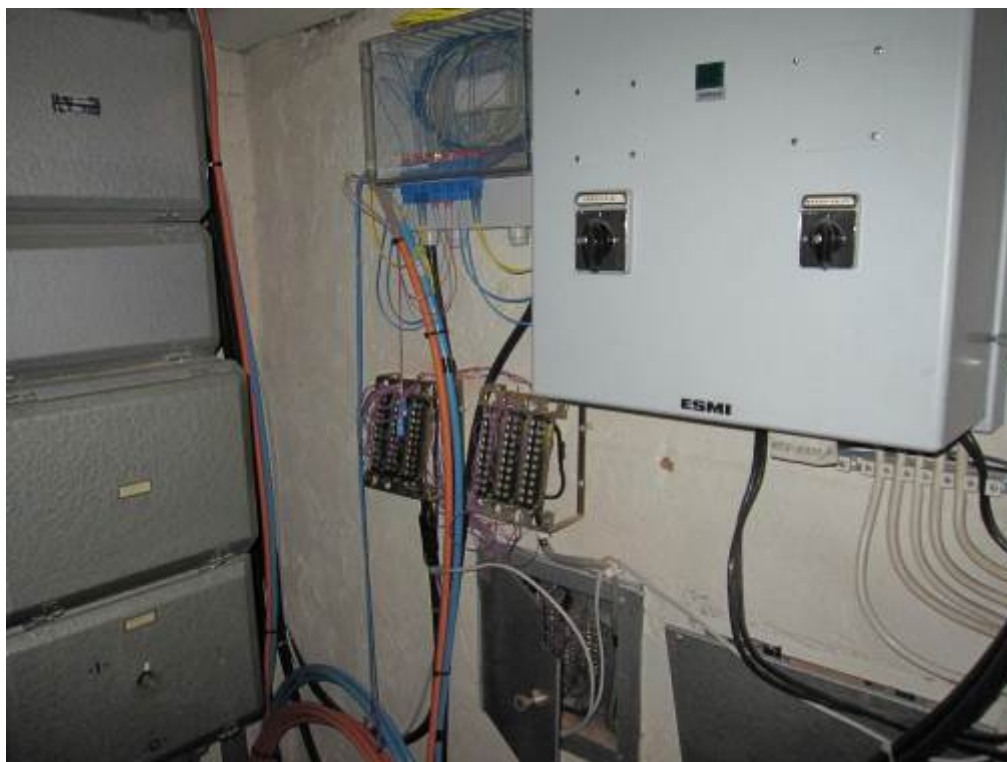
Kuva 56. Sähköasennukset on monin paikoin tehty epäsiististi.
