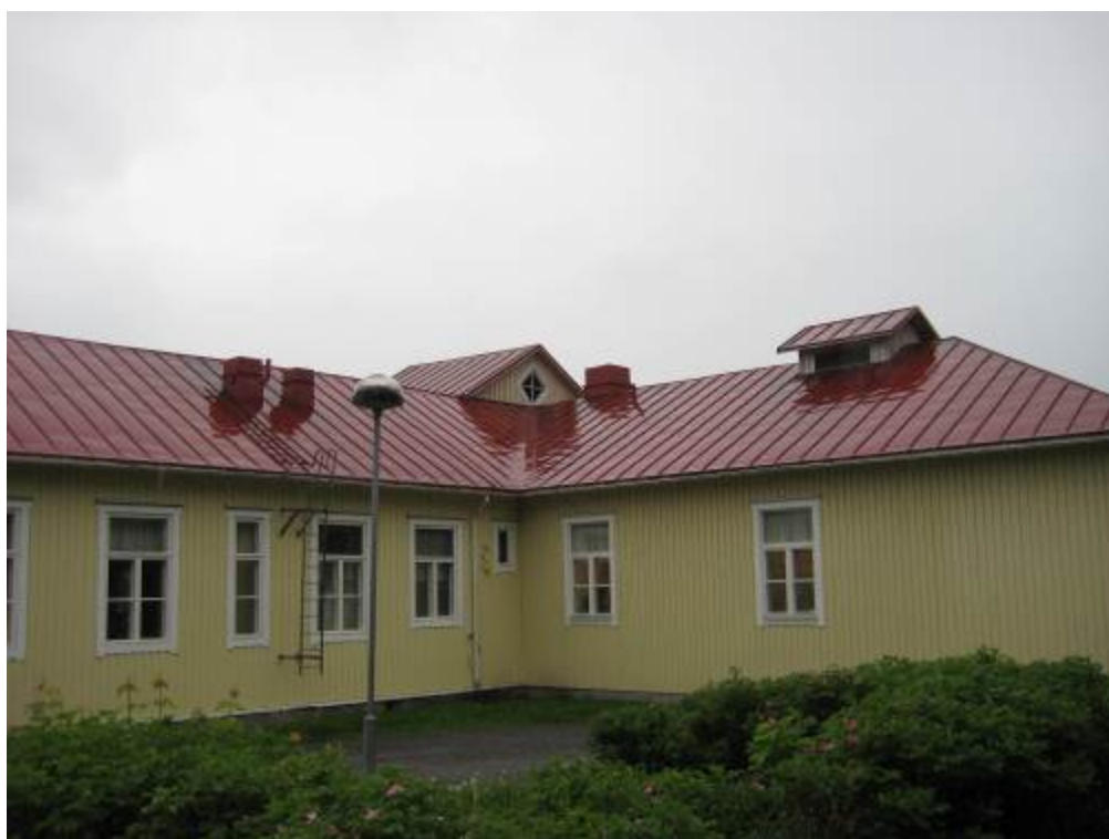
Kuva 30. Keittiön ja ruokalan tuloilmakoneen konehuone oikealla, poistoilman huippuimuri vasemmalla ja vanhan osan koneellisen poiston huippuimurit viereisellä lappeella.
