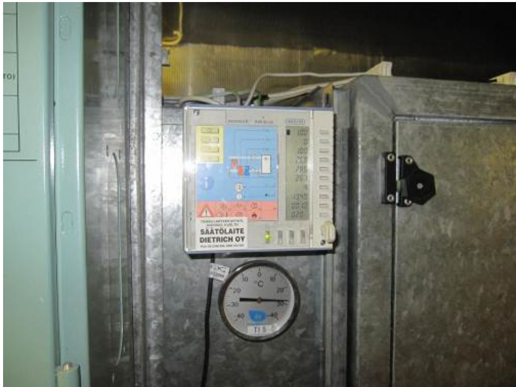
Kuva 49. Osa IV- koneiden säätölaitteita on uusittu n. 10v sitten. Landis&Gyr Aerogyr- säätölaitteita ei voi liittää keskusvalvomoon.
