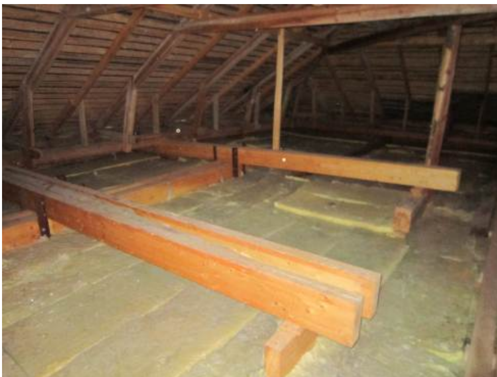
Kuva 16. Vanhan osan salin yläpohjaa on osin kannateltu riiputtaen.
