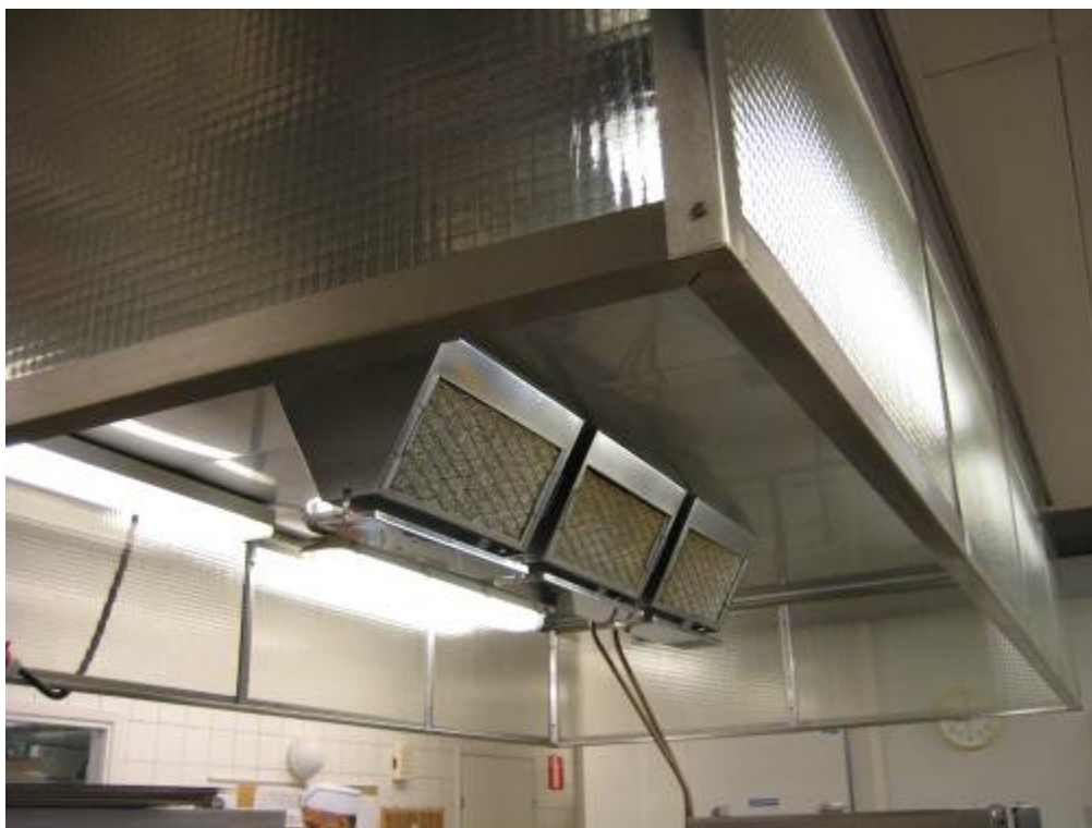
Kuva 33. Keittiön poistoilmahuuva ja rasvasuodattimet ovat tyydyttävässä kunnossa.
