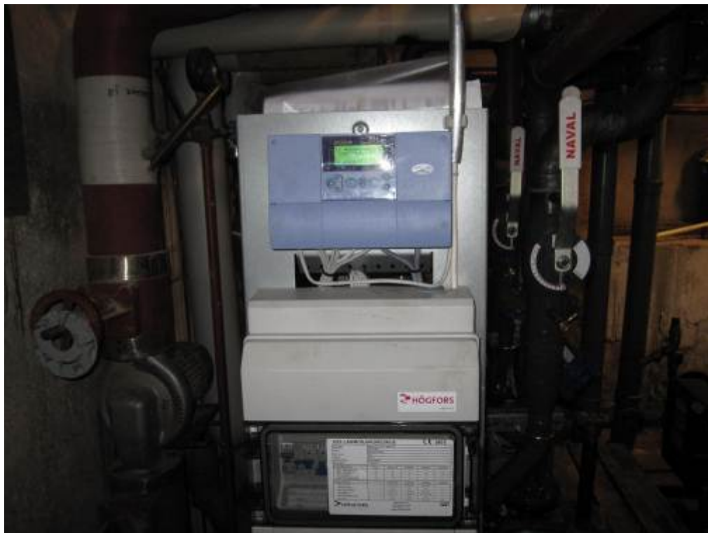
Kuva 50. Lämmönjakohuoneeseen uusittu Ouman EH203- säädin.
