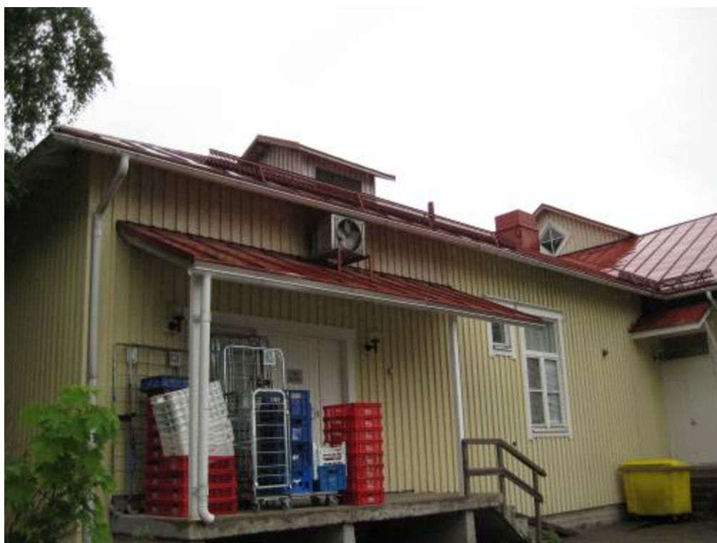
Kuva 38. Keittiön kylmiön jäähdytyslaitteen lauhdutin sadelipan yläpuolella.
