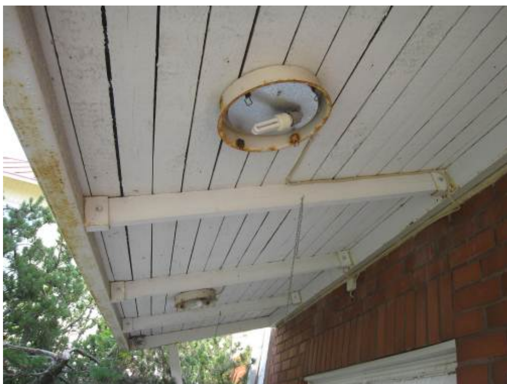
Kuva 52. Useita ulkovalaisimien kupuja puuttuu.
