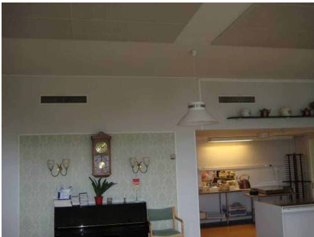
Kuva 31. Ruokalan tuloilmaventtiileitä; ovat tyydyttävässä/ välttävässä kunnossa.
