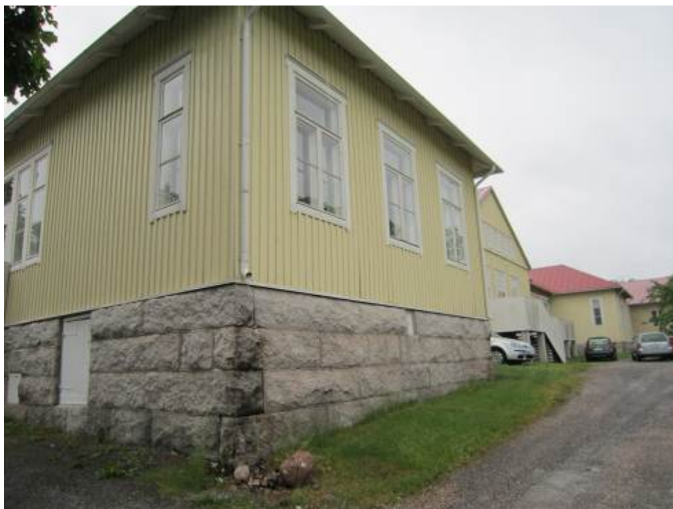
Kuva 3. Syöksytorvet ovat osalla rakennusta liian lyhyitä.
