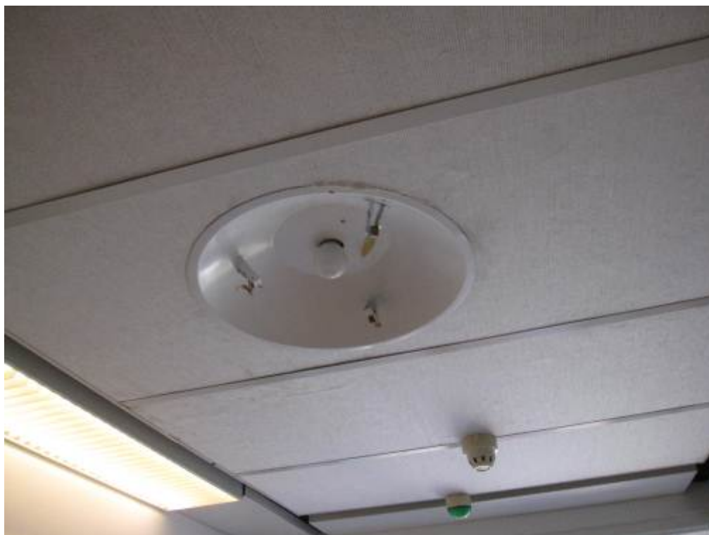
Kuva 57. Useita sisävalaisimien kupuja puuttuu.
