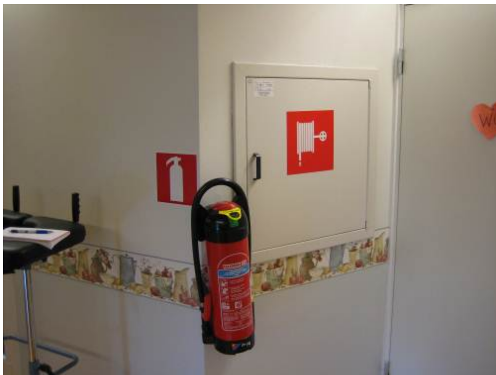
Kuva 39. Rakennuksessa on käsisammuttimia niin vanhalla kuin uudellakin osalla, jotka tarkastetaan kahden vuoden välein. Uudella osalla on myös vesiverkostoon kytettyjä pikapaloposteja, jotka tarkastetaan vuoden välein.
