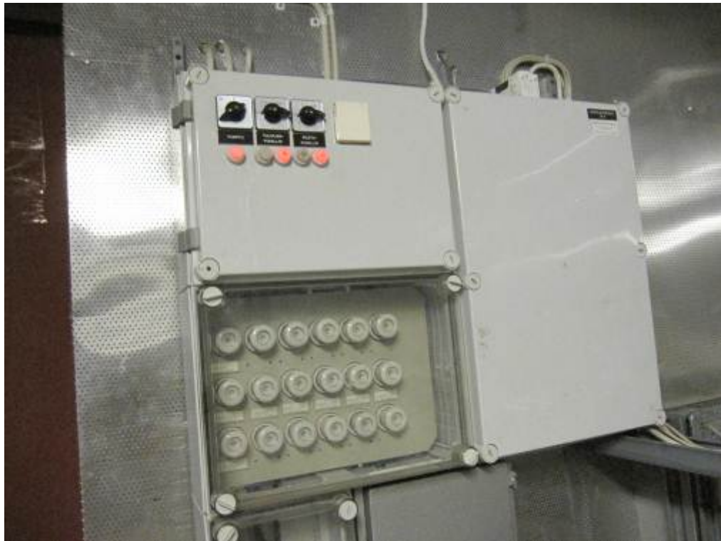
Kuva 47. IV- konehuoneen sähkökeskus.
