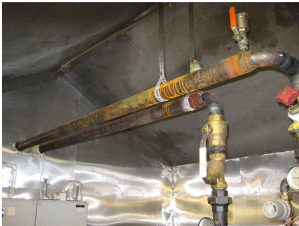
Kuva 23. Keittiön IV-koneen patteriputket ovat vailla maalia.
