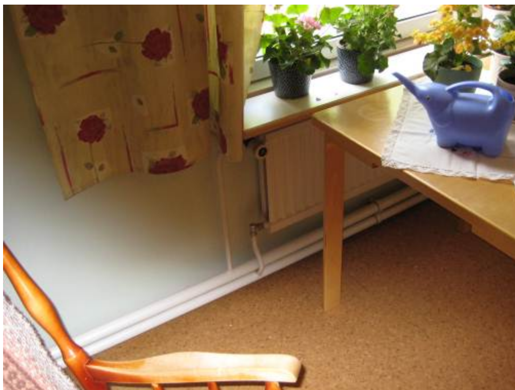
Kuva 22. Uuden osan lämpörunkoputket, termostaattinen patteriventtiili ja patteri tyypillisesti huoneessa.
