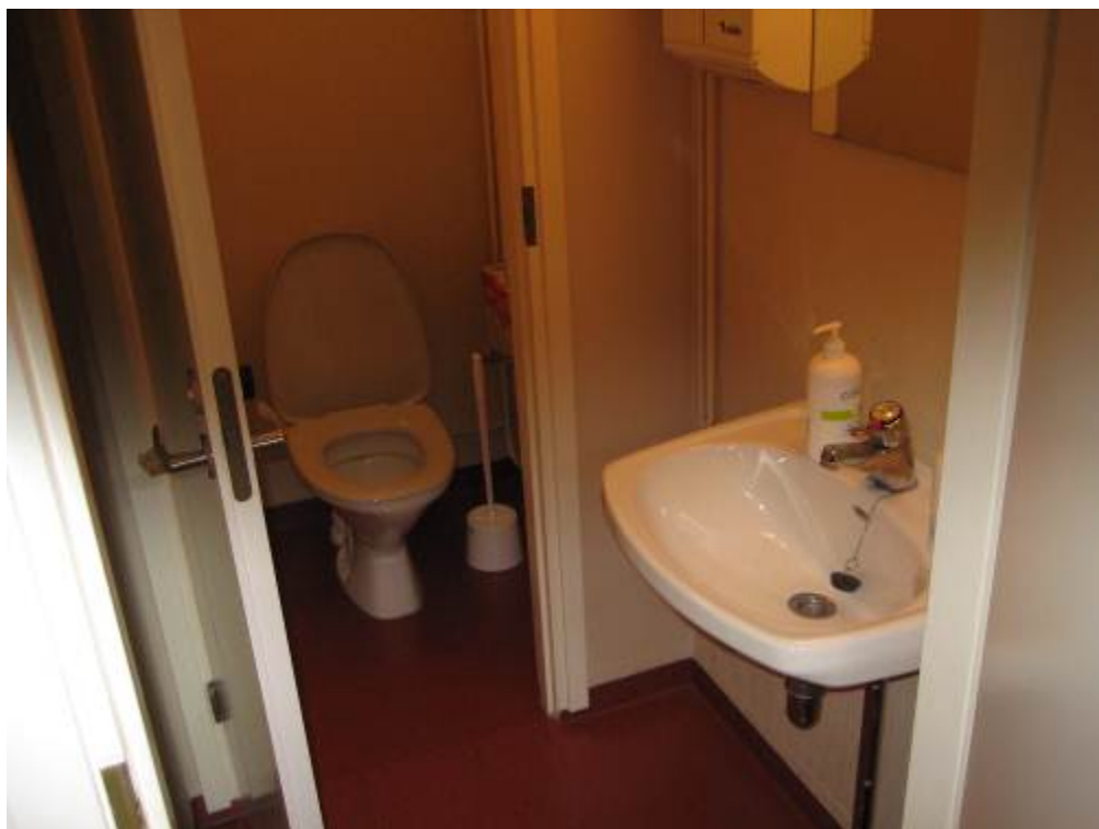
Kuva 27. Vanhan osan vesi- ja viemärikalusteita; ovat tyydyttävässä kunnossa.
