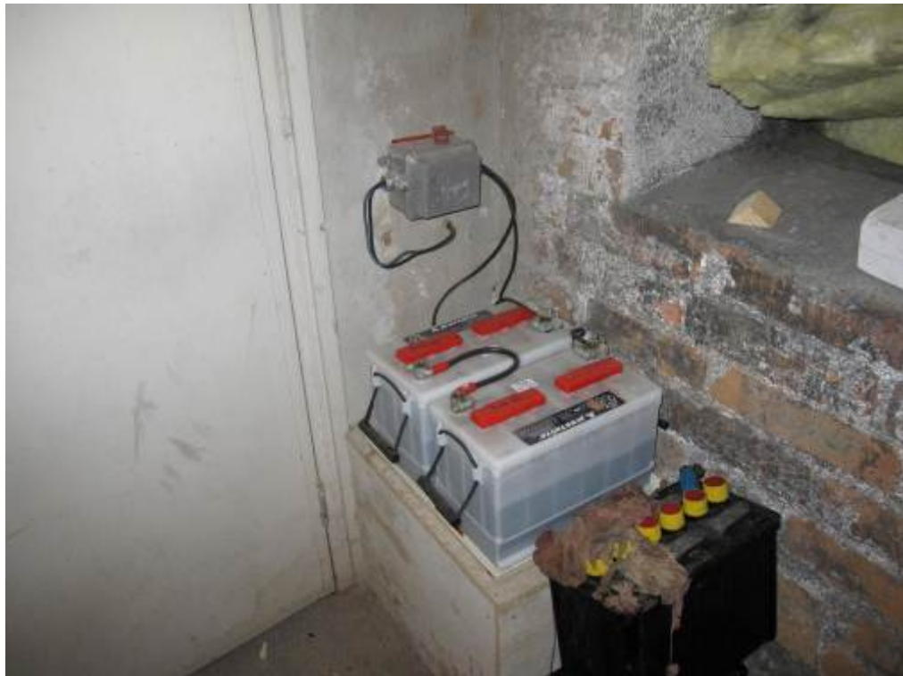
Kuva 45. Turvavalokeskuksen akuissa liian vähän nestettä.
