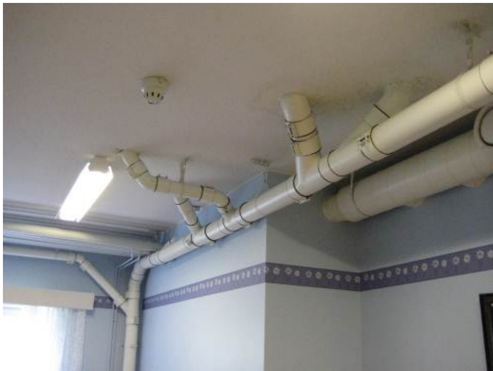
Kuva 26. Valurautaviemäreitä pantaliitoksilla; viemäreissä on ollut syöpymiä ja vuotoja. Korjauksia on helpottanut se, että asennukset ovat näkyvissä.
