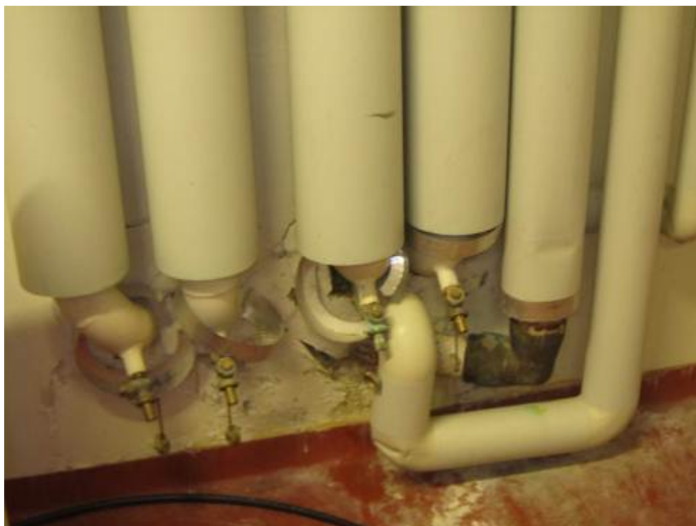
Kuva 18. Pesulan maanvastaisen seinän läpivienneistä tulee vettä sisätiloihin.
