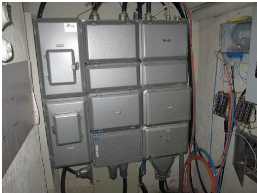
Kuva 42. Sähköpääkeskus. Sähköpääkeskuksen pääkytkin rikki.
