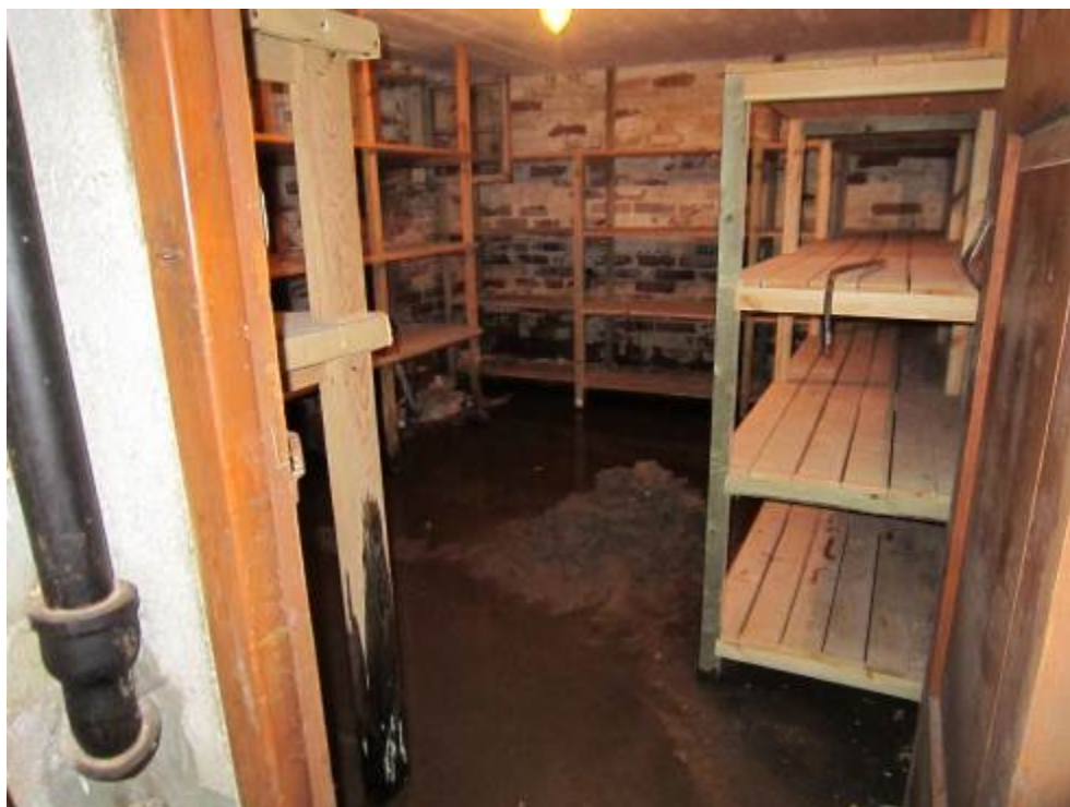
Kuva 11. Vanhan osan kellarissa oli lattialla vettä. Tilassa olevat hyllyt ovat vaurioituneet pahoin ja ne pitää hävittää.
