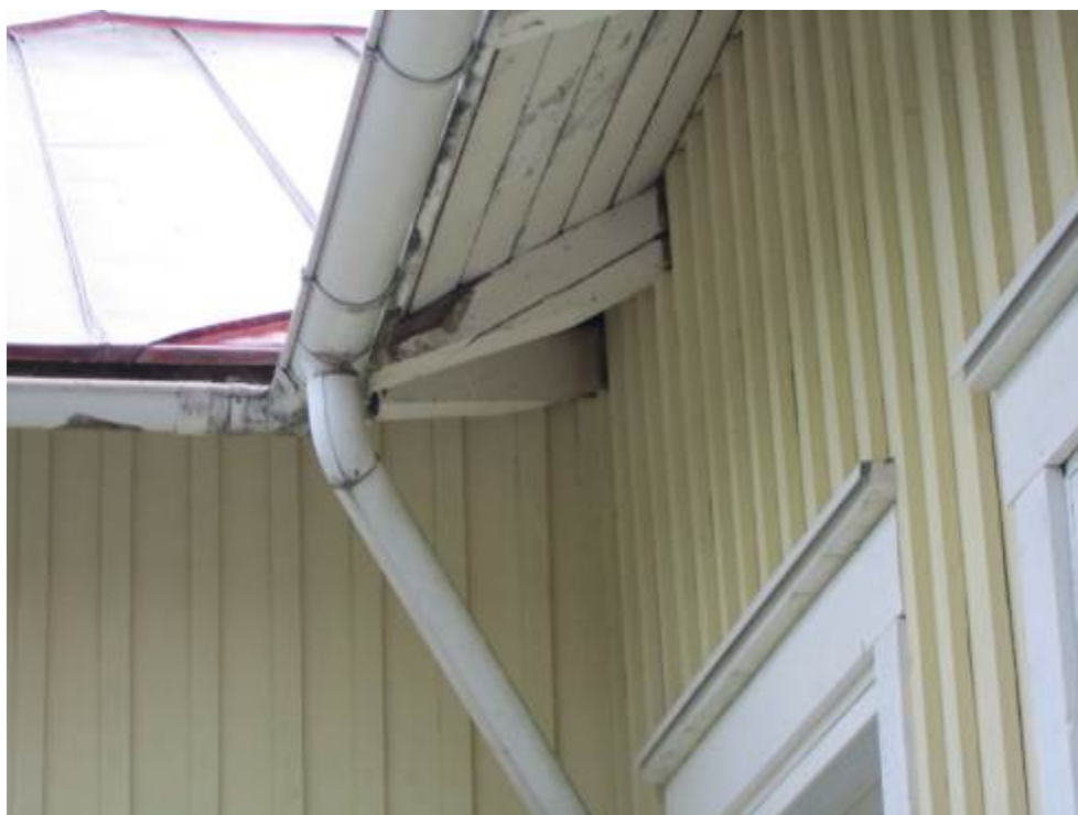
Kuva 4. Sisäjiiri on vaurioitunut vanhan vesikatteen aikana. Vesikourut ovat liian matalia ja voimakkaalla sateella vesi tulee kourusta yli.
