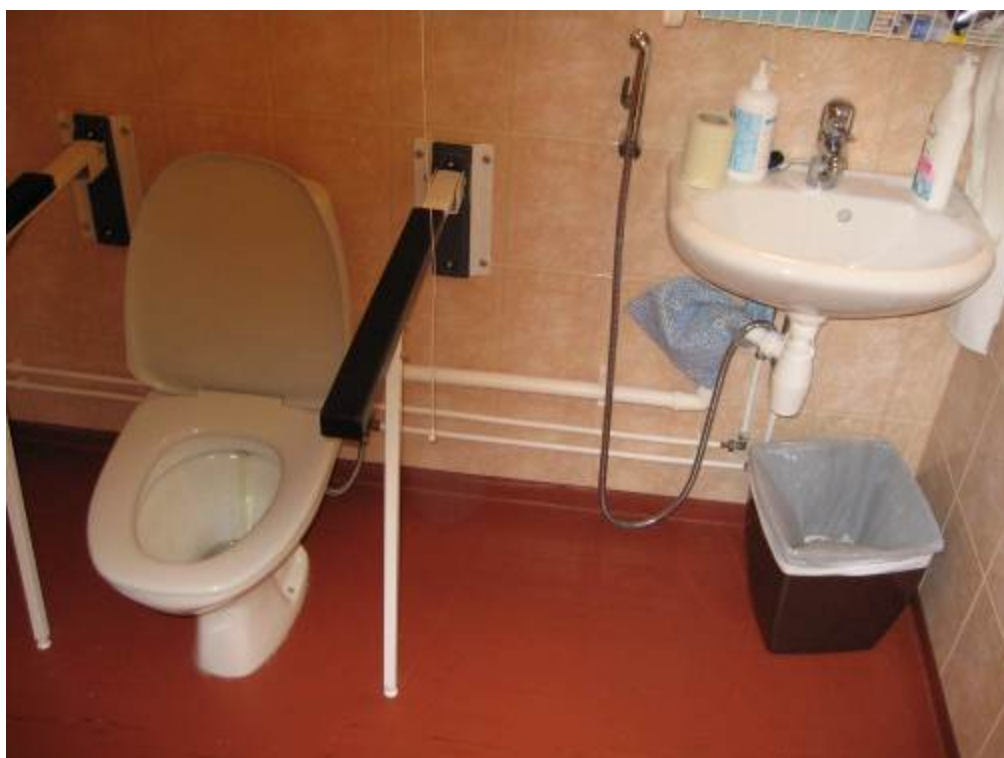
Kuva 28 Uuden osan vesi- ja viemärikalusteita; ovat tyydyttävässä kunnossa.
