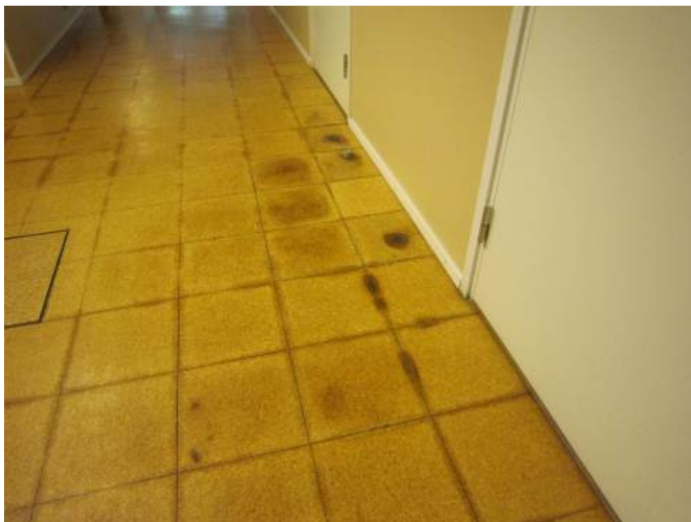
Kuva 17. Dementiaosaston käytävän lattiaa. Pesuvedet ovat tummentaneet korkkilaa- tan saumoja. Tummiin laikkujen kohdalla pintakosteudenosoitin osoitti kohonneita kosteuspitoisuuksia.
