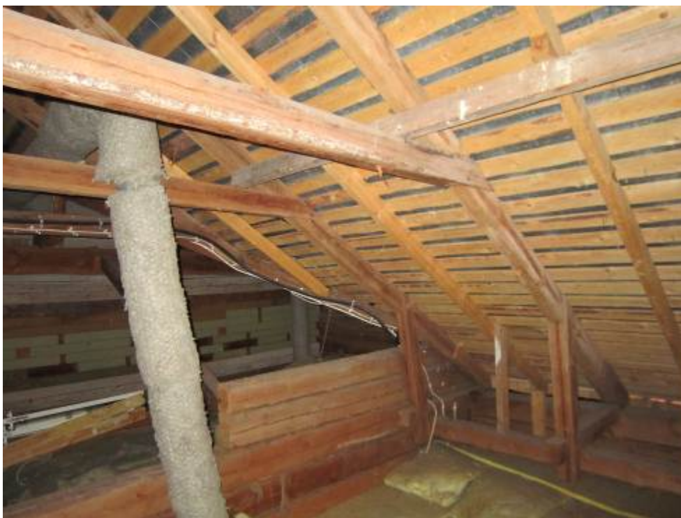
Kuva 15. Vesikattorakenteita. Vesikatossa ei ole aluskatetta. Ruoteet on pääosin uusittu peltikatteen asentamisen yhteydessä.
