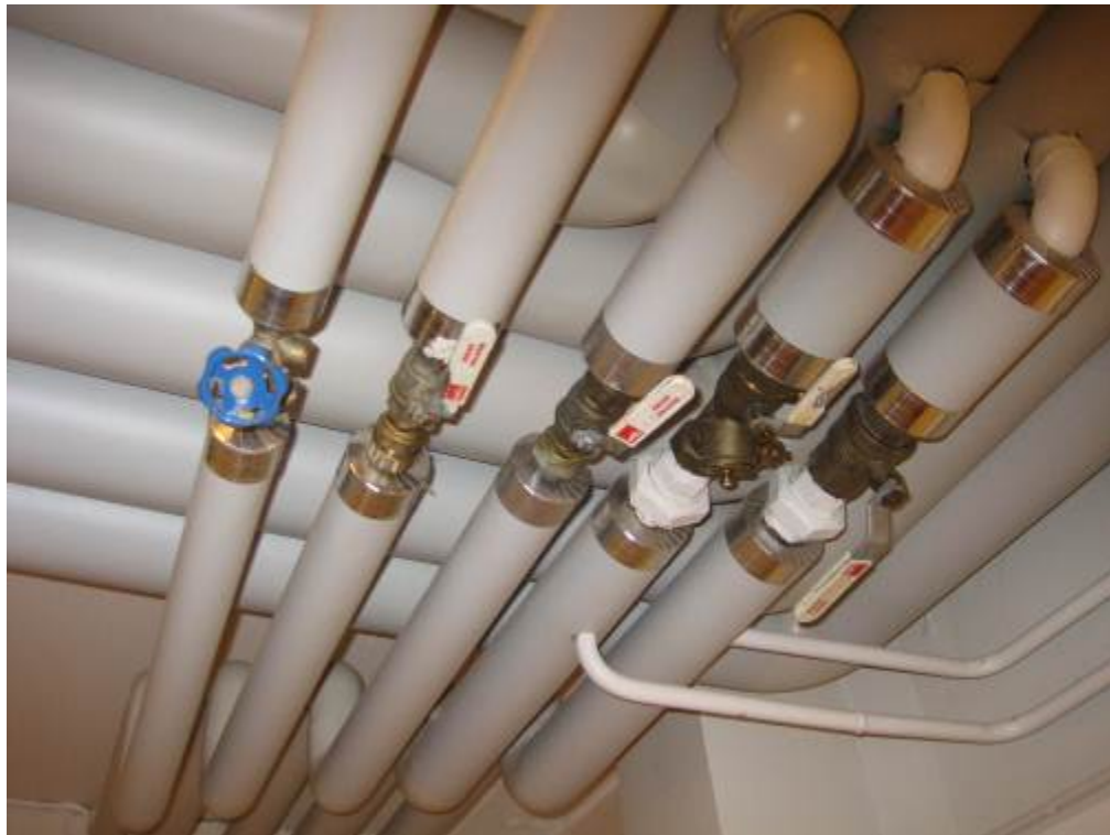
Kuva 25. Putkiasennuksia uuden osan päiväkeskuksessa; ovat tyydyttävässä kunnossa.
