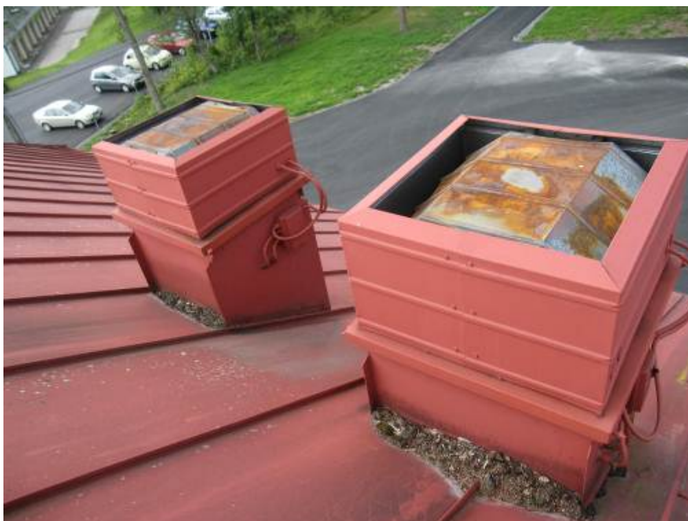
Kuva 34. Vanhan osan huippuimurit tarvitsevat ruosteenestomaalia.
