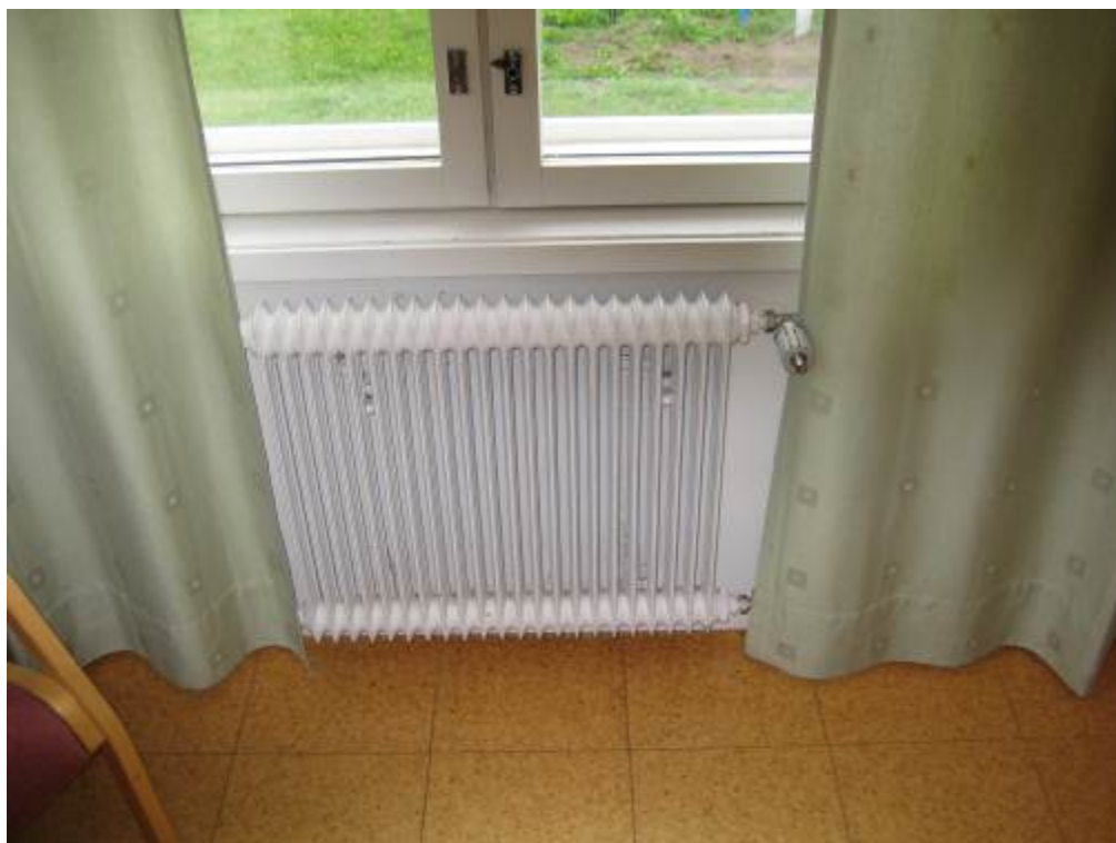
Kuva 21. Vanhan osan patteri ja elinkaarensa lopulla oleva termostaattinen patteriventtiili; uusittava tämän tarkastelujakson aikana.
