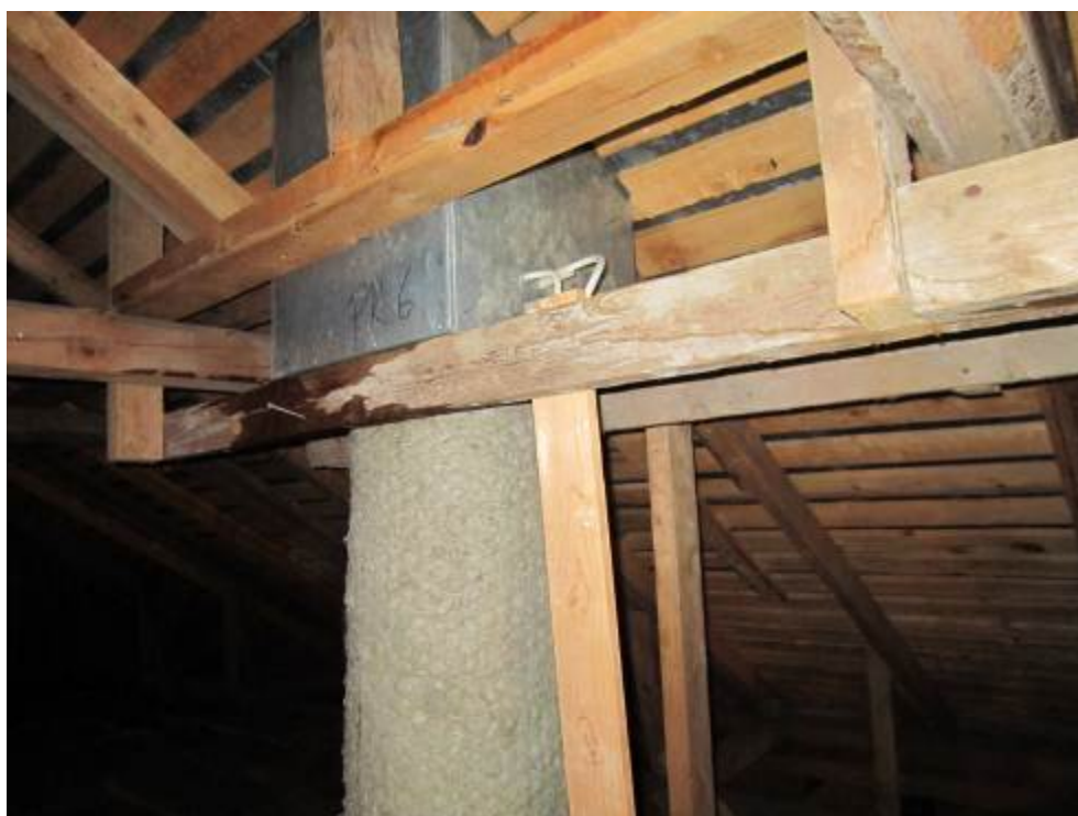
Kuva 12. PK 6 liitos kattoon vuotaa. Vuotokohdalla piippua kannatteleva puurakenne on märkä.
